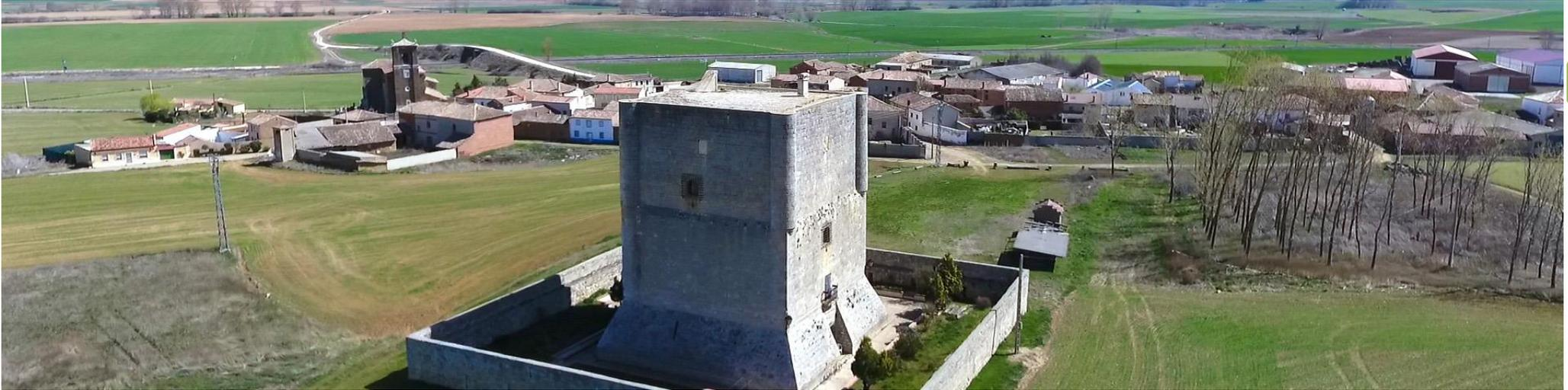
La torre, de planta cuadrada de 16 metros de lado, está construida con piedra sillar y consta de dos cuerpos, con un pequeño talud en la parte inferior. Cuenta con cuatro garitones en las esquinas que arrancan del inicio del cuerpo superior, en el que también aparecen en el centro de cada una de sus caras el escudo de armas de los Castañeda, quedando en la fachada Oeste únicamente el hueco del mismo.
