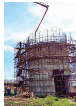
Construcción de la planta siderúrgica Mutún. ABI
