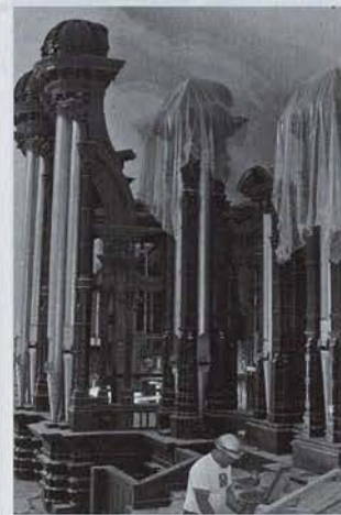
Um novo revestimento de metal dourado foi aplicado à parte visível dos tubos do órgão.
