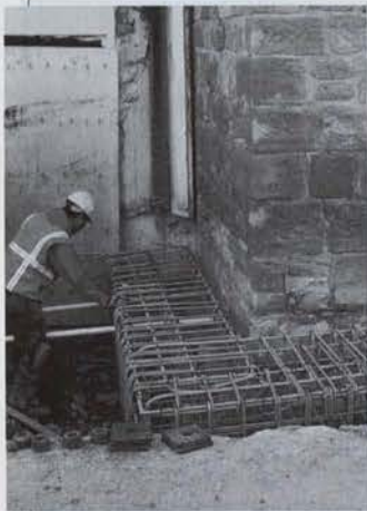
Um alicerce ainda mais firme faz parte da prevenção contra abalos sísmicos..
