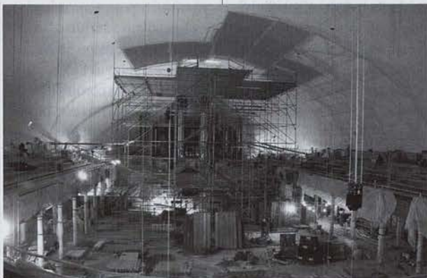
A reforma do interior do Tabernáculo incluiu reparos no teto, colocação de bancos novos e a criação de um púlpito removível e uma área que pode ser usada como palco.
