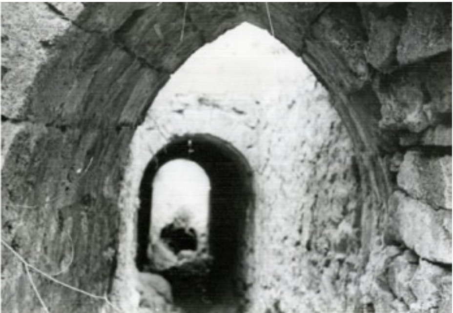
Bóveda del convento de San Fco. ( Foto: Aurelio Pretel Marín. Archivo IEA)
