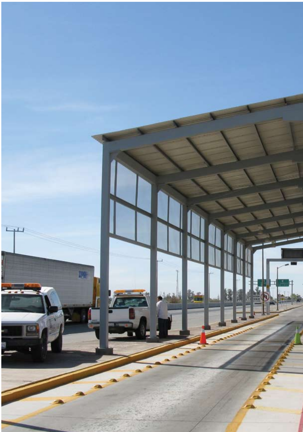
Centro fijo de verificación de Peso y Dimensiones, San Luis Río Colorado, Mexicali, B.C.
