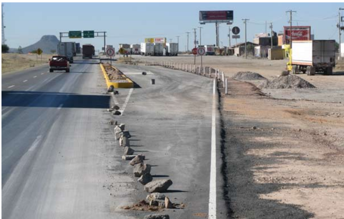
Construcción de plataforma de concreto, Ciudad Valles, S.L.P.
