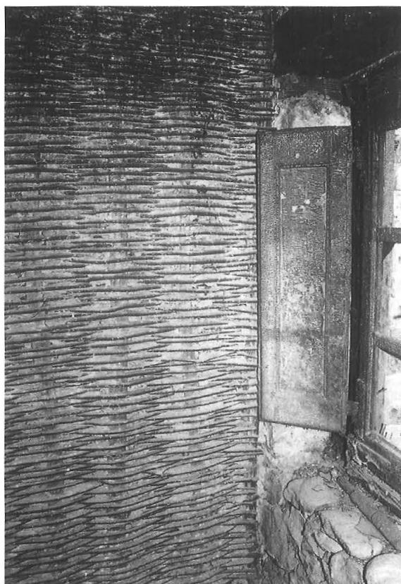
Fig. 157. Tabique de bardanasca . Carranza (B), 2003.
