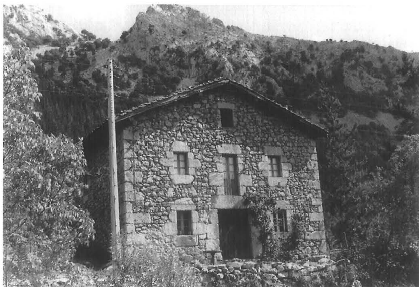
Fig. 131. Muros exteriores construidos con piedra. Caserío Baraia, Mañaria (B), 1970.
