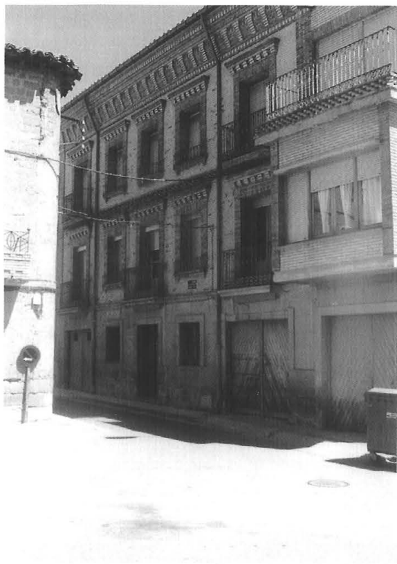
Fig. 143. Fachada de ladrillo. Murchante (N), 1997.
