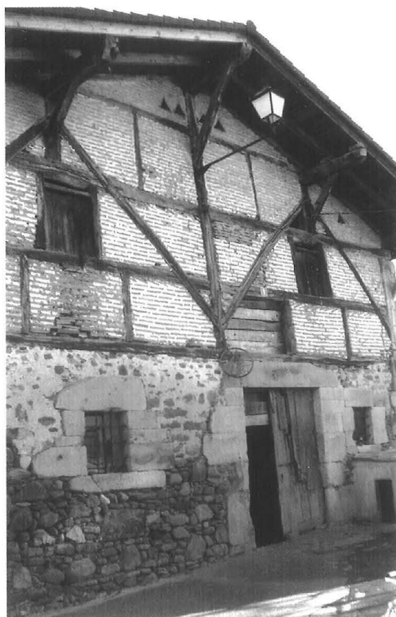
Fig. 141. Cerramiento de madera y ladrillo de Tejamana. Gaztelua auzoa, Abadiño (B), 2005.
