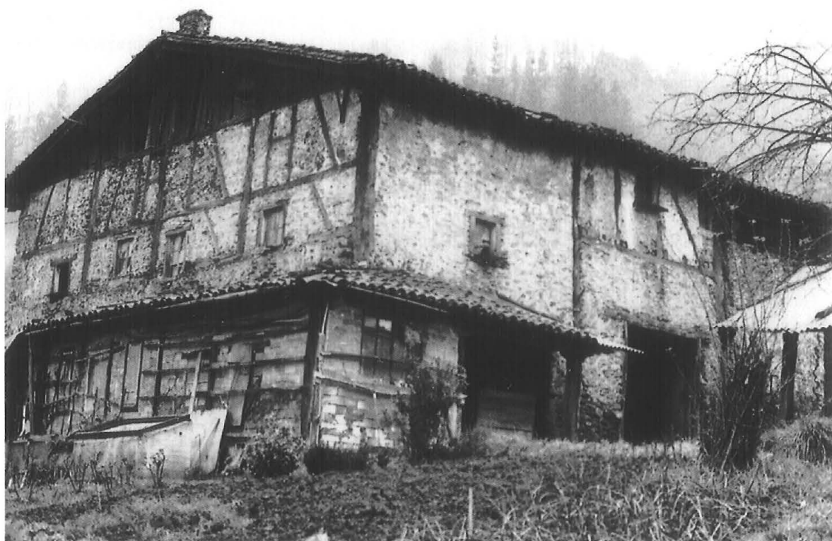
Fig. 139. Estructura externa de madera del caserío Agerrezabal. Beasain (G), 1980.
