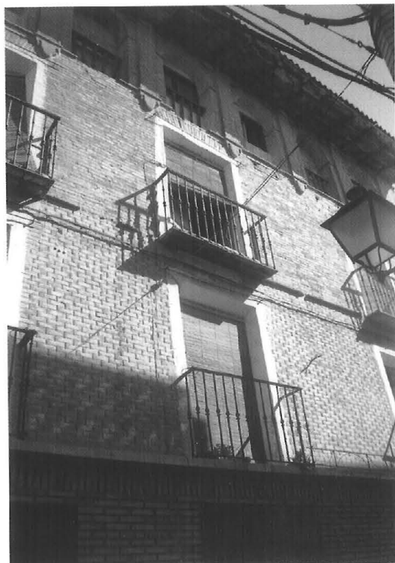
Fig. 137. Fachada de ladrillo de la Calle Mayor. Valtierra (N), 2001.
