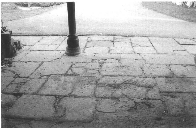
Fig. 159. Suelo enlosado en el portal. Ajuria (B), 2011.
