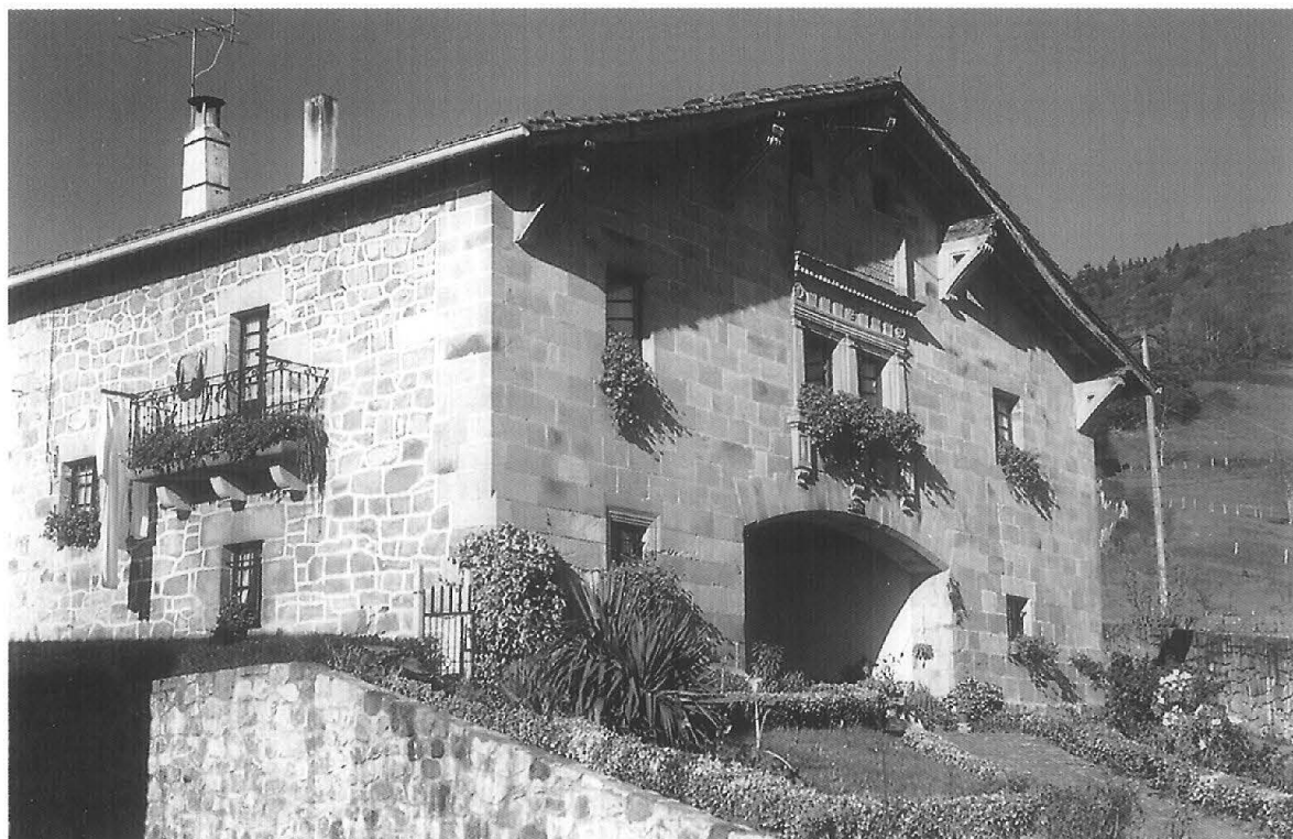
Fig. 142. Palacio Garatikoa construido en sillería. Garai (B), 1975.
