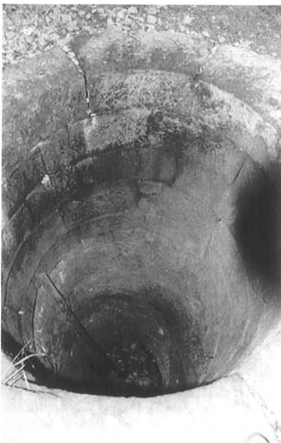
Fig. 170. Boca superior de carga de calero. Zeanuri (B), 2009.
