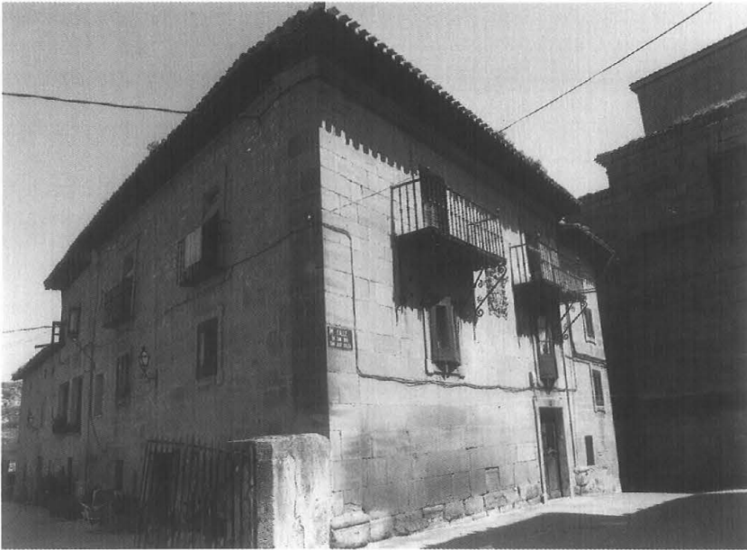
Fig. 132. Casa de sillería. Moreda (A), 1999.
