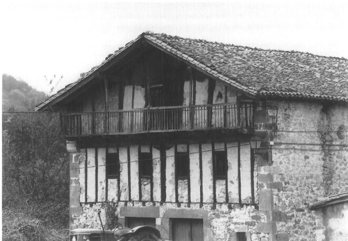
Fig. 140. Armazón de madera de Aldekozarra. Arraioz (Baztan-N), 1999.
