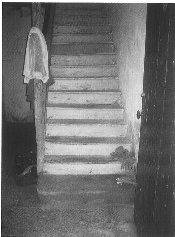
Fig. 164. Escalera de madera con el primer peldaño de piedra. Ajuria (B), 2011.
