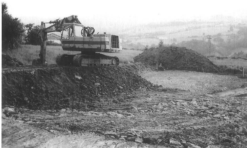
Fig. 129. Excavación para construcción de casa nueva. Carranza (B), 1998.
