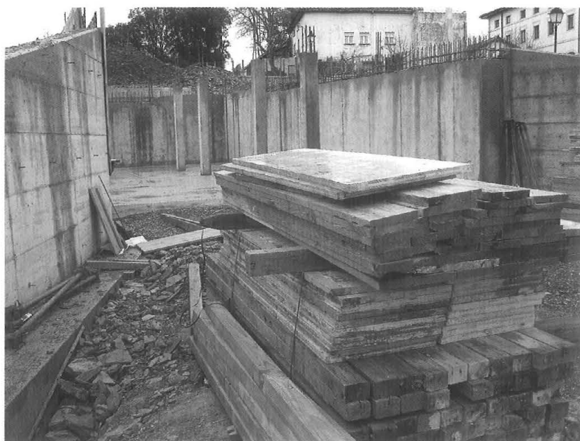
Fig. 130. Cimentación de una casa actual. Mendata (B), 2011.
