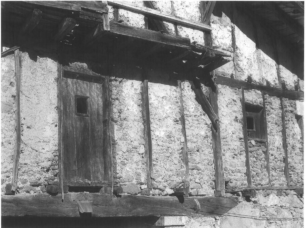
Fig. 144. Fachada con el mortero a la vista. Nabarniz (B), 2011.
