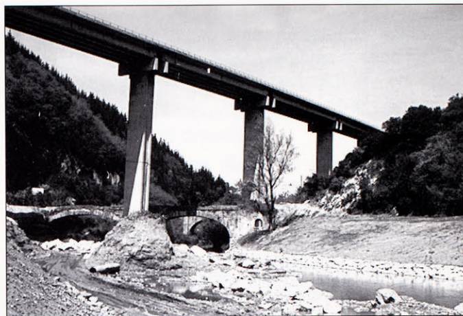
Obras junto al puente de Sasiola (Foto: P. Aldabaldetrecu)
