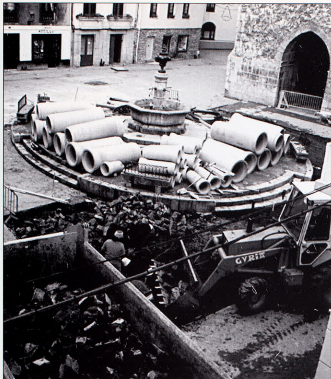
Desmantelamiento de los adoquines de la Plaza Vieja. (Primavera 1.991)
