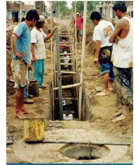
En general, debido a las profundidades mínimas de instalación de redes y ramales condominiales, no se requiere el **ademado de zanjas**. Sin embargo, el proyectista deberá tomar las previsiones correspondientes e incrementar el ancho de zanja de acuerdo con las características del terreno y la presencia del nivel freático.
