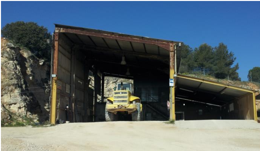
Figura 8. Detalle de la nave taller
