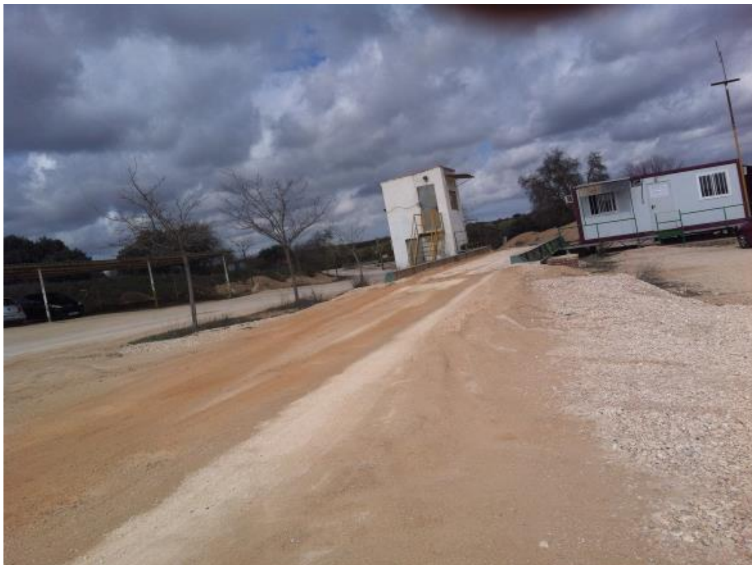
Figura 9. Imagen del acceso al recinto con casetas de báscula (centro), laboratorio (dcha.) y aparcamiento (izda.)
