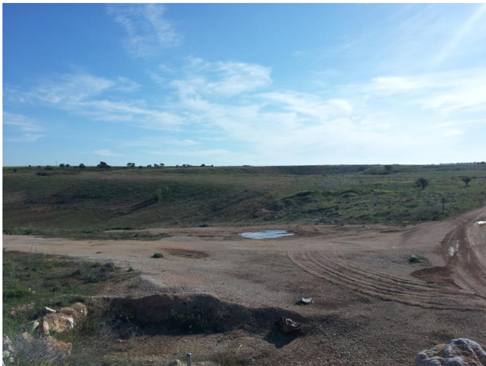
Figura 23. Detalle de los frentes 2 y 3 restaurados
