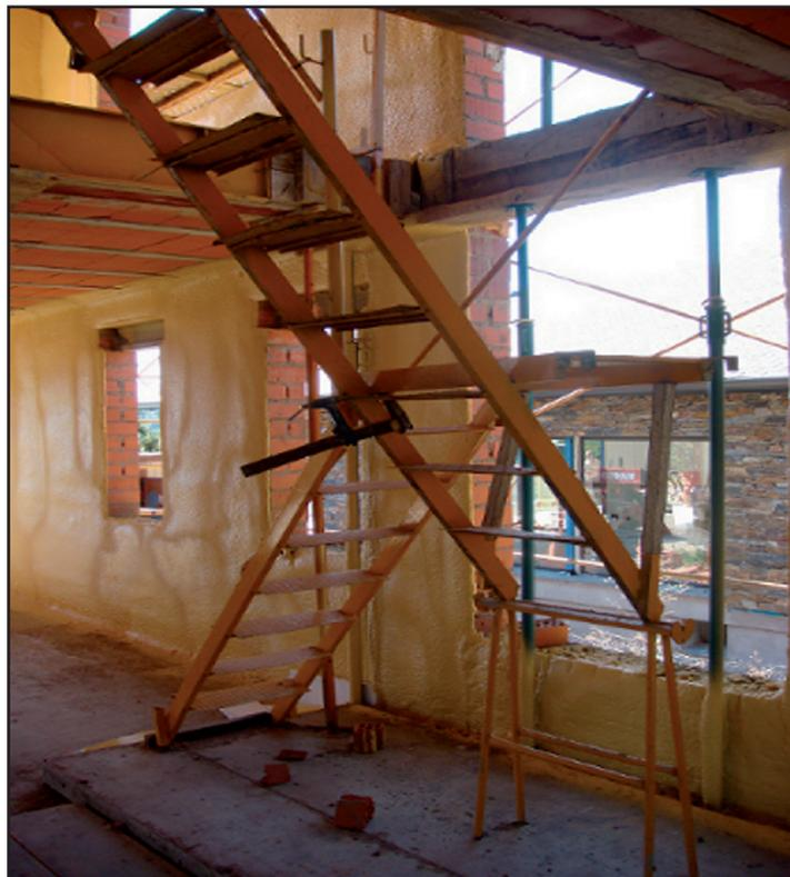
Con la idea de iniciar una nueva sección de “Anecdótico y Cosas Curiosas”, se adjunta una fotografía de una escalera de obra, curiosa por la unión de sus tramos mediante “un gato” así como por su apoyo sobre “una borriqueta” que está casi cerrada. ¡Eso sí, el contratista se siente orgulloso porque ha instalado una escalera de obra para que la D.F. acceda con facilidad a la planta alta.!
