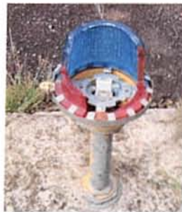
Daños en las 3 luces de borde final de pista – Cabecera 02
