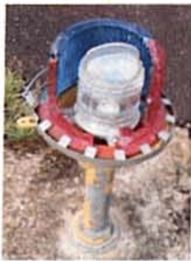
Daños en las 3 luces de borde final de pista – Cabecera 02
