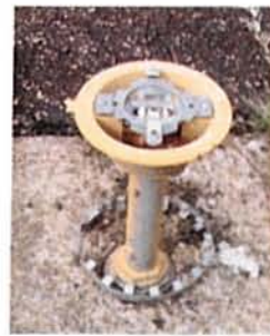
Daños en las 3 luces de borde final de pista – Cabecera 02
