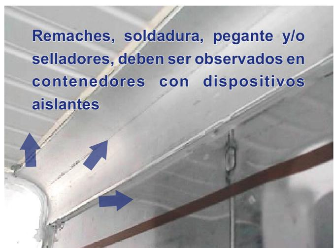
Mientras se camina interiormente a lo largo del contenedor, se podrán observar desniveles tanto en el techo como en el piso. Recuerde que siempre deben estar visibles las vigas de la estructura del contenedor. Otra buena acción es medir con metro o con un patrón a lo largo de todo el contenedor. La observación de las vigas podrá determinar igualmente desniveles. Recuerde que las medidas son estandarizadas.
