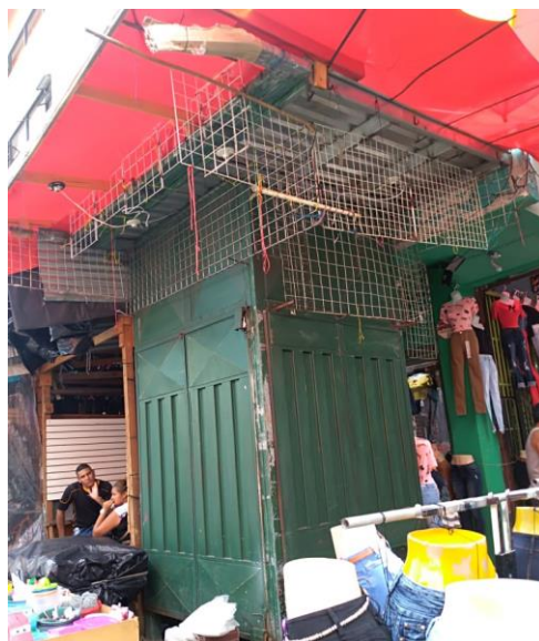
Figura 6: Comercio estabelecido, estrutura de metal
