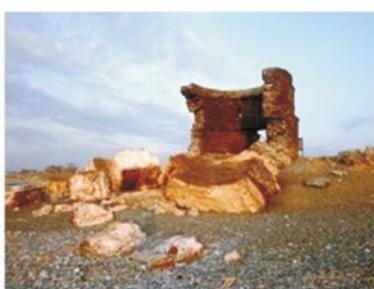
La estructura de la Torre de Luna se desplazó en 2007 al descalzarse su cimentación por acción del mar.
