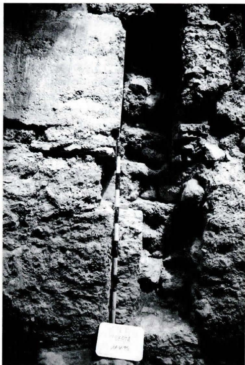
FIGURA 10. Castillo de Planes. Puerta. Detalle de la guía del tablacho tapiador, situado al final del sistema de acceso.
