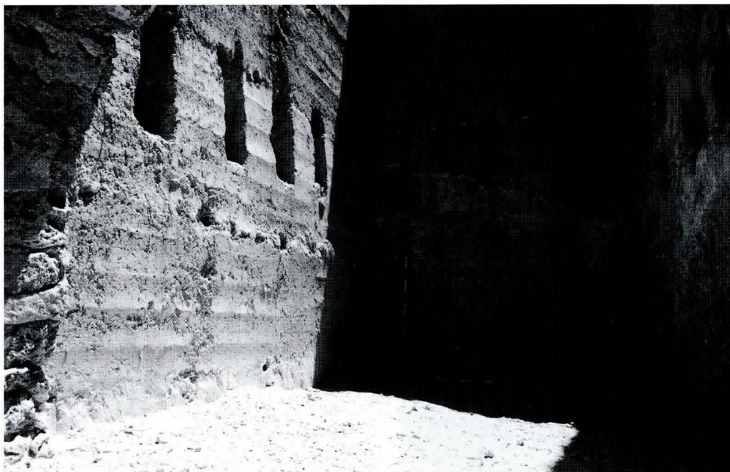
FIGURA 6: Castillo de Planes. Puerta. Detalle del arranque de las cubiertas del piso superior de la torre 1 sobre las dos primeras puertas del sistema.
