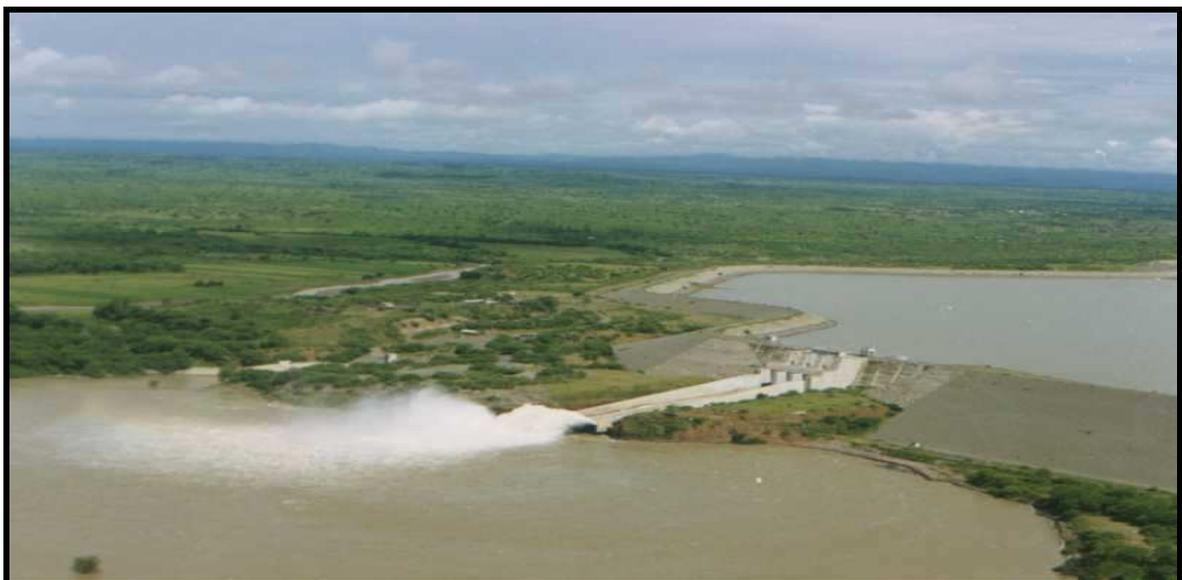
Fig. 5. Fotografía que muestra el Aliviadero de la Presa de Poechos durante su operación. Obsérvese el efecto del Salto de Esquí.
