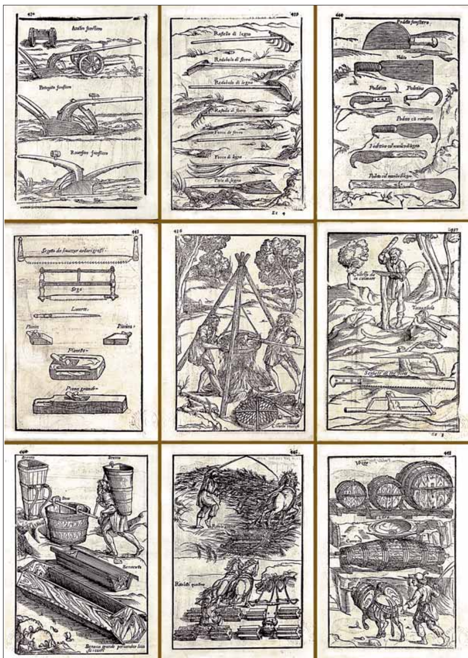
16.11. Máquinas, herramientas y actividades de la industria rural en el Renacimiento: (1) Arados; (2) Rastrillos y horcas de madera y hierro; (3) Instrumentos para la poda y la realización de esquejes; (4) Equipo de carpintero. Tan importantes como los trabajos directamente relacionados con el cultivo, lo eran aquellos relacionados con las industrias complementarias; (5) Cribas; (6) Herramientas de corte; (7) Recipientes para transporte de líquidos y áridos; (8) Trillos; (9) Diferentes tipos de botas para contener vino. (Agostino Gallo: Le venti giornate dell'agricoltura, Venecia, 1622). (Bibl. de Catalunya).
