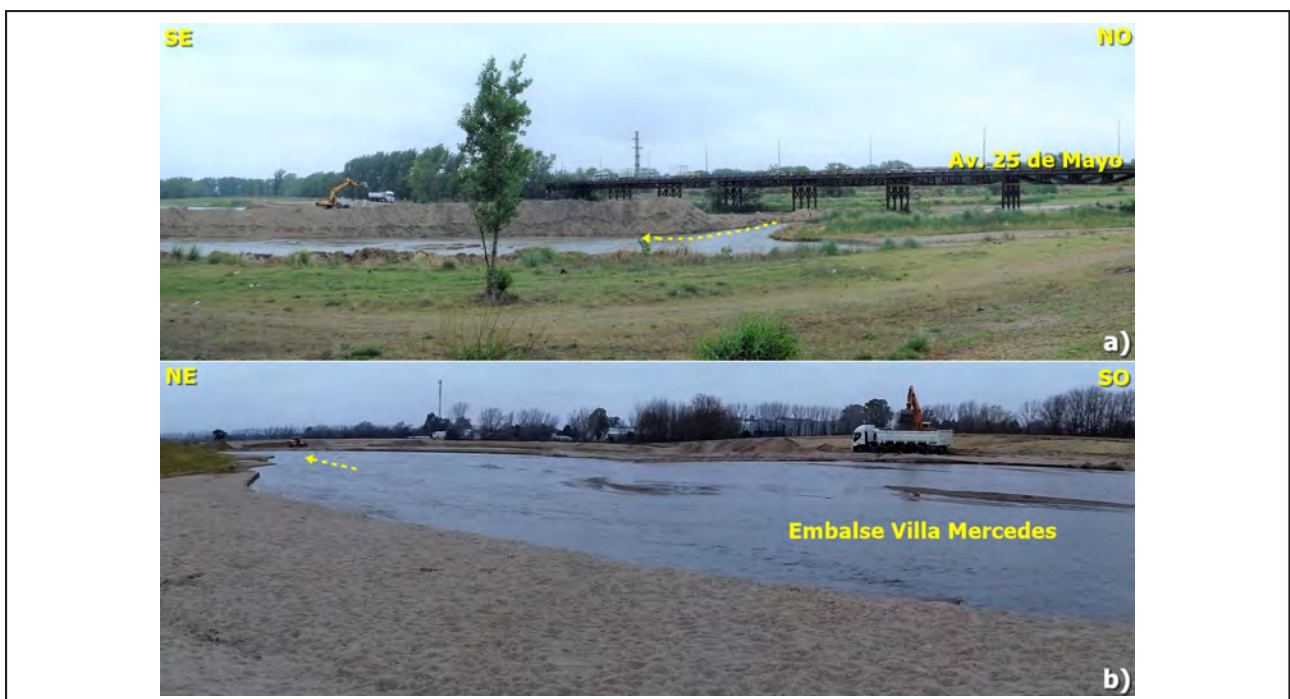
Figura 6. a) Extracción de áridos (octubre 2019). b) Dragado del embalse (julio 2018).
