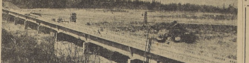
OBRA DEL PUENTE SOBRE EL MAIPO
