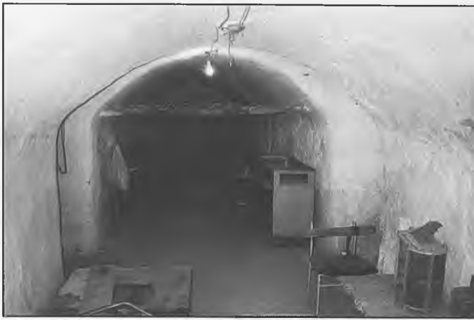
Mazmorras, en semisótano, del castillo
