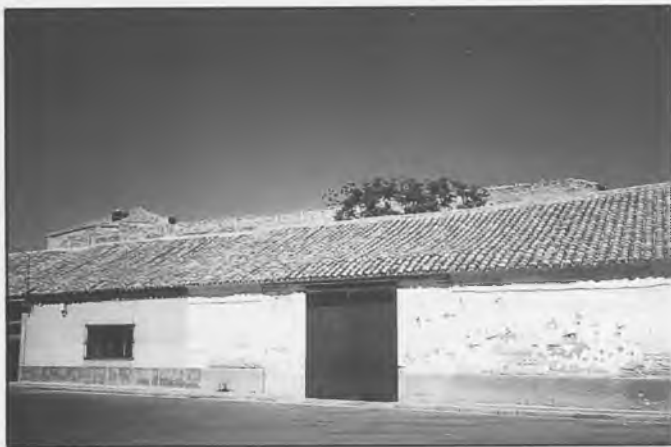
Calle Villarreal, al fondo apreciamos un lateral del castillo
