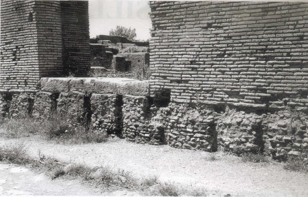
**Cimientos de la Casa del Dipinti en Ostia, que muestran las huellas de los montantes del encofrado (Siglo II), utilizado para edificios cuya elevación es de mampostería o de sillar.**
