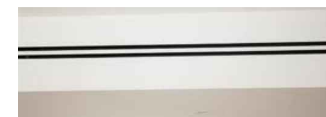
Detalle de rejillas de aire acondicionado Lineal
