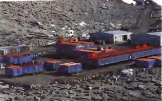
Visione d'insieme sulla struttura prefabbricata che costituisce la base italiana in Antartide a Base Terra Nova
