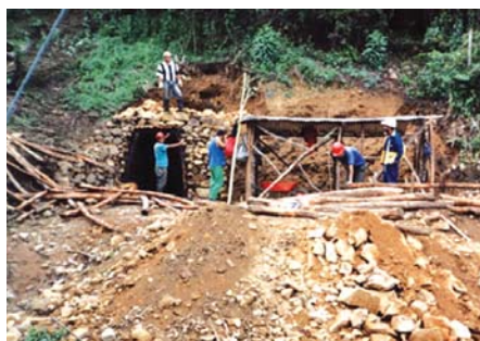
Foto 3: Mina El cisne – Trabajos de apertura de un túnel – Foto, Gobernación de Nariño
