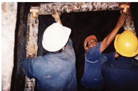
Foto 2: Mina La Palmera – trabajos de sostenimiento - Foto, Gobernación de Nariño
