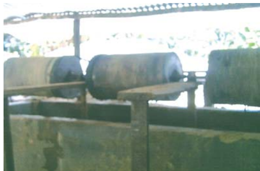
Foto 16: Mina Tapada, - Tambo - Cauca, barriles, tambores o molinos amalgamadores. Foto Corponariño 2005
