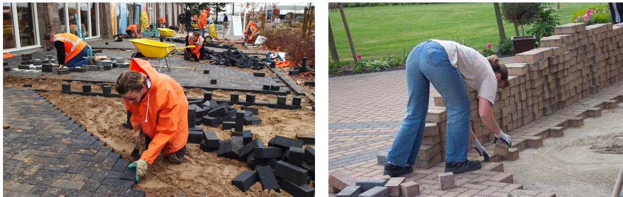
Figura 1. Pavimentación manual, según de método tradicional holandés, (izquierda) y colocación manual (derecha).
