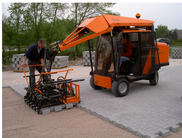
Figura 3. Ejemplos de máquinas para colocación mecánica de elementos para pavimentación.
