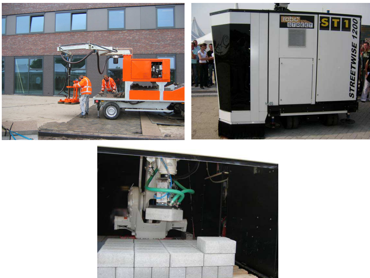
Figura 4. Máquinas adoquinadoras “Paving Stone Layer” (izquierda) y “Streetwiste 1200” (centro y derecha).
