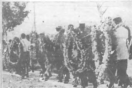
El pueblo, en caravanas interminables, deposita coronas de flores sobre las ruinas de una casa destruida por la metralla mercenaria.
