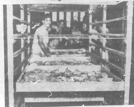
8.—Ya lavado, escamado, limpio y listo para comer el pescado se coloca en grandes bandejas de aluminio que van montadas sobre carros especiales que lo transportarán al túnel o nevera de congelación.
