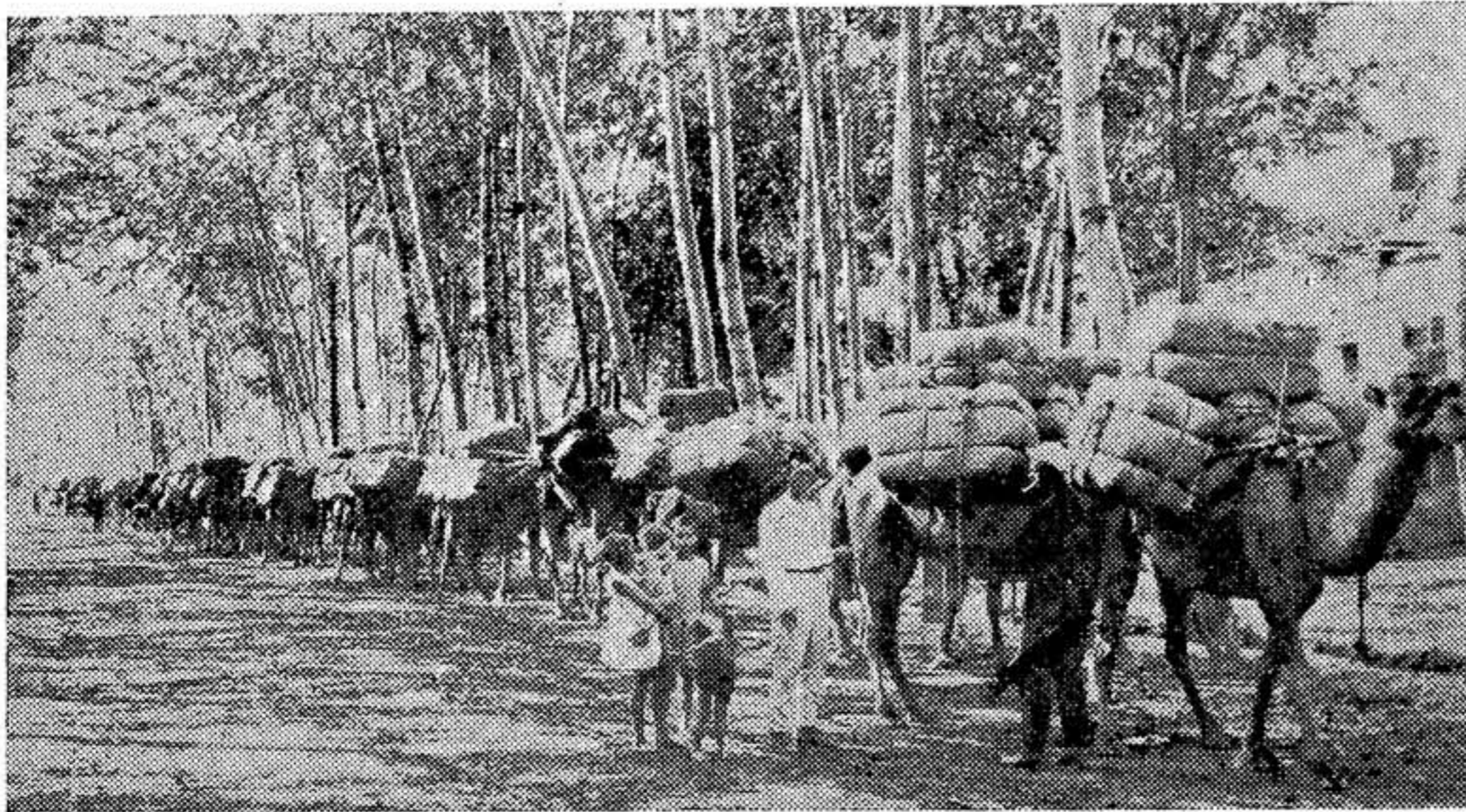
Una caravana de camellos de Kashiar, Turquestán chino, transportando los pertrechos hacia China, después de haber vencido distancias que oscilan entre los 3000 y los 3500 kilómetros y rebasar alturas de más de 3500 metros en el Techo del Mundo.
