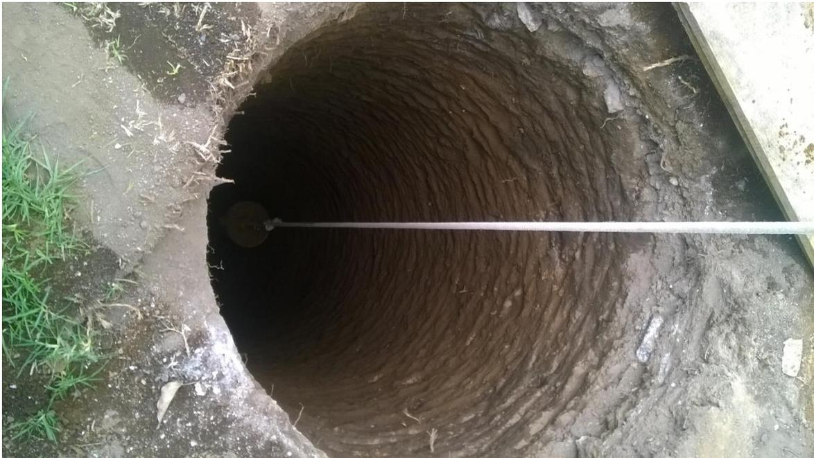
*Excavación del pozo de absorción, avance en el momento de la foto, aproximadamente 15 mts de profundidad*
