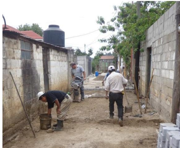
*Izquierda: Inicio de pozo de absorción. Derecha: Instalación de adoquín y compactado de base de selecto*
