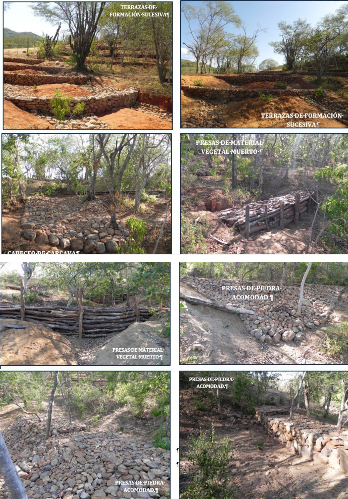
Figura 1 Ejemplos de obras de conservación de suelo y agua.
