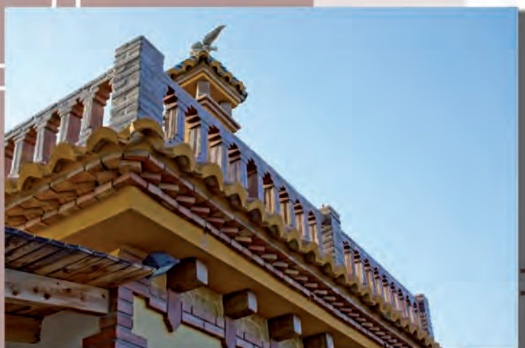
Balaustrada de Ladrillo Rústico
