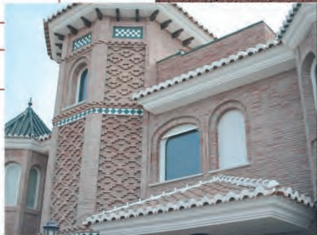
Torre revestida de ladrillo rústico de 25 x 12 cm.
