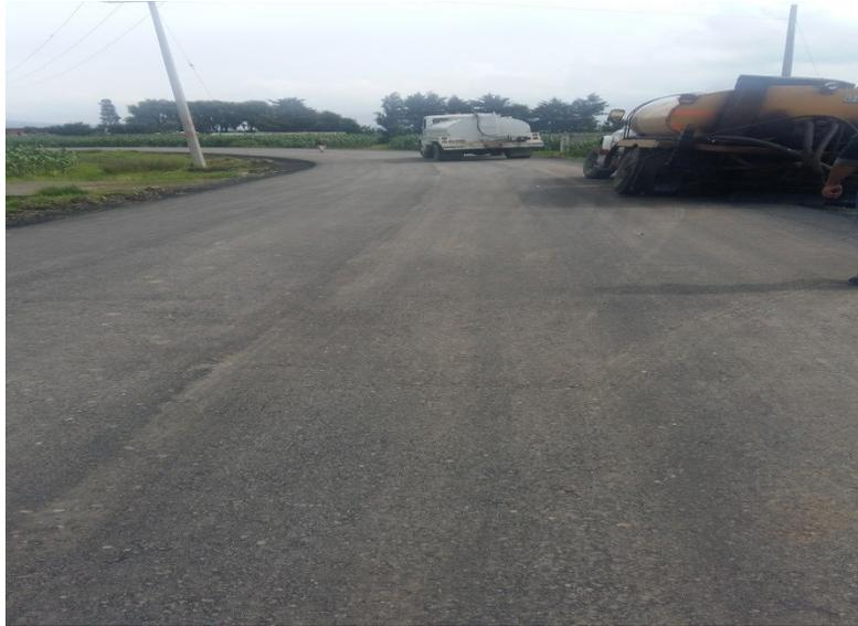
*Figura 17. Tendido de carpeta asfáltica de 7cm de espesor, elaboración propia como residente*
