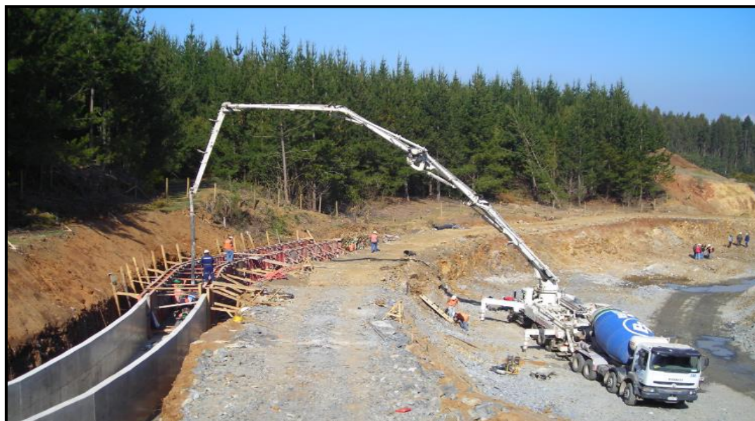
Figura B1. Instalación de mortero transportado por camión mixer a través de bomba pluma Fuente: Fotografía de talud perteneciente a By-Pass Penco - Lirquén, Sector Penco
