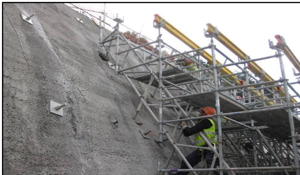
Figura B2. Implementación de andamios articulados en recubrimiento de taludes
