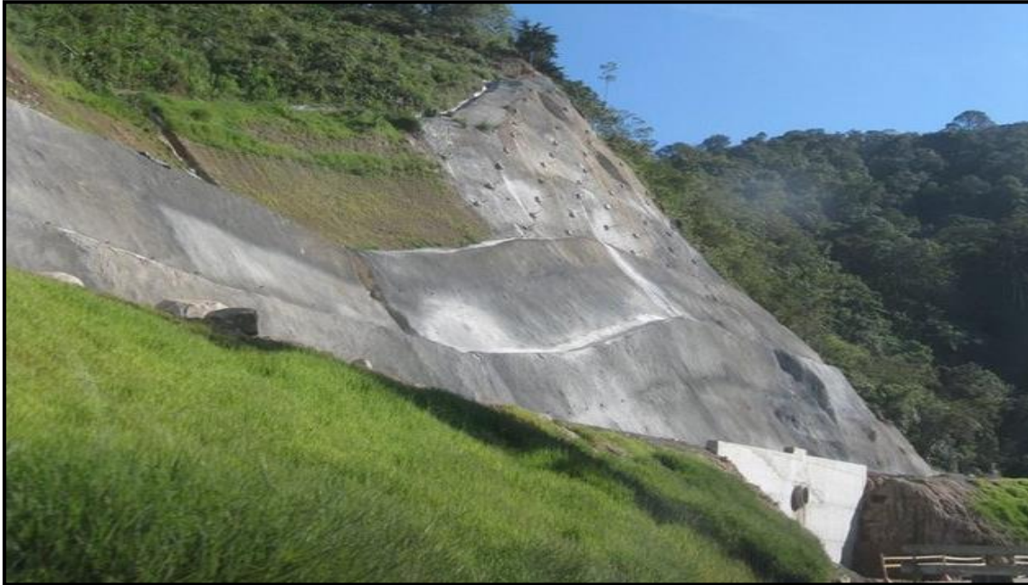
Figura N°4. Aplicación de hormigón proyectado tanto en terrazas y talud
