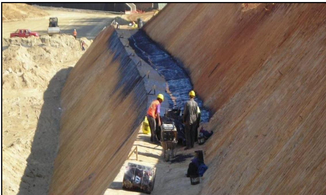
Figura A11. Aplicación de asfalto cortado en caliente, con la ayuda de máquina regadora de asfalto Fuente: Fotografía de talud perteneciente a By-Pass Penco - Lirquén, Sector Penco
