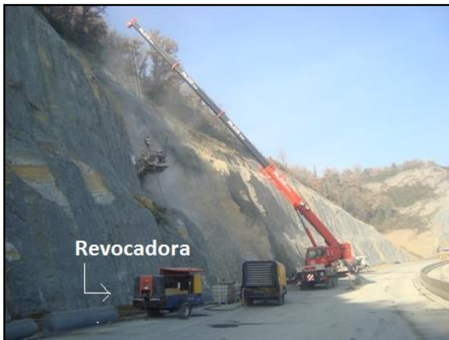
Figura A8. Recubrimiento de talud con hormigón proyectado mediante revocadora
