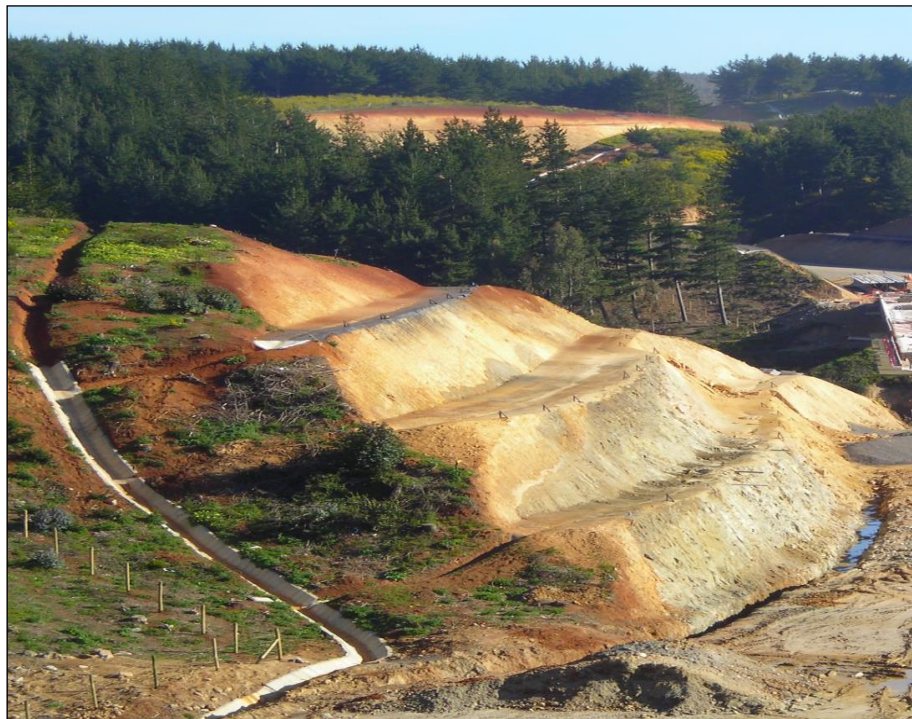
Figura N°1: Fotografía de un talud en construcción
