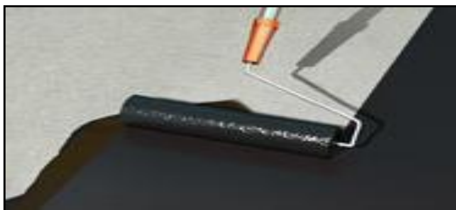
Figura B4. Aplicación con impermeabilizante denso
