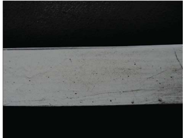
Barandas de metal |
