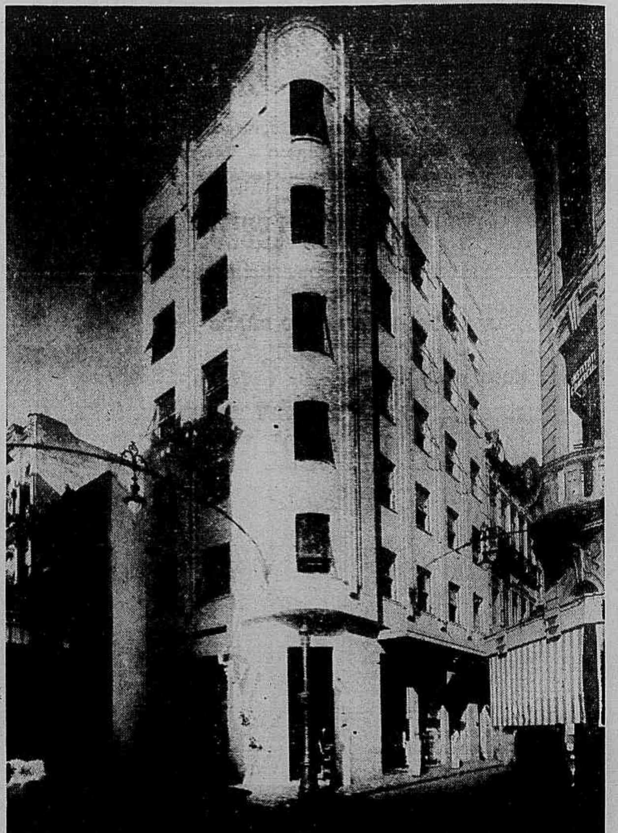
Projecto e construção de Oliveira Lima & Cia. Ltda. — Obra : Rua Gonçalves Dias, esq. de Rosario.
