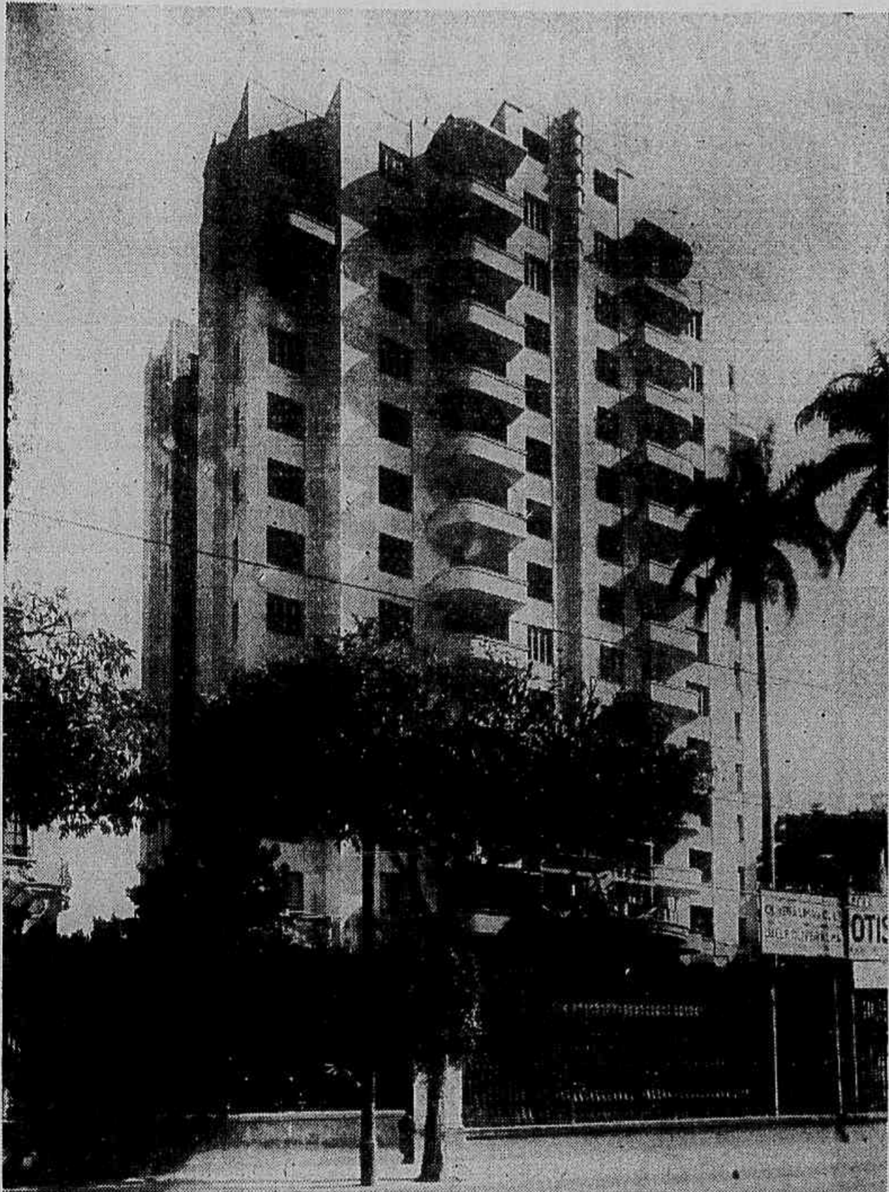
Projecto e construção de Oliveira Lima & Cia. Ltda. — Obra : Rua Senador Vergueiro, 92.
