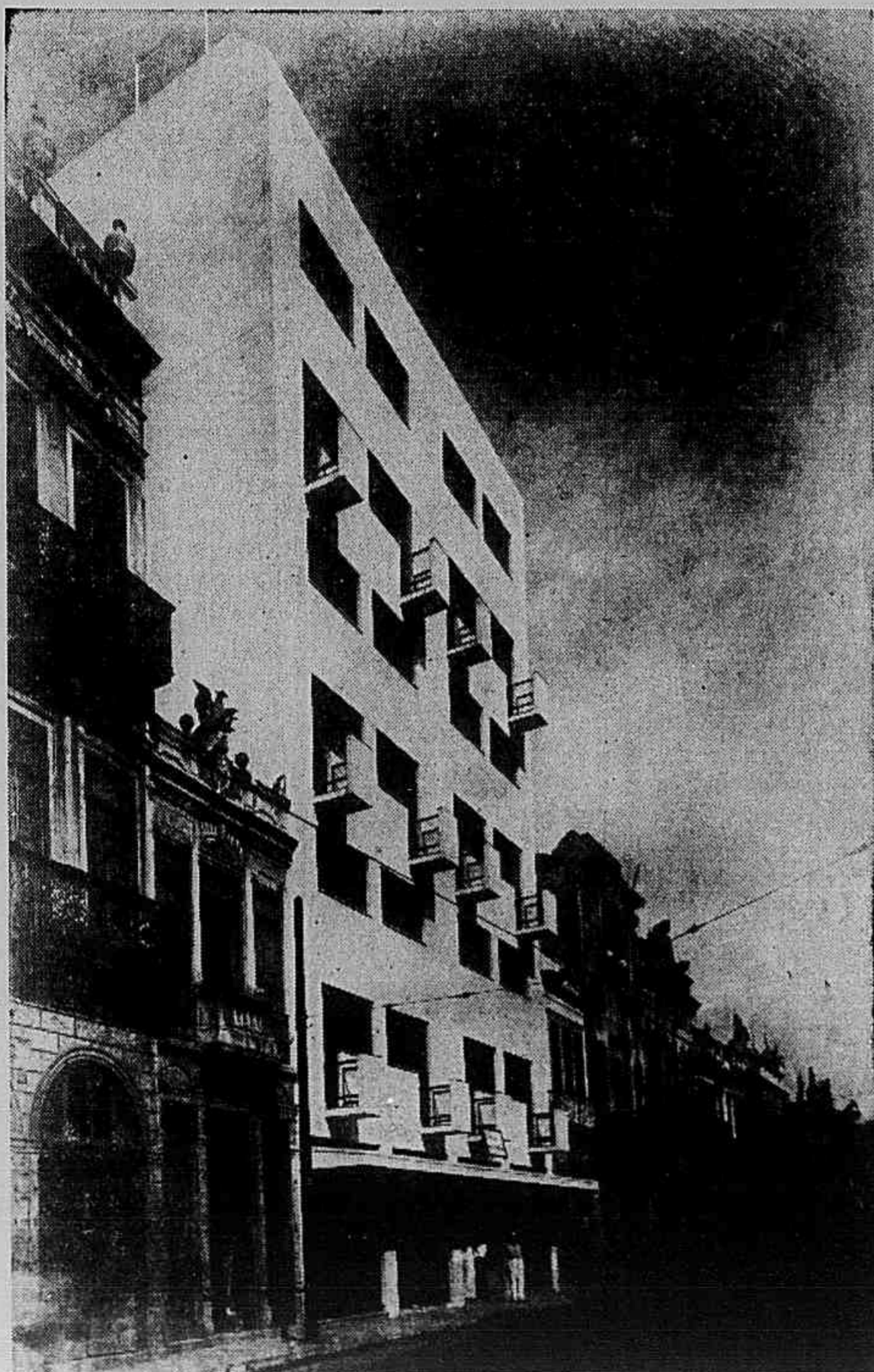
Construção de Oliveira Lima & Cia. Ltda. — Obra : Rua do Lavradio, 106.
