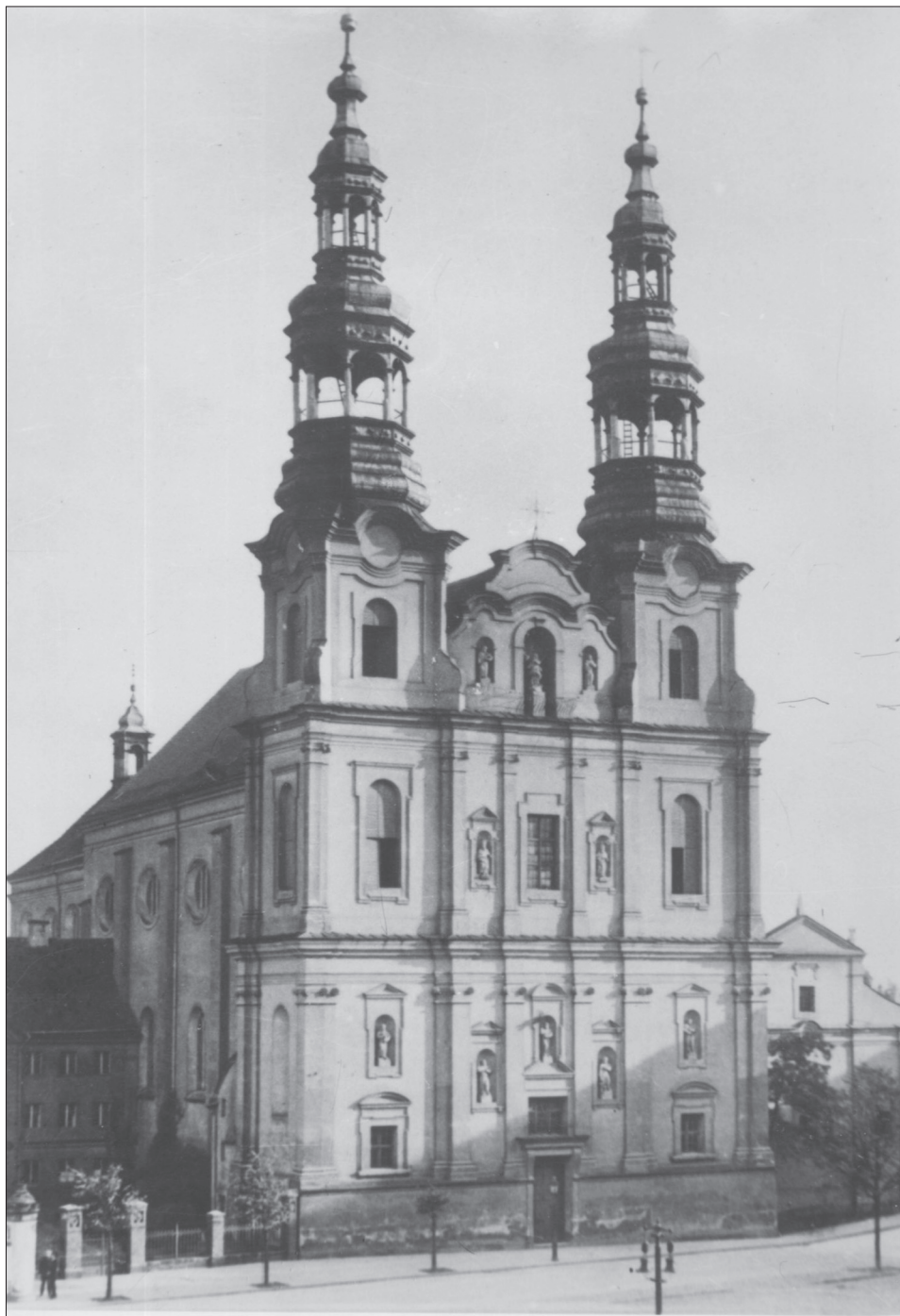
Fasada kościoła i helmy wieżowe. Fot. sprzed 1939 wykonał Ulatowski
