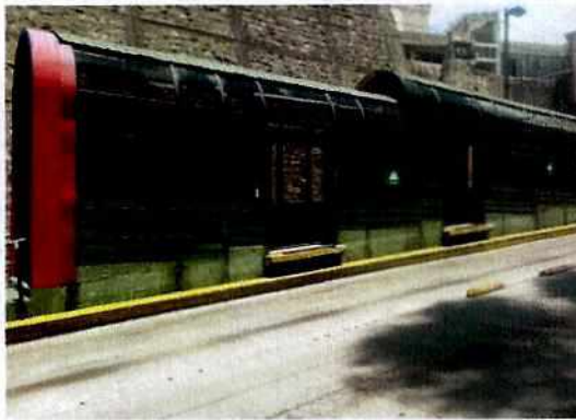
Sin implementación ornamental y aporte a la imagen urbana
