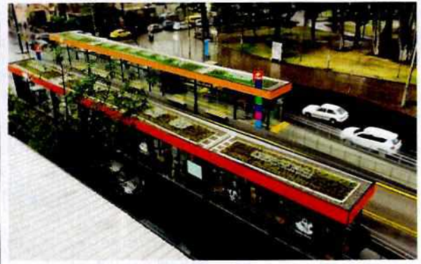
Cubiertas aportan a la sensación térmica interna e imagen urbana
