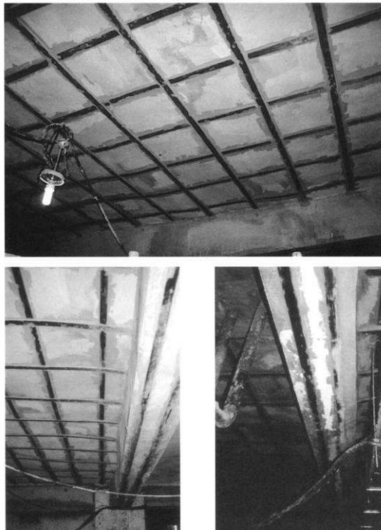
Es una solución eficaz, cómoda, rápida y económica, interesante para refuerzos de piezas que trabajen a flexión y a cortante. Para ello es importante la preparación de superficies, por ejemplo mediante limpieza con chorro de arena. Se requiere la planeidad de las superficies de contacto. Además, hay que vigilar el espesor de la capa de adhesivo, que suele tener aproximadamente 1 mm, así como proteger el refuerzo contra incendios.
