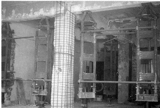
Existe otro tipo de refuerzo de hormigón que consiste en mejorar las características resistentes del material existente en la pieza comprimida mediante zunchado; el cálculo de estos elementos se recoge en la Instrucción EHE, siendo en general condicionante la geometría del elemento y las altas cuantías de armadura transversal. En algunos
