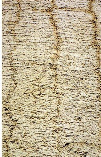
Fisuras de retracción hidráulica por insuficiente curado
