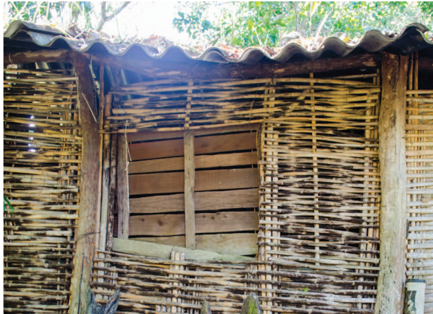
Figura 7. Ventana ubicada en la zona de montaña. Fuente: A. Flores, Colima, México, 2016.
