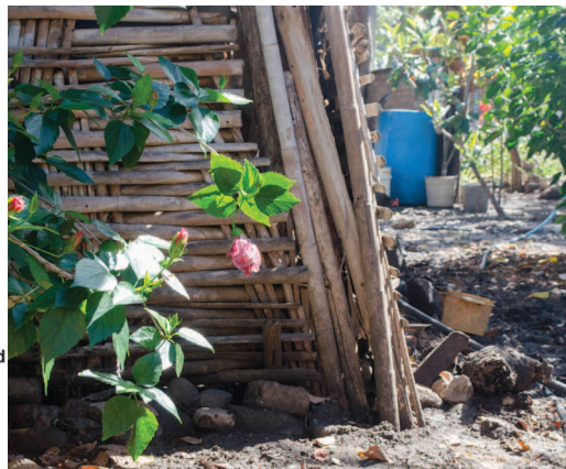
Figura 2. Estructura vertical hincada en el terreno. Fuente: A. Flores, Colima, México, 2016.
