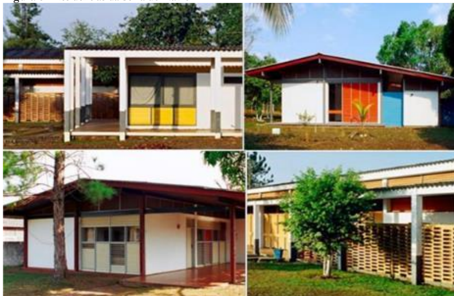
Figura 8 - Residências da Serra do Navio
