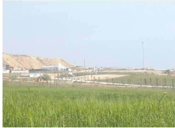
İnşaatı süren Karabiga Termik Santrali
