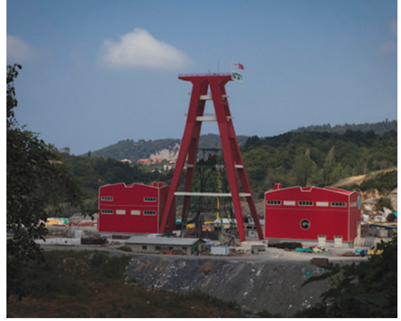
Hattat Holding'in inşaatı devam eden kömür madeni
