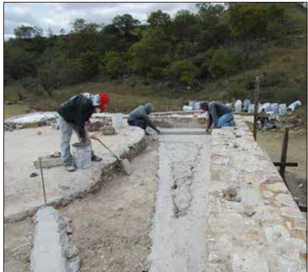
Templo del Edificio 16. Costado norte y oeste. Integración de matiz al piso de estuco como acabado final / Foto: Archivo Técnico Proyecto de Conservación de los Edificios Dañados por los Sismos de 2017 en Monte Albán-Atzompa.
