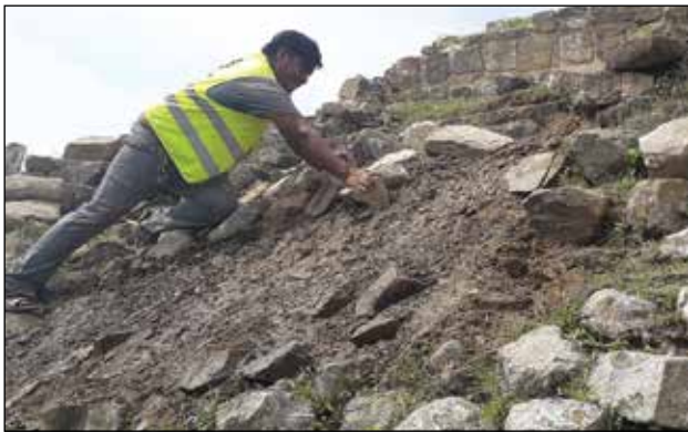
Colocación de núcleos, sellos y resanes de estuco en el segundo cuerpo del Edificio P, lado norte / Archivo Técnico Proyecto de Conservación de los Edificios Dañados por los Sismos de 2017 en Monte Albán-Atzompa.
