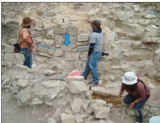
Imagen que indica una grieta sísmica en el muro de desplante del Edificio P. Frente a este muro fue colocado un muro contrafuerte de piedras y lodo, además de ampliarse las dimensiones que el edificio tuvo en la época prehispánica / Archivo Técnico Proyecto Conservación de los Edificios Dañados por los Sismos de 2017 en Monte Albán-Atzompa.
