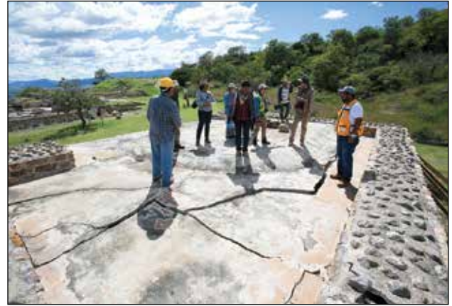
Conjunto Monumental de Atzompa. Acciones emergentes: evaluación de daños en el Templo, Edificio 16 / Foto: Fidel Ugarte, INAH.
