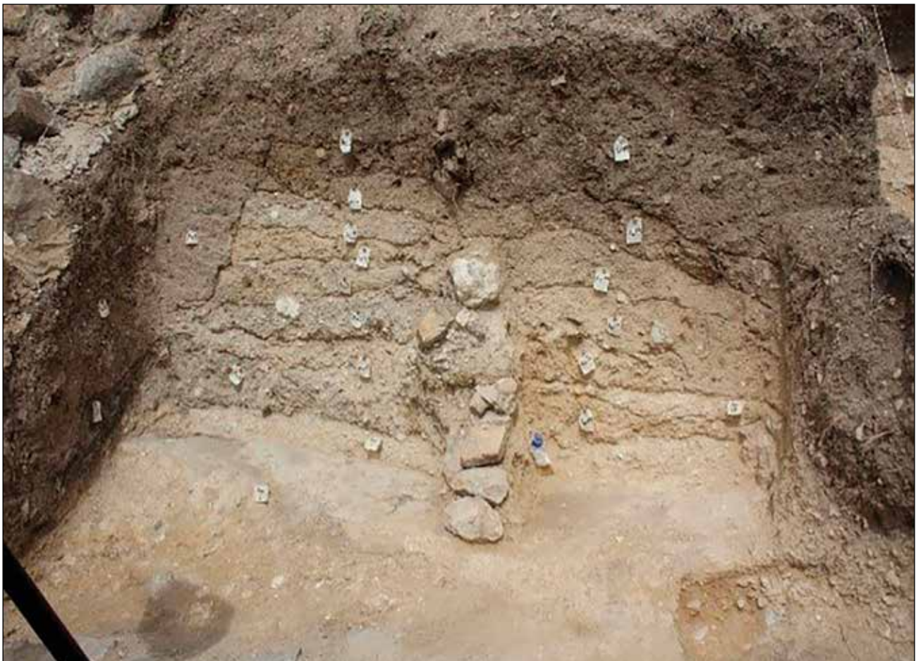
Vista de dos bloques de modelado en la cala 14, cuadro N16E10. Se aprecian las rocas de mala calidad que son empleadas para delimitar los vaciados de barro que se distinguen en capas de distintas proporciones / Foto: Archivo Técnico Proyecto Conservación de los Edificios Dañados por los Sismos de 2017 en Monte Albán-Atzompa.
