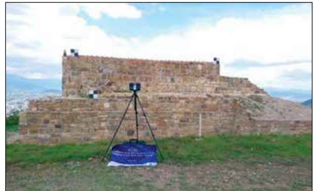
Registro 3D. Edificio 16. Lado poniente / Foto: Archivo Técnico Proyecto de Conservación de los Edificios Dañados por los Sismos de 2017 en Monte Albán-Atzompa.
