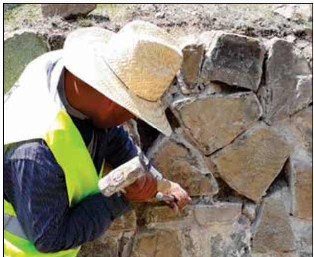
Limpieza y liberación de juntas constructivas / Foto: Archivo Técnico Proyecto de Conservación de los Edificios Dañados por los Sismos de 2017 en Monte Albán-Atzompa.
