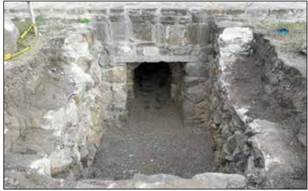
Registro 3d de la tumba y registro fotográfico después del resane y sellado de juntas de los muros internos y externos / Foto: Archivo Técnico Proyecto de Conservación de los Edificios Dañados por los Sismos de 2017 en Monte Albán-Atzompa.
