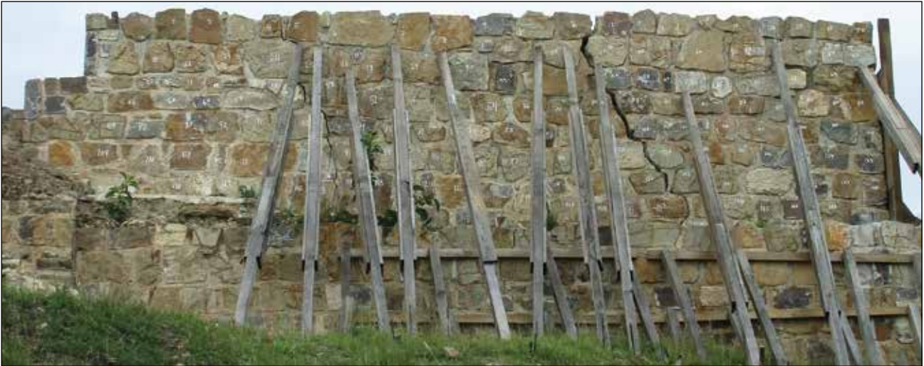
Colocación de apuntalamiento en el Edificio 16 de Atzompa / Archivo Técnico Proyecto Conservación de los Edificios Dañados por los Sismos de 2017 en Monte Albán-Atzompa.
