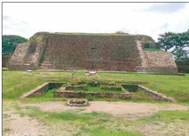
Adoratorio. Pocisionamiento de scanner FARO 3D, vista al este / Foto: Archivo Técnico Proyecto de Conservación de los Edificios Dañados por los Sismos de 2017 en Monte Albán-Atzompa.
