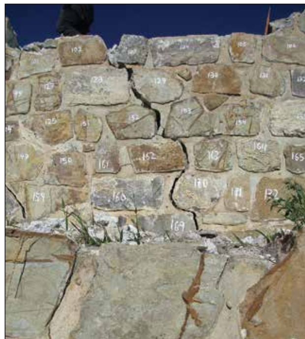
Fachada oriente del Edificio 16. Grietas con separación de elementos en muro de primer y segundo cuerpo, lado oriente / Foto: Archivo Técnico Proyecto de Conservación de los Edificios Dañados por los Sismos de 2017 en Monte Albán-Atzompa.
