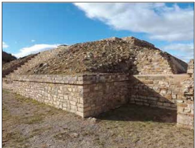
Vista general del Edificio 6. Registro fotográfico al final de las intervenciones / Foto: Archivo Técnico Proyecto de Conservación de los Edificios Dañados por los Sismos de 2017 en Monte Albán-Atzompa.
