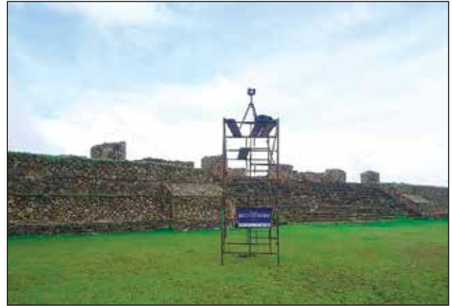
Componente 2. Patio hundido lado sur. Toma de imagen 3D / Foto: Archivo Técnico Proyecto de Conservación de los Edificios Dañados por los Sismos de 2017 en Monte Albán-Atzompa.
