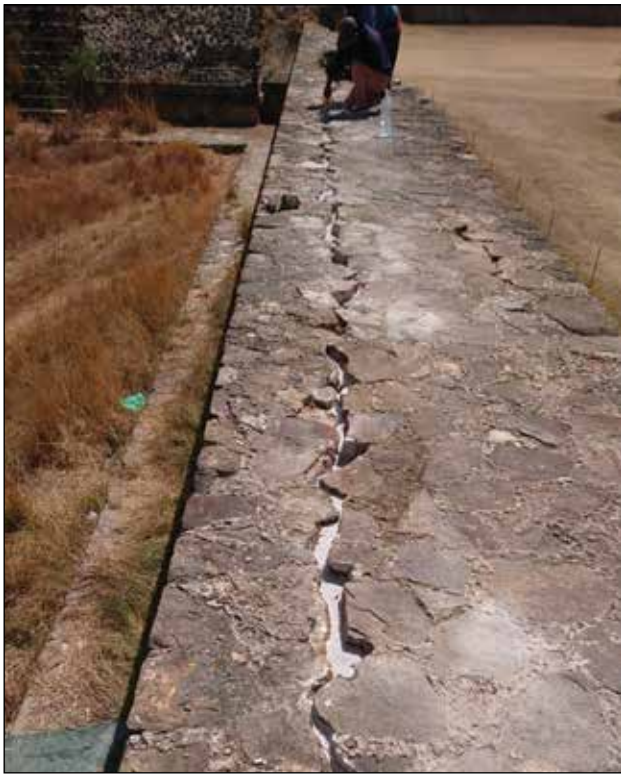
Templo del Edificio IV. Muro perimetral sur del patio abierto. Consolidación de elementos dañados / Foto: Archivo Técnico Proyecto de Conservación de los Edificios Dañados por los Sismos de 2017 en Monte Albán-Atzompa.
