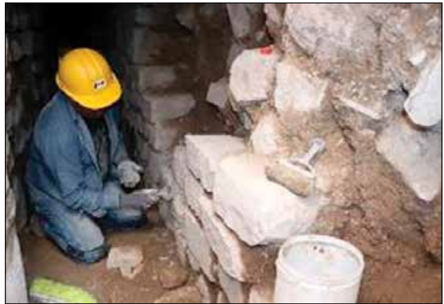
Reintegración y consolidación de muros del desagüe oeste / Foto: Archivo Técnico Proyecto de Conservación de los Edificios Dañados por los Sismos de 2017 en Monte Albán-Atzompa.
