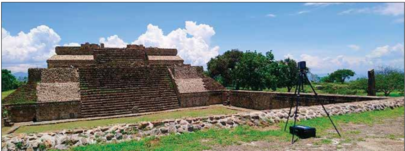
Sistema IV. Fachada este, toma a nivel de 6 a 8 metros / Foto: Archivo Técnico Proyecto de Conservación de los Edificios Dañados por los Sismos de 2017 en Monte Albán-Atzompa.
