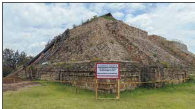
Acordonamiento del Edificio A durante las exploraciones arqueológicas / Foto: Archivo Técnico Proyecto Sismos, ZAMA 2017.
