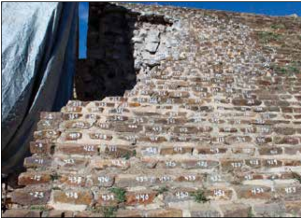
Markado de piedras con agua de cal para el proceso de restauración / Foto: Archivo Técnico Proyecto de Conservación de los Edificios Dañados por los Sismos de 2017 en Monte Albán-Atzompa.
