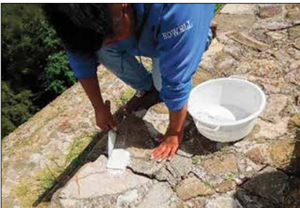
Colocación de sellos de cal para registro y monitoreo de movimiento del edificio / Foto: Archivo Técnico ZAMA, 2019.
