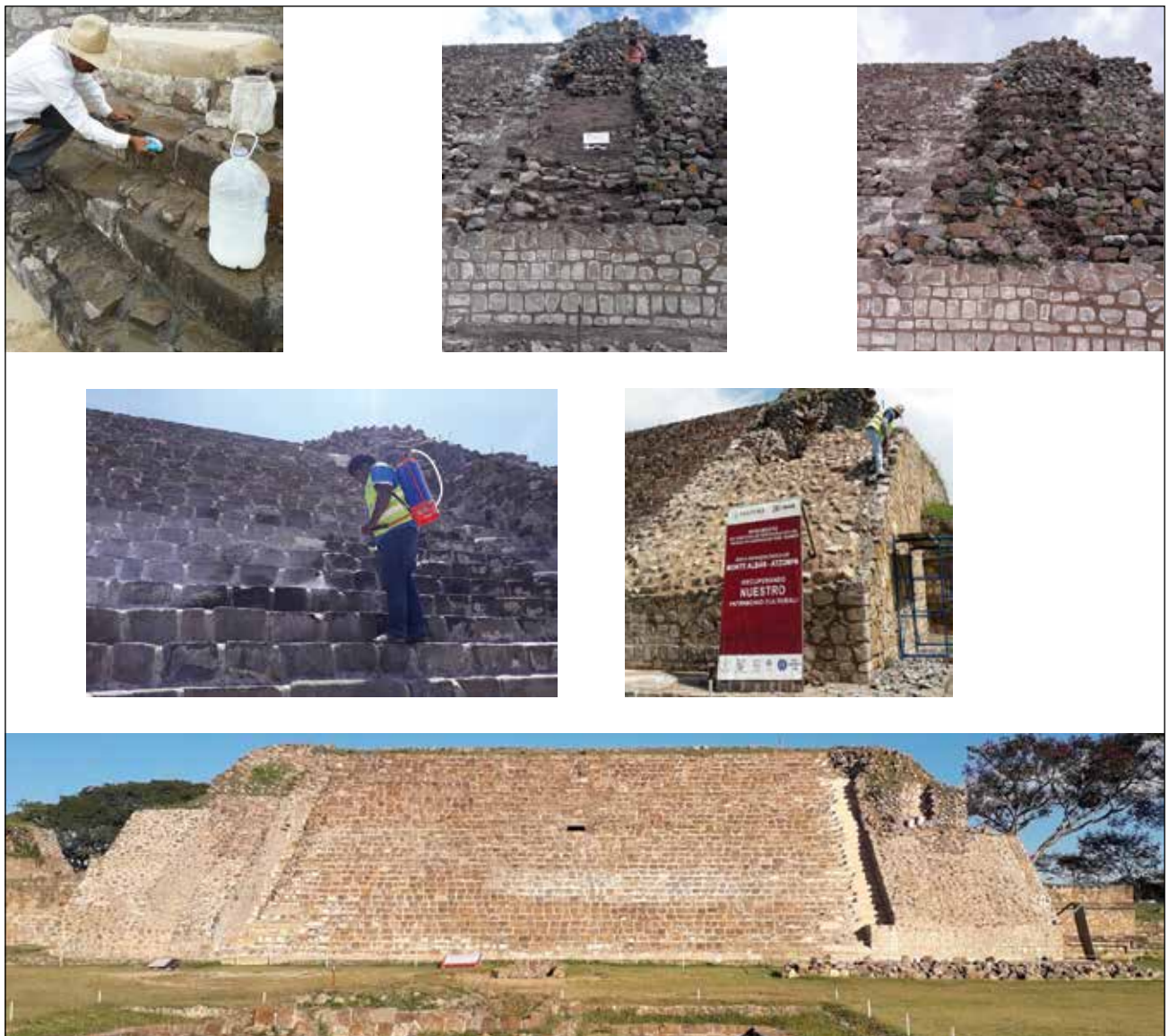
Limpieza de escaleras y colocación de mezcla de agua y cal para sellado e intervención / Foto: Archivo Técnico Proyecto de Conservación de los Edificios Dañados por los Sismos de 2017 en Monte Albán-Atzompa.
