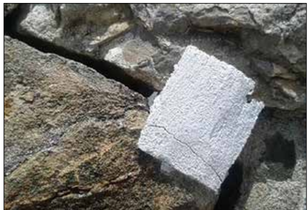
Colocación de sellos de cal para registro y monitoreo de movimiento del edificio / Foto: Archivo Técnico ZAMA, 2019.
