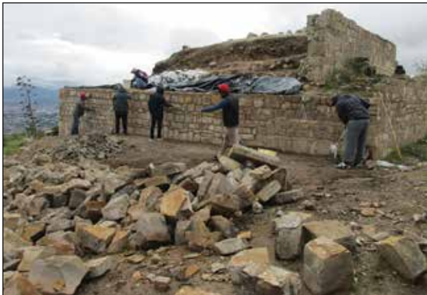
Fachada oriente del Edificio 16. Reintegración de sillares de piedra en el muro del segundo cuerpo / Foto: Archivo Técnico Proyecto de Conservación de los Edificios Dañados por los Sismos de 2017 en Monte Albán-Atzompa.
