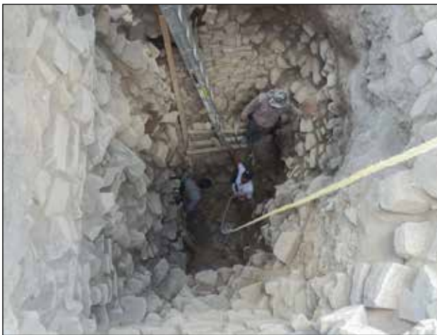
Edificio A, socavón al finalizar de los trabajos de exploración arqueológica / Foto: Archivo Técnico Proyecto Conservación de los Edificios Dañados por los Sismos de 2017 en Monte Albán-Atzompa.
