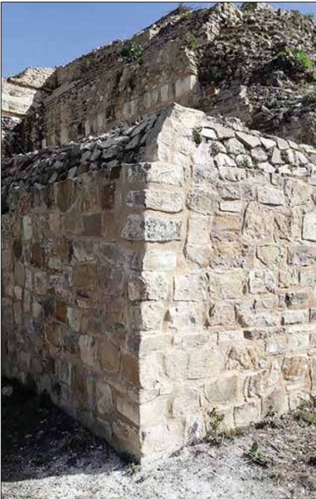
Consolidación de elementos dañados mediante inyección y sellado de grietas / Foto: Archivo Técnico Proyecto de Conservación de los Edificios Dañados por los Sismos de 2017 en Monte Albán-Atzompa.
