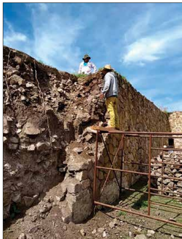
Liberación de relleno endeble de la parte posterior del cabezal sur / Foto: Archivo Técnico Proyecto de Conservación de los Edificios Dañados por los Sismos de 2017 en Monte Albán-Atzompa.
