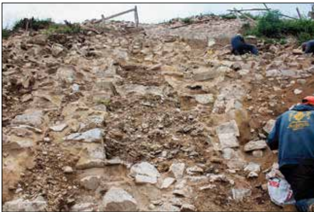
Muros contrafuertes y bloques de vaciado en la ladera este del Edificio P en donde se identificaron diversas mezclas de arcillas, limos y cal que combinados con piedra conformaron los núcleos constructivos / Foto: Archivo Técnico Proyecto de Conservación de los Edificios Dañados por los Sismos de 2017 en Monte Albán-Atzompa.
