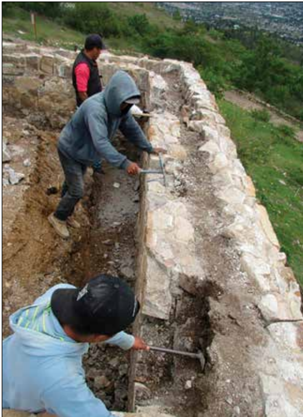
Fachada oriente del Edificio 16. Retiro de los nucleados en la parte superior del muro de segundo cuerpo / Foto: Archivo Técnico Proyecto de Conservación de los Edificios Dañados por los Sismos de 2017 en Monte Albán-Atzompa.
