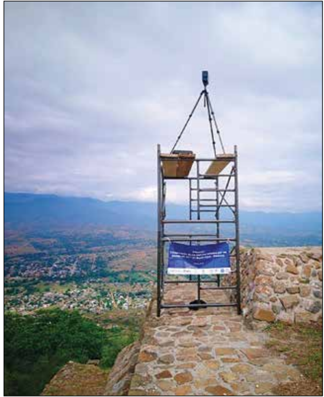
Sistema IV. Parte superior del templo, toma a nivel de 6 a 8 metros / Foto: Archivo Técnico Proyecto de Conservación de los Edificios Dañados por los Sismos de 2017 en Monte Albán-Atzompa.
