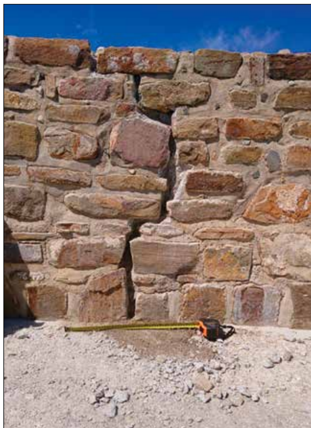
Templo del Edificio IV. Reposición de juntas constructivas en muros del templo / Foto: Archivo Técnico Proyecto de Conservación de los Edificios Dañados por los Sismos de 2017 en Monte Albán-Atzompa.
