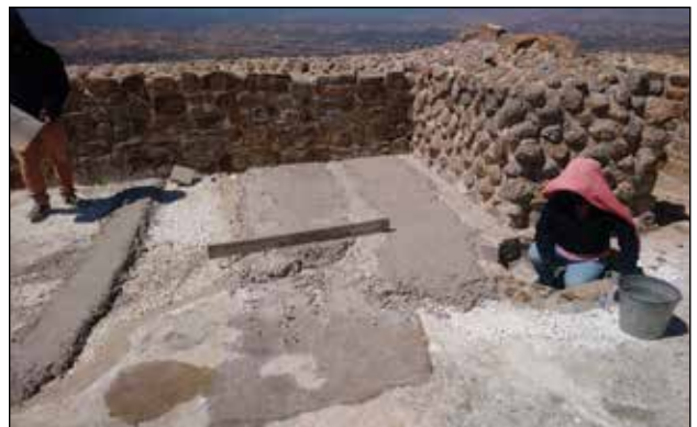
Templo del Edificio IV. Proceso de integración de piso de estuco moderno / Foto: Archivo Técnico Proyecto de Conservación de los Edificios Dañados por los Sismos de 2017 en Monte Albán-Atzompa.
