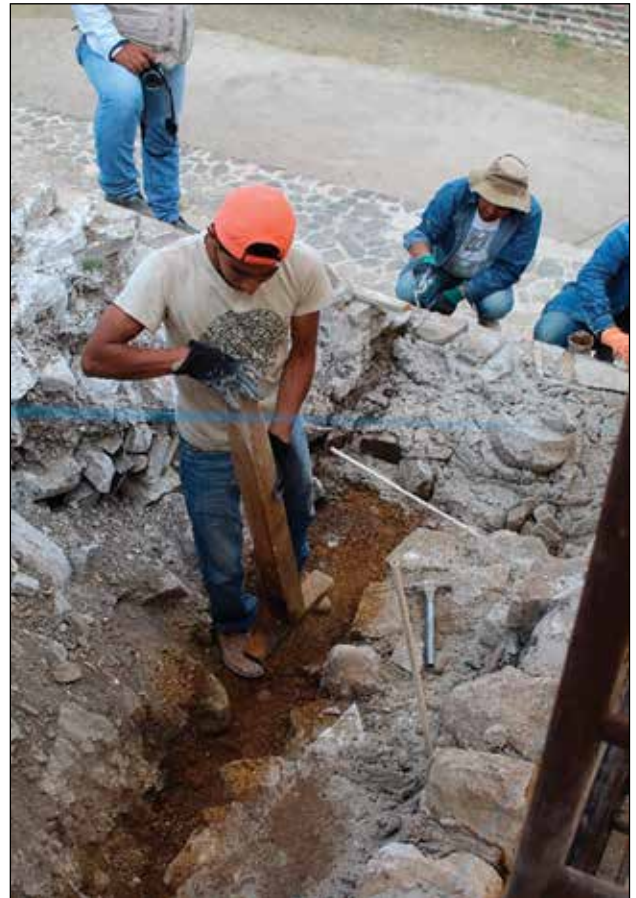
Proceso de compactación del relleno en la parte posterior del talud oeste (izquierda) y de alisado de juntas (derecha) / Foto: Archivo Técnico Proyecto de Conservación de los Edificios Dañados por los Sismos de 2017 en Monte Albán-Atzompa.
