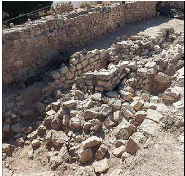
Muros prehispánicos encontrados por debajo del nivel de los muros de concreto, colocados durante el PEMA como tercer cuerpo en el Edificio A / Foto: Foto: Archivo Técnico Proyecto Conservación de los Edificios Dañados por los Sismos de 2017 en Monte Albán-Atzompá.
