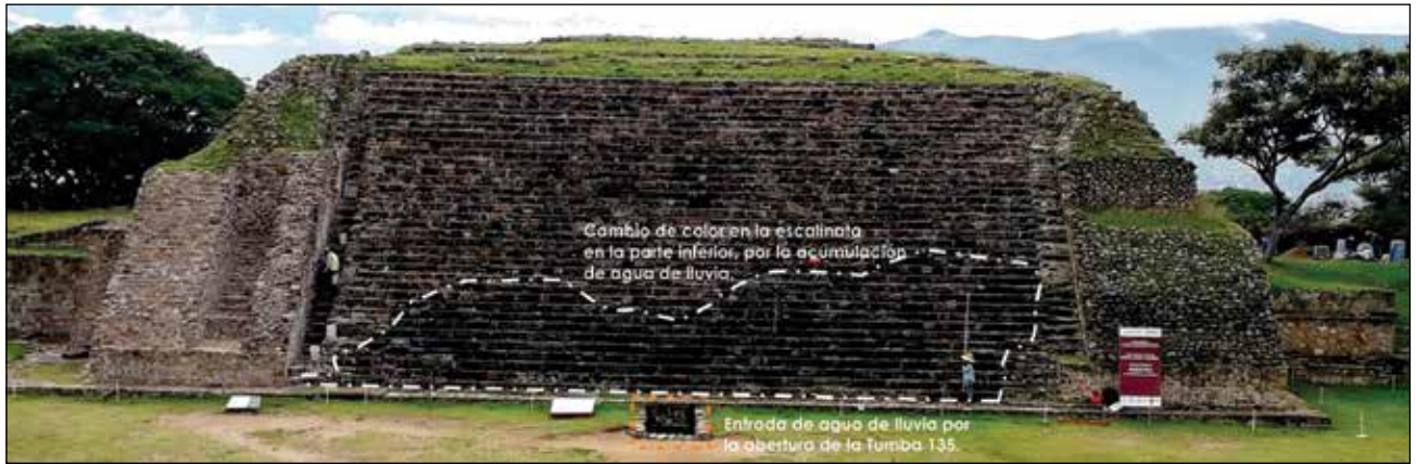
Alfardas y escalinata que constituyen la fachada oeste del Edificio P / Foto: Archivo Técnico Proyecto de Conservación de los Edificios Dañados por los Sismos de 2017 en Monte Albán-Atzompa.
