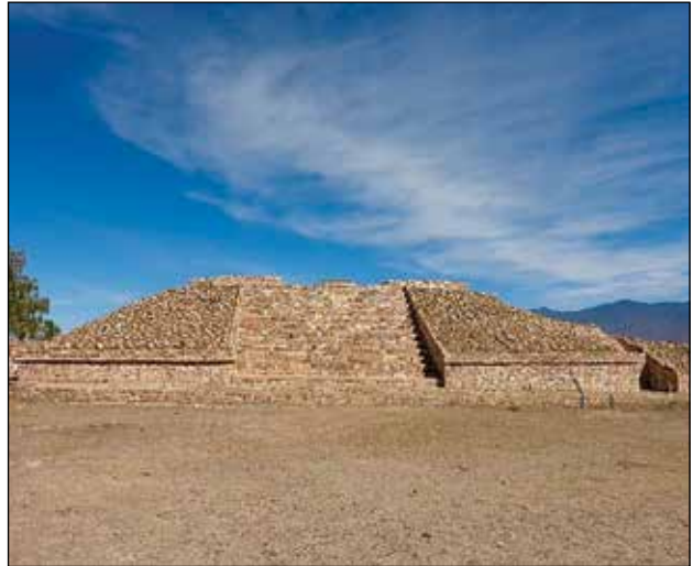
Edificio 6 al término de los trabajos de restauración, temporada 2014, vista fachada sur / Foto: Archivo Técnico Proyecto Conjunto Monumental de Atzompa.
