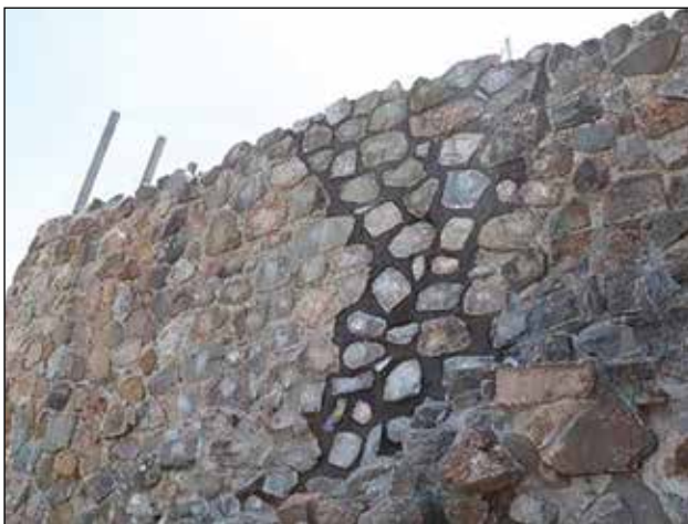
Consolidación terminada en la grieta 1, alzado norte / Foto: Archivo Técnico ZAMA, 2019.
