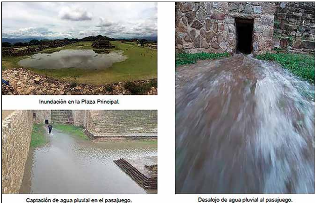
Fotos tomadas después de haber llovido en Monte Albán que muestran la cantidad de agua captada y drenada / Foto: Archivo Técnico ZAMA Sismos de 2017.
