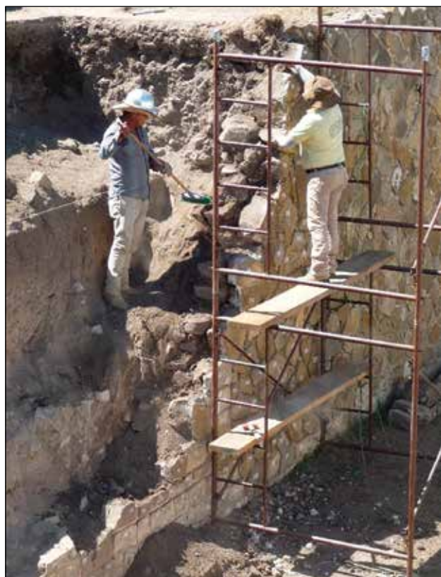
Liberación de relleno endeble de la parte posterior del cabezal sur / Foto: Archivo Técnico Proyecto de Conservación de los Edificios Dañados por los Sismos de 2017 en Monte Albán-Atzompa.
