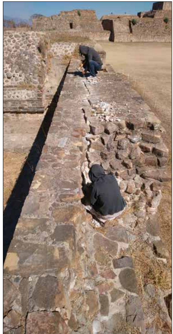
Templo del Edificio IV. Muro perimetral sur del patio abierto. Liberación de elementos dañados / Foto: Archivo Técnico Proyecto de Conservación de los Edificios Dañados por los Sismos de 2017 en Monte Albán-Atzompa.
