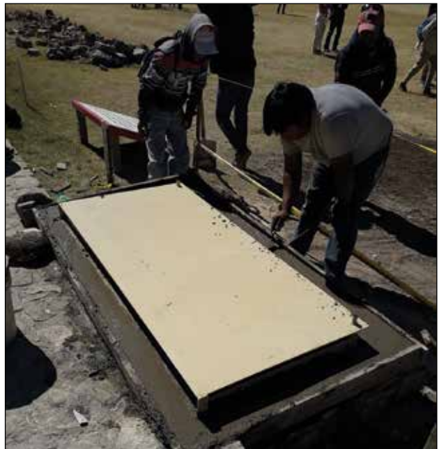
Registro 3d de la tumba y registro fotográfico después del resane y sellado de juntas de los muros internos y externos / Foto: Archivo Técnico Proyecto de Conservación de los Edificios Dañados por los Sismos de 2017 en Monte Albán-Atzompa.
