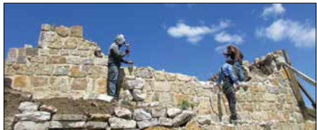
Fachada oriente del Edificio 16. Desmonte y remoción de sillares de piedra arenisca en muro dañado / Foto: Archivo Técnico Proyecto de Conservación de los Edificios Dañados por los Sismos de 2017 en Monte Albán-Atzompa.
