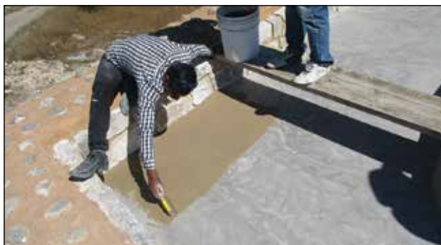
Templo del Edificio 16. Costado norte y oeste. Integración de la tercera capa de estuco en el piso de sacrificio y ribetes en el segundo piso de otro momento constructivo / Foto: Archivo Técnico Proyecto de Conservación de los Edificios Dañados por los Sismos de 2017 en Monte Albán-Atzompa.
