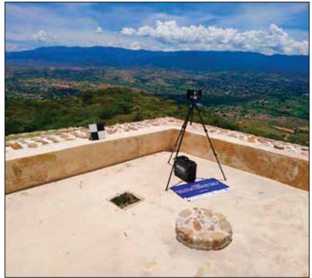
Registro 3d. Edificio 4. Esquina suroeste / Foto: Archivo Técnico Proyecto de Conservación de los Edificios Dañados por los Sismos de 2017 en Monte Albán-Atzompa.
