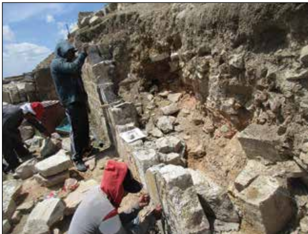
Fachada oriente del Edificio 16. Reintegración de sillares de piedra en el muro del primer cuerpo / Foto: Archivo Técnico Proyecto de Conservación de los Edificios Dañados por los Sismos de 2017 en Monte Albán-Atzompa.
