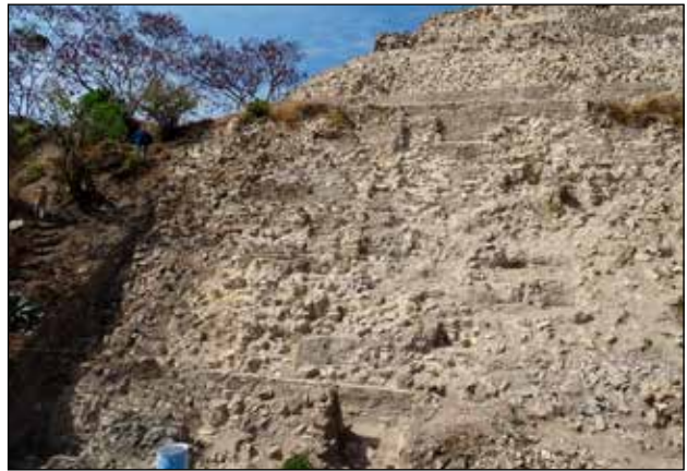
Vista de la ladera este. Se identifican muros contrafuertes, muros aparentes, núcleos y rellenos constructivos / Foto: Archivo Técnico Proyecto de Conservación de los Edificios Dañados por los Sismos de 2017 en Monte Albán-Atzompa.
