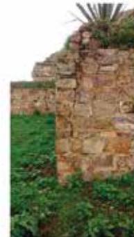
Esquina noroeste, plataforma de nivelación.
