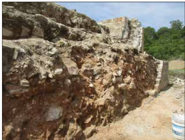
Fachada norte del Edificio 16. Desmonte y remoción de sillares de piedra arenisca en muro dañado de primer y segundo cuerpos / Foto: Archivo Técnico Proyecto de Conservación de los Edificios Dañados por los Sismos de 2017 en Monte Albán-Atzompa.
