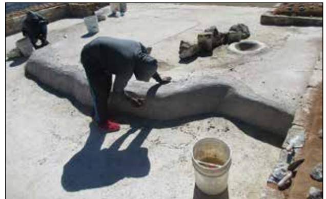
Templo del Edificio 16. Costado norte y oeste. Integración de la tercera capa de estuco en el piso de sacrificio y ribetes en el segundo piso de otro momento constructivo / Foto: Archivo Técnico Proyecto de Conservación de los Edificios Dañados por los Sismos de 2017 en Monte Albán-Atzompa.
