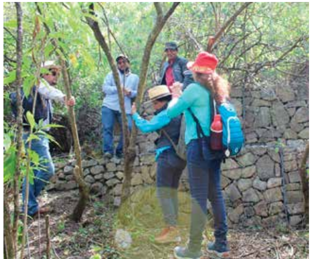
Revisión y evaluación del desempeño de gaviones en la ladera oeste de Monte Albán, instalados como parte del "Proyecto emergente de Restauración por los efectos del Sismo del 30 de septiembre de 1999". Participan ingenieros del Departamento de Mecánica de Suelos del IIT / Foto: Archivo Técnico Proyecto de Conservación de los Edificios Dañados por los Sismos de 2017 en Monte Albán-Atzompa.
