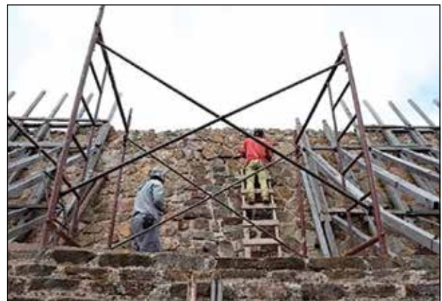
Restauración del muro en resane de la grieta 2 / Foto: Archivo Técnico ZAMA, 2019.
