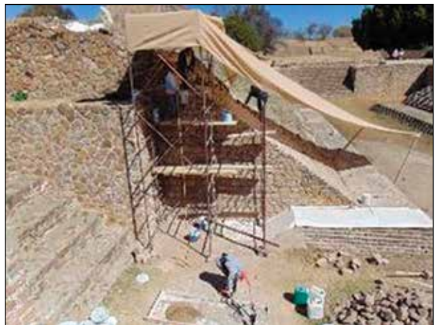
A la izquierda, desplante del muro talud oeste; a la derecha, proceso de integración del muro talud / Foto: Archivo Técnico Proyecto de Conservación de los Edificios Dañados por los Sismos de 2017 en Monte Albán-Atzompa.
