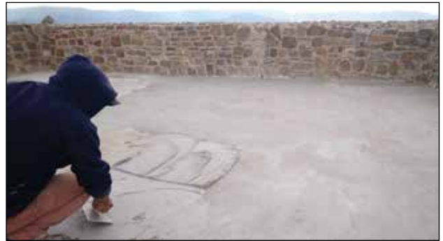
Templo del Edificio IV. Integración de capa de sacrificio en áreas faltantes / Foto: Archivo Técnico Proyecto de Conservación de los Edificios Dañados por los Sismos de 2017 en Monte Albán-Atzompa.
