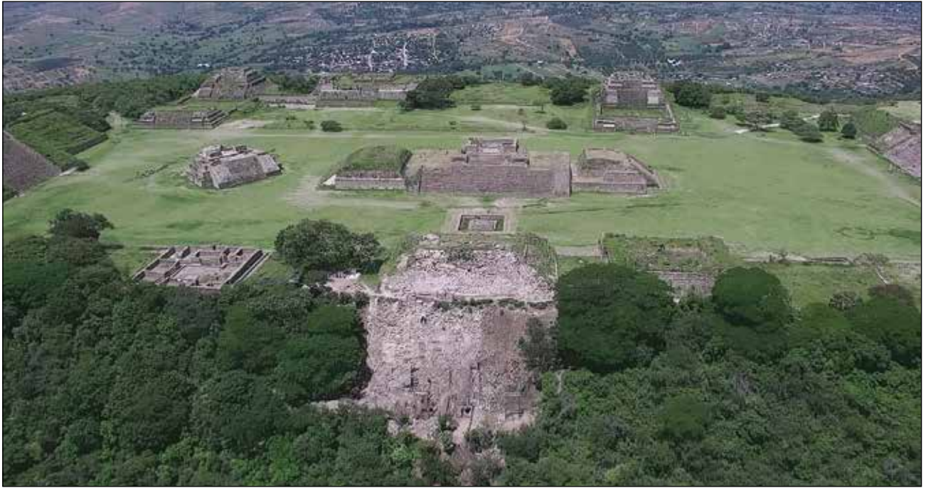
Vista aérea de la ladera este del Edificio P / Foto: Archivo Técnico Proyecto Conservación de los Edificios Dañados por los Sismos de 2017 en Monte Albán-Atzompa.
