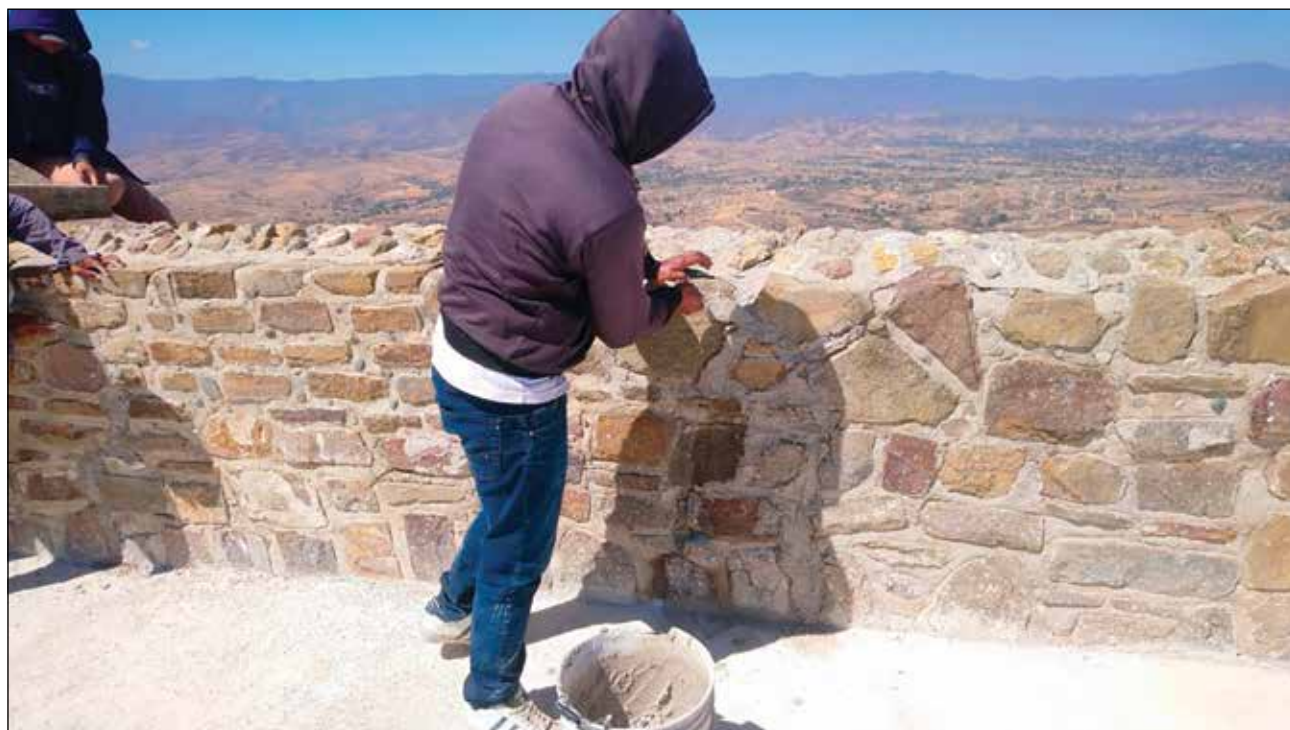
Templo del Edificio IV. Reposición de juntas constructivas en muros del templo / Foto: Archivo Técnico Proyecto de Conservación de los Edificios Dañados por los Sismos de 2017 en Monte Albán-Atzompa.
