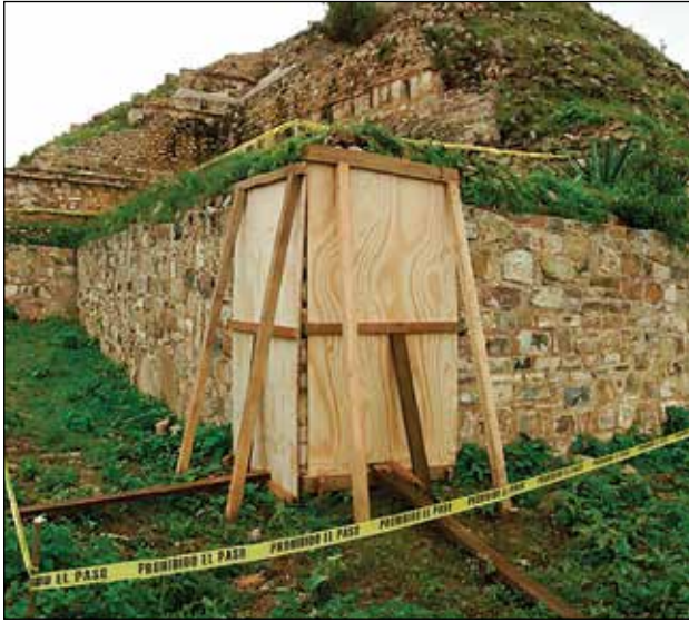
Conjunto Monumental de Atzompa. Acciones emergentes: apuntalamiento y acordonamiento de la fachada Este del Edificio 4 después del sismo / Foto: Archivo Proyecto Arqueológico Conjunto Monumental de Atzompa, 2017.
