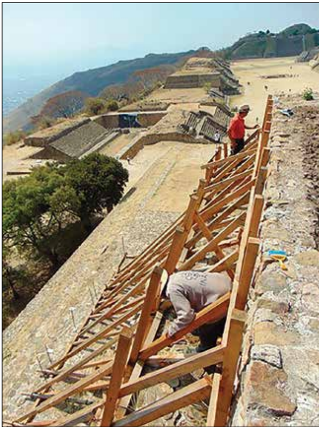
Zona Arqueológica de Monte Albán. Acciones emergentes: apuntalamiento de la fachada este del Edificio A / Foto: Julio Manlio Zúñiga Cruz.
