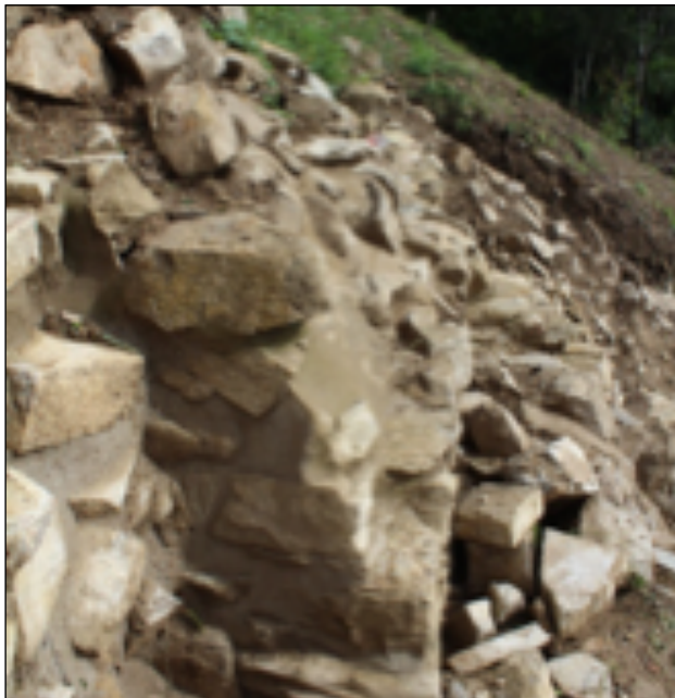
Detalle de muro contrafuerte y sección de muro escalonado en la cala E9 hacia cala E11 y E12. Se distingue que los paramentos de los cuadrantes E12 se encuentran en buen estado de conservación mientras que los bloques de vaciado de los cuadrantes E13 y E14 se han destruido en su totalidad / Archivo Técnico Proyecto Conservación de los Edificios Dañados por los Sismos de 2017 en Monte Albán y Atzompa.
