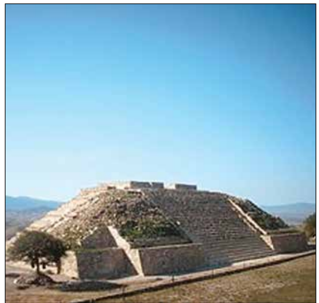
Edificio 4, conclusión de los trabajos de restauración, fachadas este y sur, temporada 2011 / Foto Archivo Técnico Proyecto Conjunto Monumental de Atzompa.
