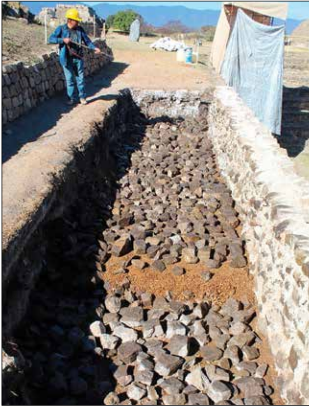
Proceso de recuperación del relleno en la parte posterior del cabezal sur del Juego de Pelota / Foto: Archivo Técnico Proyecto de Conservación de los Edificios Dañados por los Sismos de 2017 en Monte Albán-Atzompa.
