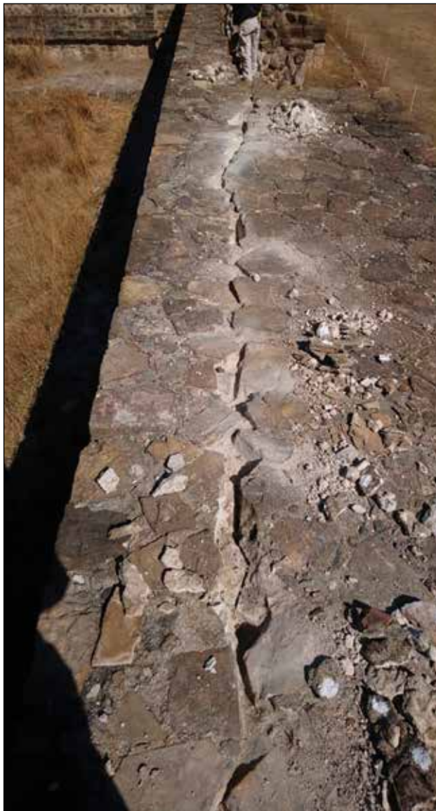
Templo del Edificio IV. Muro perimetral sur del patio abierto. Liberación de elementos dañados / Foto: Archivo Técnico Proyecto de Conservación de los Edificios Dañados por los Sismos de 2017 en Monte Albán-Atzompa.
