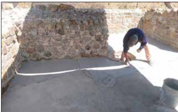
Templo del Edificio IV. Proceso de integración de piso de estuco moderno / Foto: Archivo Técnico Proyecto de Conservación de los Edificios Dañados por los Sismos de 2017 en Monte Albán-Atzompa.
