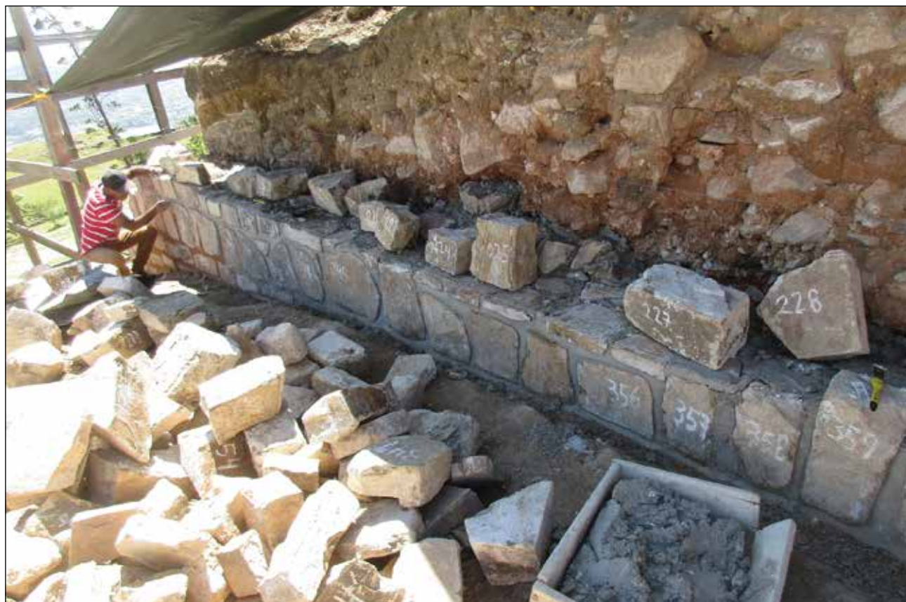
Fachada norte del Edificio 16. Reintegración de sillares de piedra en el muro del primer cuerpo / Foto: Archivo Técnico Proyecto de Conservación de los Edificios Dañados por los Sismos de 2017 en Monte Albán-Atzompa.
