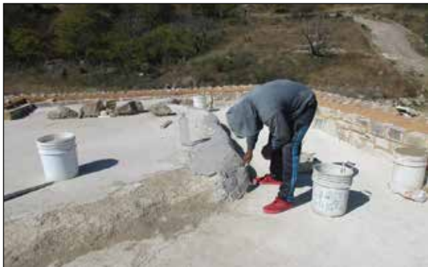
Templo del Edificio 16. Costado norte y oeste. Integración de la tercera capa de estuco en el piso de sacrificio y ribetes en el segundo piso de otro momento constructivo / Foto: Archivo Técnico Proyecto de Conservación de los Edificios Dañados por los Sismos de 2017 en Monte Albán-Atzompa.
