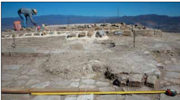
Proceso de exploración en la parte superior del Edificio P, se aprecia uno de los tlecuiles hallados / Foto: Archivo técnico Proyecto conservación a los edificios dañados por los sismos de 2017 en Monte Albán y Atzompa.
