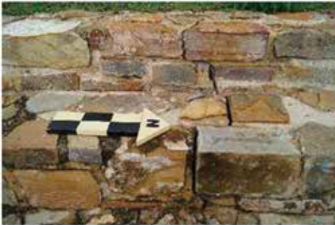
Escalinata central, parte alta.
