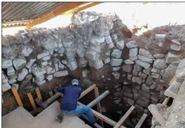
Proceso de colocación de los puntales en el interior del Pozo 1, en la extensión norte / Archivo Técnico Proyecto Conservación de los Edificios Dañados por los Sismos de 2017 en Monte Albán y Atzompa.
