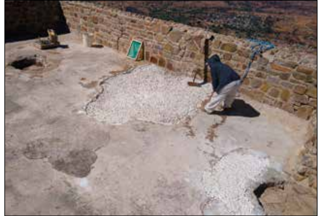
Templo del Edificio IV. Integración de capa de sacrificio en áreas faltantes / Foto: Archivo Técnico Proyecto de Conservación de los Edificios Dañados por los Sismos de 2017 en Monte Albán-Atzompa.
