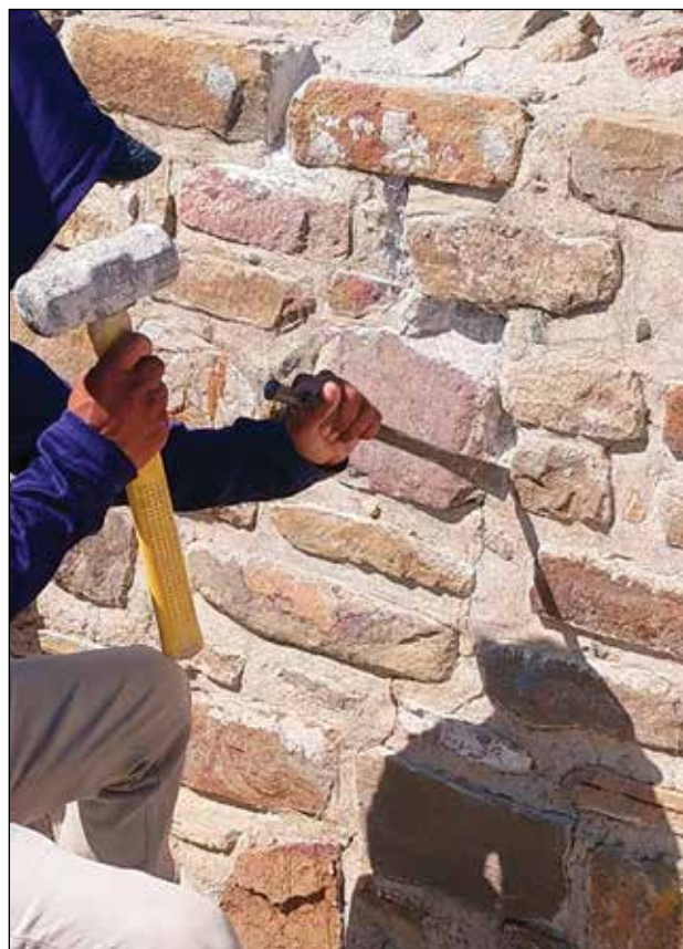
Templo del Edificio IV. Reposición de juntas constructivas en muros del templo / Foto: Archivo Técnico Proyecto de Conservación de los Edificios Dañados por los Sismos de 2017 en Monte Albán-Atzompa.
