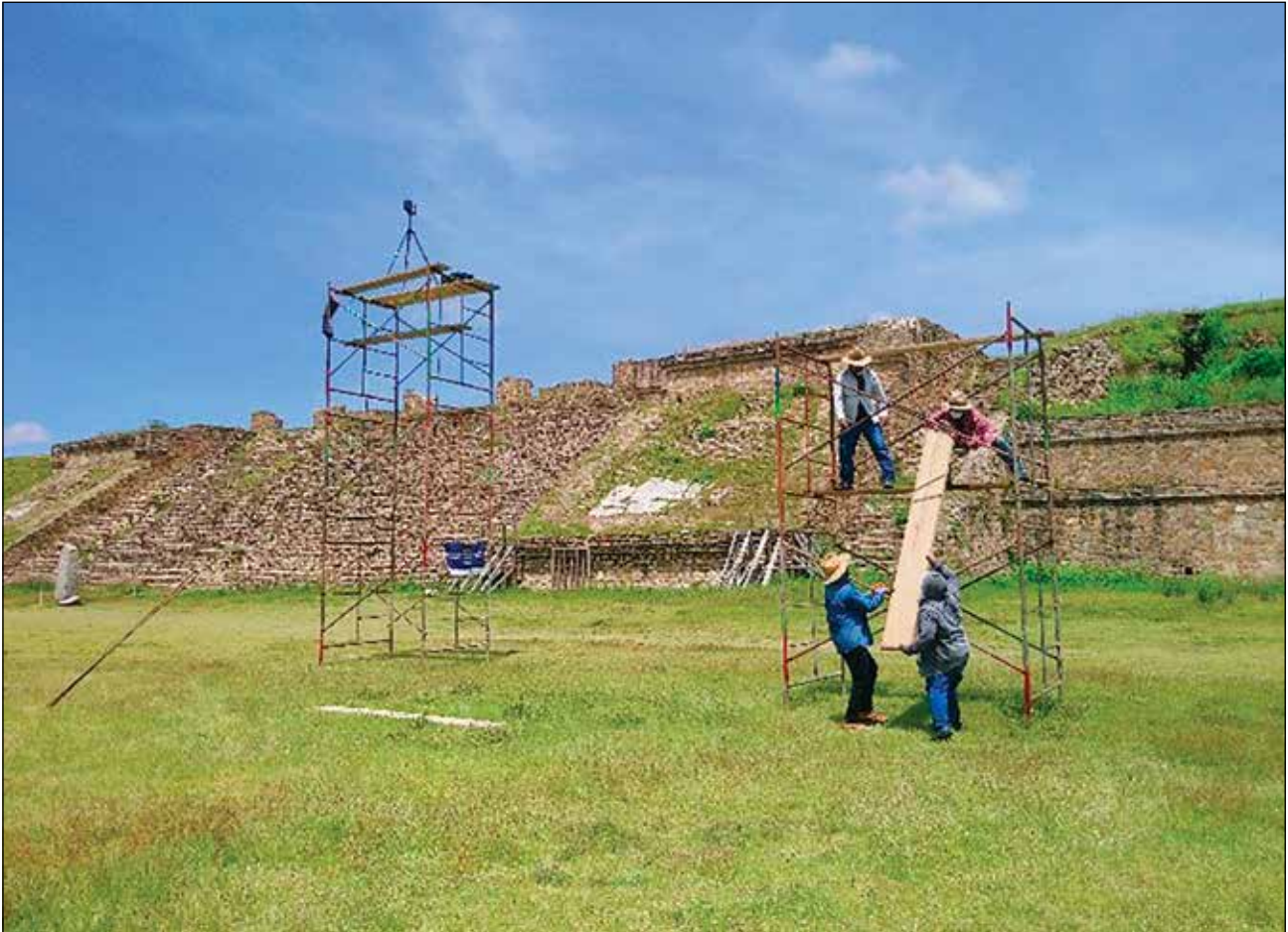
Componente 3. Acceso de lado sur. Montaje y programación de scanner 3D / Foto: Archivo Técnico Proyecto de Conservación de los Edificios Dañados por los Sismos de 2017 en Monte Albán-Atzompa.
