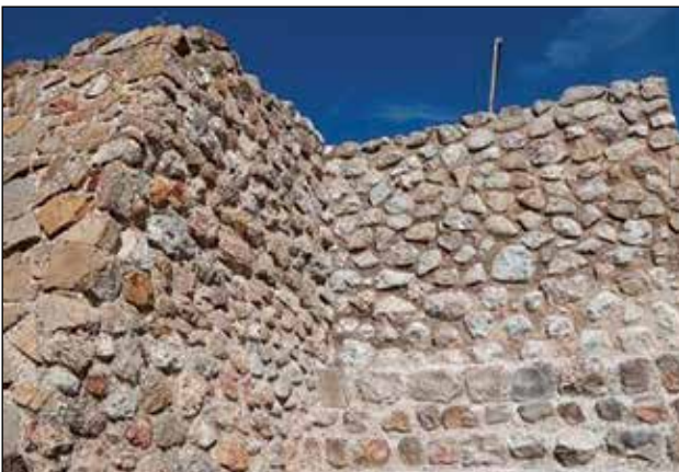
Esquina sureste y muro restaurado 7 / Foto: Archivo Técnico ZAMA, 2019.
