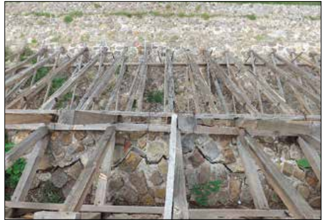
Zona Arqueológica de Monte Albán. Acciones emergentes: apuntalamiento del Edificio A después del sismo del 7 de septiembre; con el sismo del 19 de septiembre el muro se asentó y recargó en el apuntalamiento / Foto: Eduardo García Wigueras Ibarra.
