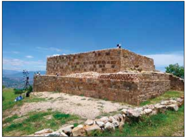
Registro 3D. Edificio 16. Lado norte / Foto: Archivo Técnico Proyecto de Conservación de los Edificios Dañados por los Sismos de 2017 en Monte Albán-Atzompa.
