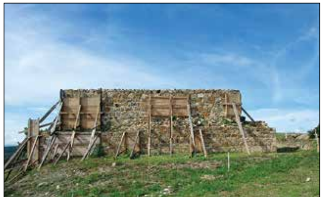
Conjunto Monumental de Atzompa. Acciones emergentes: apuntalamiento de la fachada Este del Edificio 16, después del sismo / Foto: Archivo Proyecto Arqueológico Conjunto Monumental de Atzompa, 2017.
