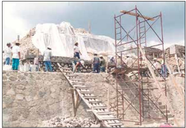
Cuadrillas de trabajadores en el proceso de consolidación durante el proyecto del FONDEN 1999 / Foto: Centro de Documentación Zona Arqueológica de Monte Albán.
