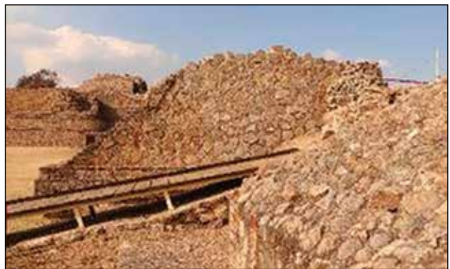
Muro alfarda sur terminado / Foto: Archivo Técnico ZAMA, sismos de 2017.
