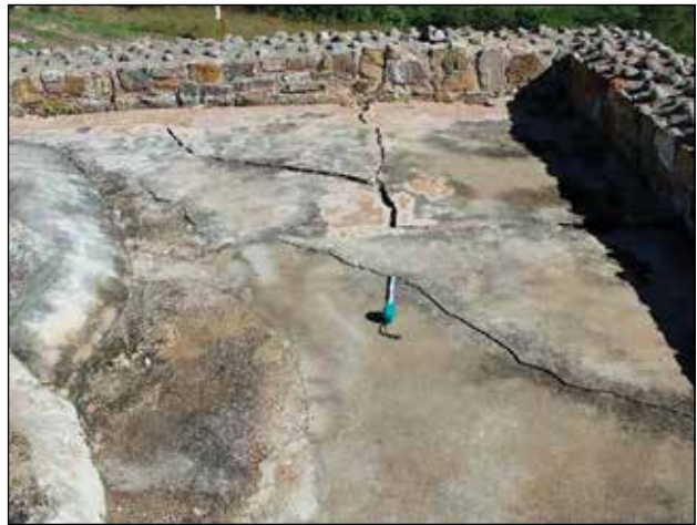
Templo del Edificio 16. Estado de los pisos de sacrificio al interior del templo / Foto: Archivo Técnico Proyecto de Conservación de los Edificios Dañados por los Sismos de 2017 en Monte Albán-Atzompa.
