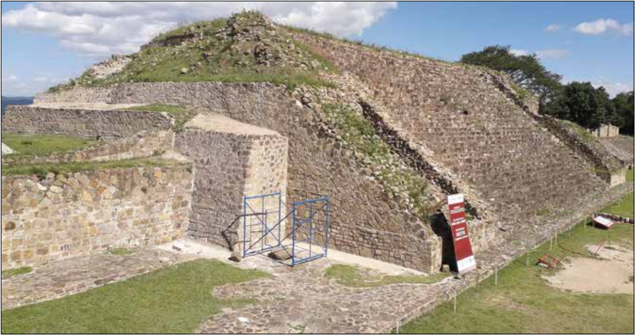
Vista del lado norte del Edificio P después de su restauración / Foto: Archivo Técnico Proyecto de Conservación de los Edificios Dañados por los Sismos de 2017 en Monte Albán-Atzompa.
