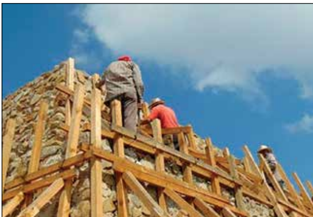
Apuntalamiento del alzado este, tableros doble escapulario, esquinas noreste y sureste / Foto: Archivo Técnico ZAMA, 2019.
