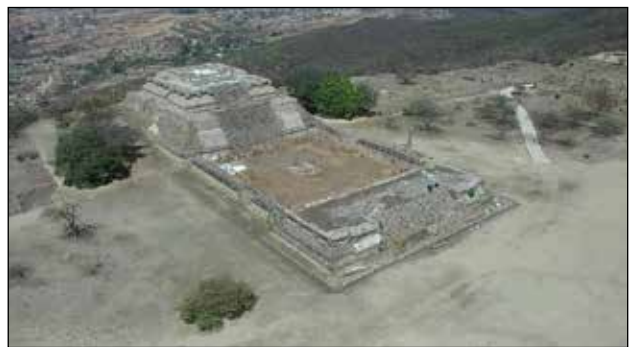
Sistema IV. Vista del lado sureste / Foto: Archivo Técnico Proyecto de Conservación de los Edificios Dañados por los Sismos de 2017 en Monte Albán-Atzompa.
