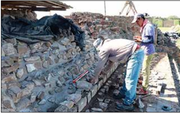
Reintegración de relleno y escalinatas del lado norte / Foto: Archivo Técnico ZAMA, 2019.
