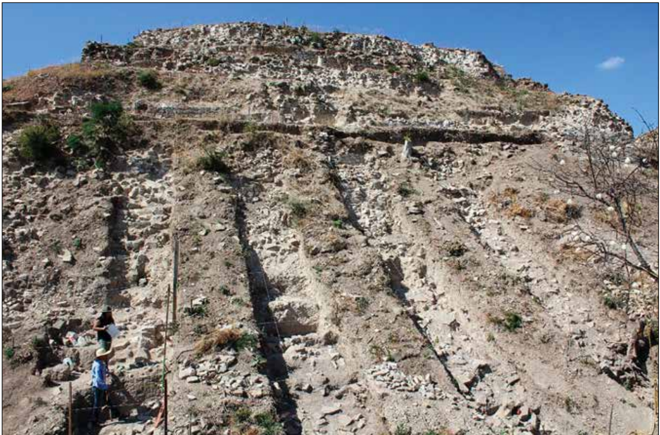
Disposición de calas de excavadas y calas sin excavar en la ladera este del Edificio P / Foto: Archivo Técnico Proyecto Conservación de los Edificios Dañados por los Sismos de 2017 en Monte Albán-Atzompa.
