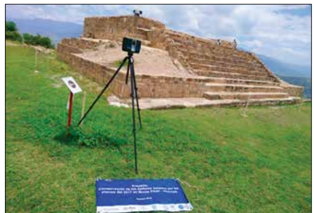
Registro 3D. Edificio 16. Lado sur / Foto: Archivo Técnico Proyecto de Conservación de los Edificios Dañados por los Sismos de 2017 en Monte Albán-Atzompa.
