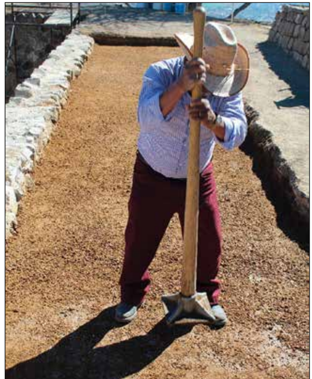
Proceso de apisonado del relleno en la parte posterior del cabezal sur del Juego de Pelota / Foto: Archivo Técnico Proyecto de Conservación de los Edificios Dañados por los Sismos de 2017 en Monte Albán-Atzompa.
