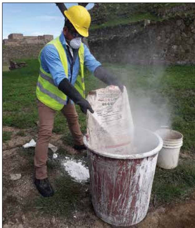
Preparación de cal química para los procesos de restauración y consolidación / Foto: Archivo Técnico Proyecto de Conservación de los Edificios Dañados por los Sismos de 2017 en Monte Albán-Atzompa.
