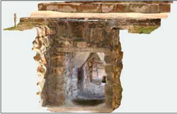
Registro 3d de la tumba y registro fotográfico después del resane y sellado de juntas de los muros internos y externos / Foto: Archivo Técnico Proyecto de Conservación de los Edificios Dañados por los Sismos de 2017 en Monte Albán-Atzompa.
