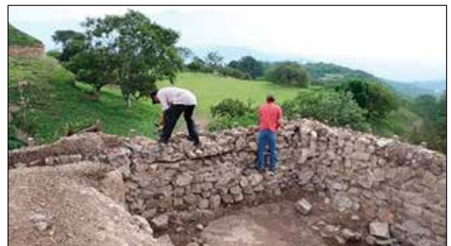
Retiro de los muros perimetrales del tercer cuerpo que generaban sobrepeso estructural al edificio / Foto: Archivo Técnico ZAMA, 2019.
