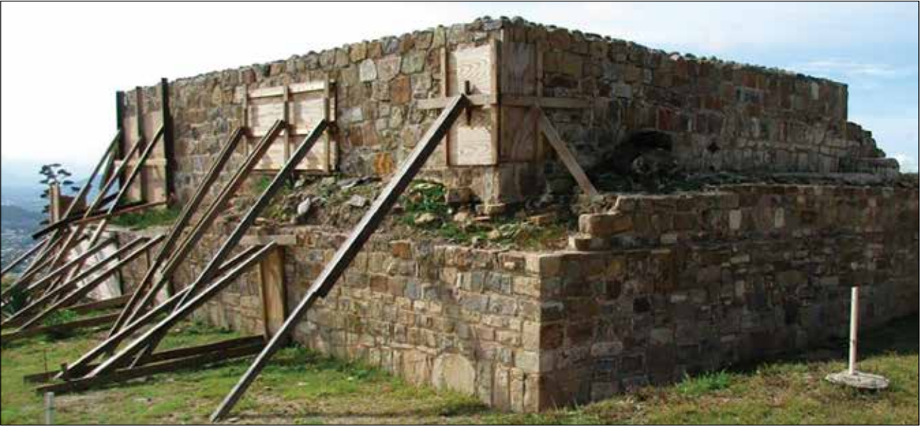
Fachada oriente del Edificio 16. Reintegración de sillares de piedra en el muro del segundo cuerpo / Foto: Archivo Técnico Proyecto de Conservación de los Edificios Dañados por los Sismos de 2017 en Monte Albán-Atzompa.
