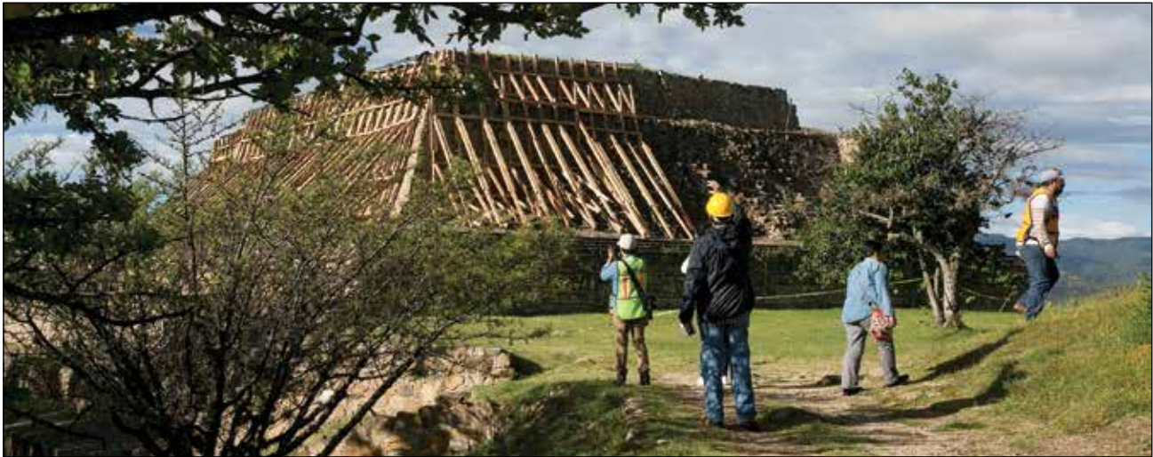
Zona Arqueológica de Monte Albán. Acciones emergentes: acordonamientos, apuntalamientos y evaluación de daños al Edificio A después del sismo del 7 de septiembre / Foto: Fidel Ugarte, INAH.
