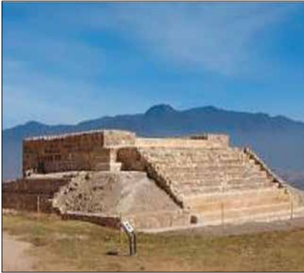
Vista general del Edificio 16 después de los trabajos de restauración / Foto: Archivo Técnico Proyecto Conjunto Monumental de Atzompa.
