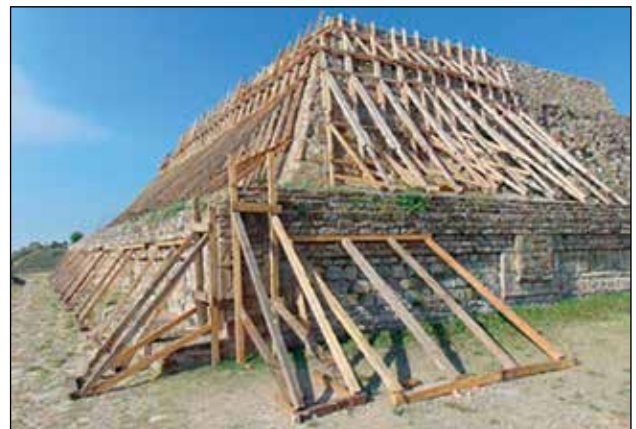
Apuntalamiento del alzado este, tableros doble escapulario, esquinas noreste y sureste / Foto: Archivo Técnico ZAMA, 2019.
