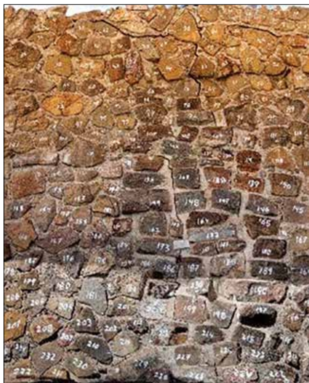
Anastilosis para atención del muro en la grieta 3 / Foto: Archivo Técnico ZAMA, 2019.
