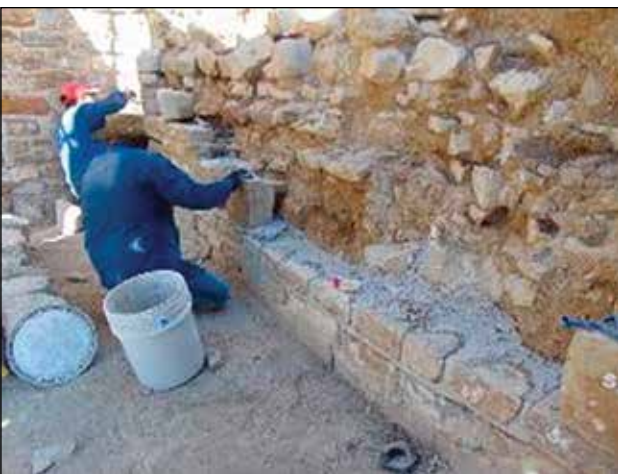
A la izquierda, desplante del muro talud oeste; a la derecha, proceso de integración del muro talud / Foto: Archivo Técnico Proyecto de Conservación de los Edificios Dañados por los Sismos de 2017 en Monte Albán-Atzompa.
