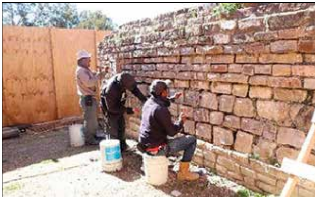
Liberación de junta constructiva en el tablero este, esquina norte / Foto: Archivo Técnico ZAMA, 2019.
