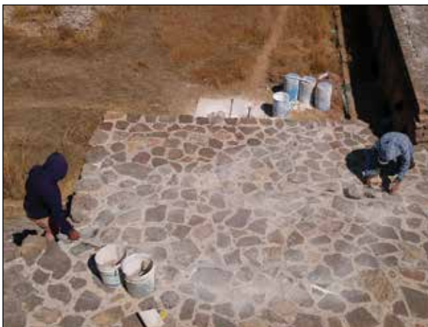
Templo del Edificio IV. Piso enlajado de la parte superior del segundo cuerpo del lado sur. Consolidación de elementos dañados / Foto: Archivo Técnico Proyecto de Conservación de los Edificios Dañados por los Sismos de 2017 en Monte Albán-Atzompá.
