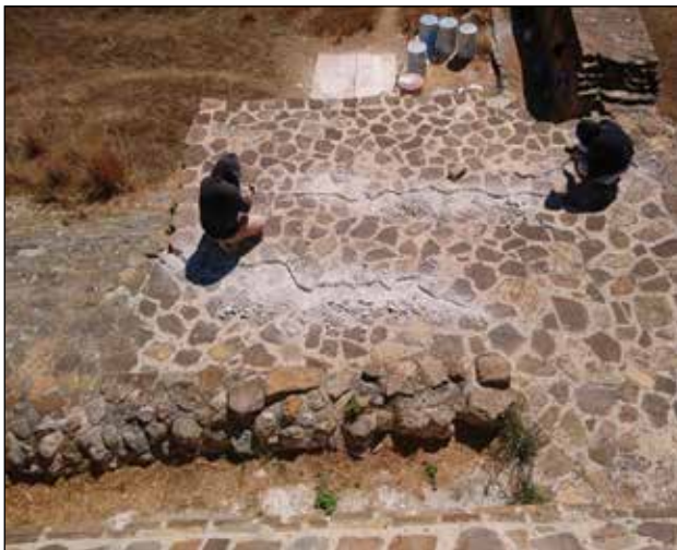
Templo del Edificio IV. Piso enlajado de la parte superior del segundo cuerpo del lado sur. Proceso de liberación / Foto: Archivo Técnico Proyecto de Conservación de los Edificios Dañados por los Sismos de 2017 en Monte Albán-Atzompá.
