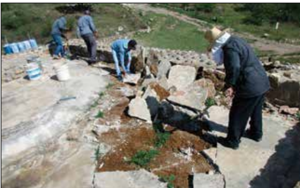
Templo del Edificio 16. Costado norte y oeste. Retiro de piso moderno integrado / Foto: Archivo Técnico Proyecto de Conservación de los Edificios Dañados por los Sismos de 2017 en Monte Albán-Atzompa.
