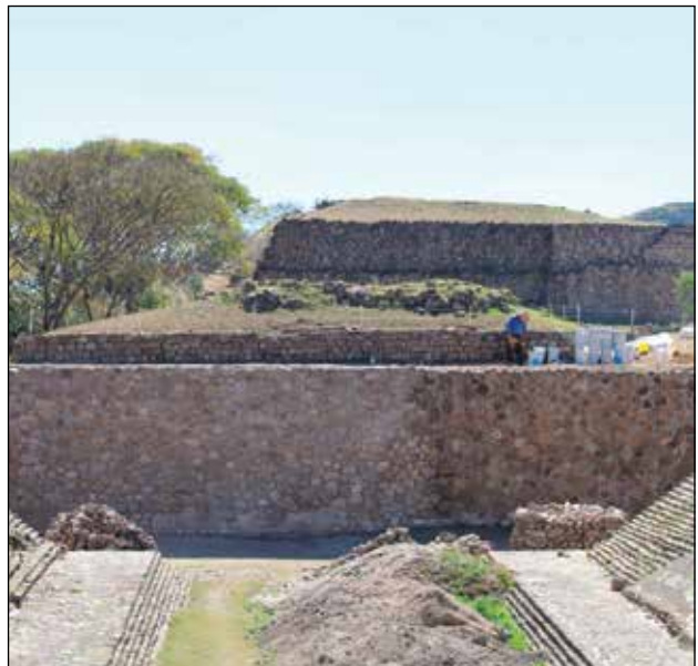
Muro sur terminado / Foto: Archivo Técnico Proyecto de Conservación de los Edificios Dañados por los Sismos de 2017 en Monte Albán-Atzompa.
