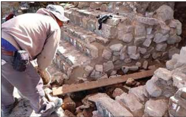
Restauración en la Cala 1 y escalinata del tercer cuerpo / Foto: Archivo Técnico ZAMA, 2019.
