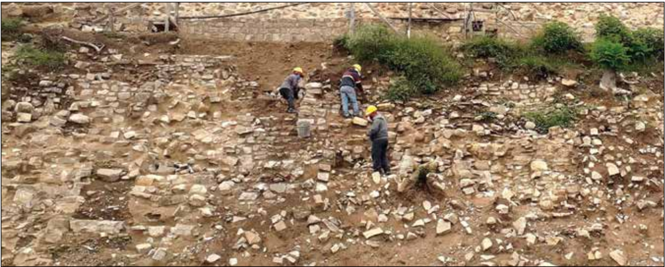
Fotografía de la fachada este, se pueden observar los núcleos de barro de los sistemas constructivos / Foto: Archivo Técnico Proyecto Conservación de los Edificios Dañados por los Sismos de 2017 en Monte Albán-Atzompa.
