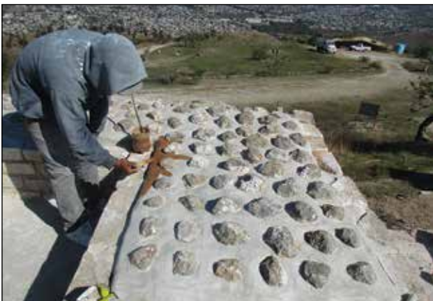
Templo del Edificio 16. Proceso de integración de sellado de muros superiores con nucleados / Foto: Archivo Técnico Proyecto de Conservación de los Edificios Dañados por los Sismos de 2017 en Monte Albán-Atzompa.
