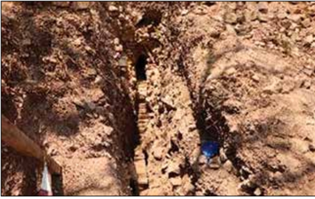
Vista de la cala 1 con el desagüe este / Foto: Archivo Técnico ZAMA, sismos de 2017.
