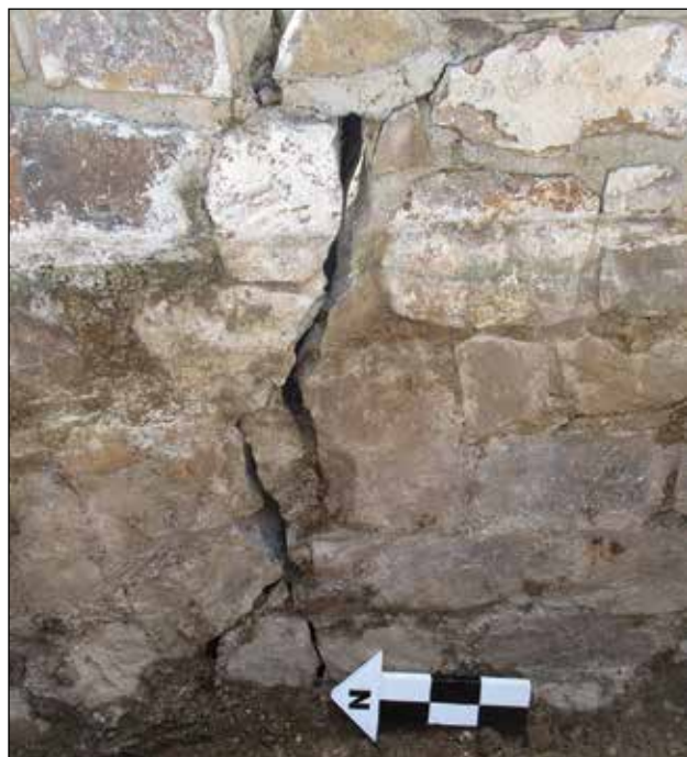
Fachada oriente del Edificio 16. Grietas con separación de elementos en muro de primer y segundo cuerpo, lado oriente / Foto: Archivo Técnico Proyecto de Conservación de los Edificios Dañados por los Sismos de 2017 en Monte Albán-Atzompa.
