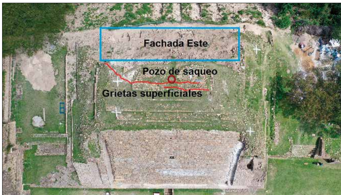
Vista aérea (dron) de las grietas de la parte superior del edificio, la fachada y la ladera este, desde donde desplanta el Edificio P / Foto: Archivo Técnico Proyecto Conservación de los Edificios Dañados por los Sismos de 2017 en Monte Albán-Atzompa.
