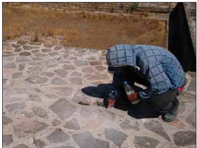
Templo del Edificio IV. Piso enlajado de la parte superior del segundo cuerpo del lado sur. Consolidación de elementos dañados / Foto: Archivo Técnico Proyecto de Conservación de los Edificios Dañados por los Sismos de 2017 en Monte Albán-Atzompá.
