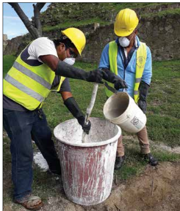
Preparación de cal química para los procesos de restauración y consolidación / Foto: Archivo Técnico Proyecto de Conservación de los Edificios Dañados por los Sismos de 2017 en Monte Albán-Atzompa.
