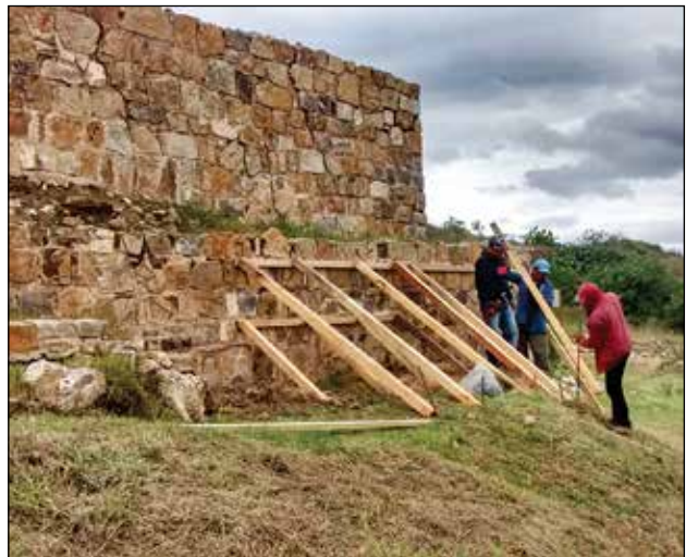
Conjunto Monumental de Atzompa. Acciones emergentes: apuntalamiento de la fachada Este del Edificio 16, después del sismo / Foto: Archivo Proyecto Arqueológico Conjunto Monumental de Atzompa, 2017.
