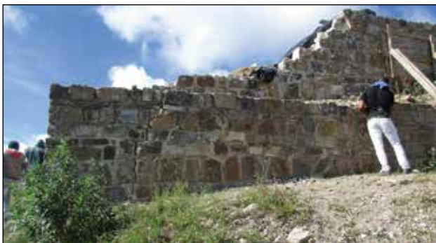
Fachada norte del Edificio 16. Numeración de piezas sillares de piedra / Foto: Archivo Técnico Proyecto de Conservación de los Edificios Dañados por los Sismos de 2017 en Monte Albán-Atzompa.
