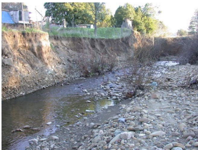
RIBERA EROSIONADA Foto cortesía de MCRCD
