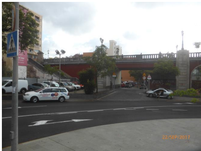
Foto 7: Viario de entrada al aparcamiento
