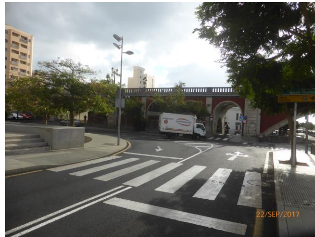
Foto 4: Viario de acceso al aparcamiento desde el Paseo de La Concordia
