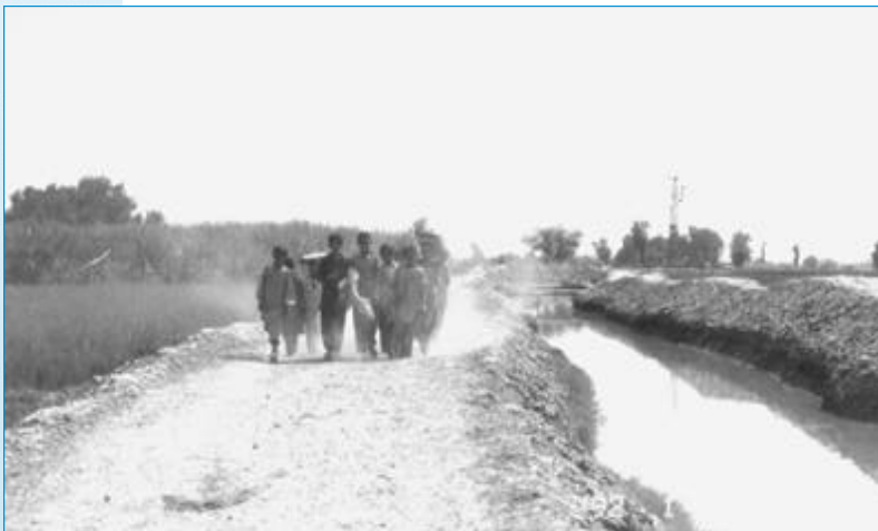
Niños del pueblo caminando hacia la escuela a lado del nuevo canal de drenaje
