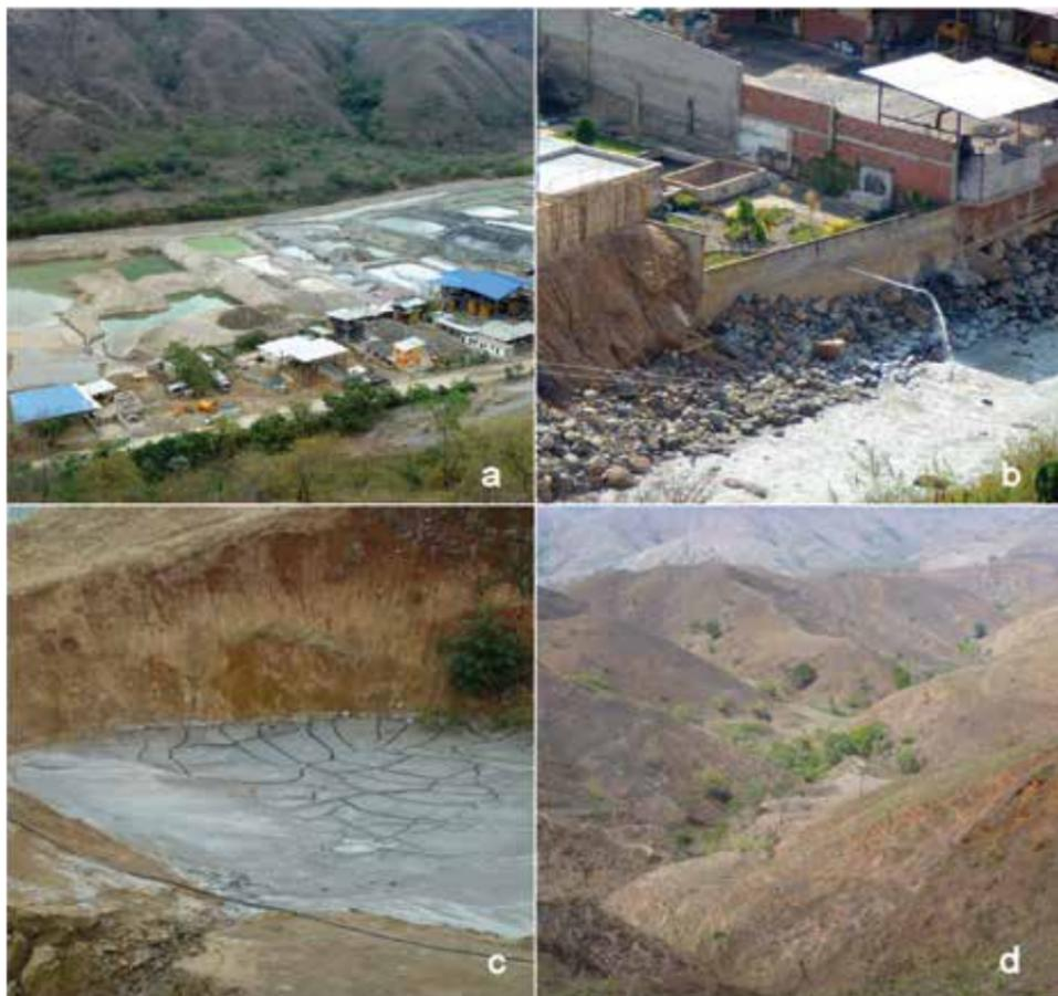
*Desechos mal manejados, áreas contaminadas, y una solución para la minería de oro artesanal y a pequeña escala en Portovelo, Ecuador: (a) estanques de colas inapropiados; (b) descarga directa en ríos; (c) áreas contaminadas con colas; (d) valle adyacente (pasto quemado) adecuado para el almacenamiento de colas que cumple con los estándares internacionales y que es apto para la comunidad de la MAPE.*
