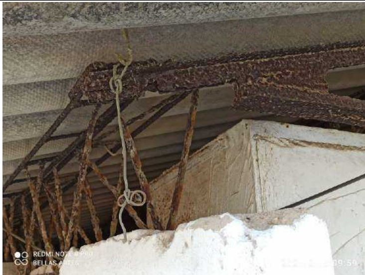
F-29. Se observan un alto grado de oxidación en los elementos metálicos que hacen parte de la estructura de la cubierta. Perdida de material en los elementos de concreto.
