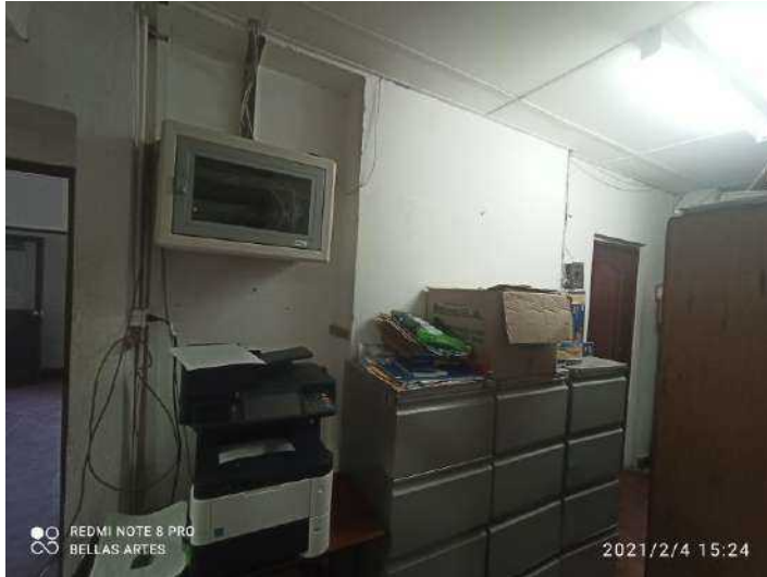
F-108. Se presenta cableado sobrepuesto y suelto sobre el muro. Se realizaron modificaciones para adecuación de instalaciones técnicas.
