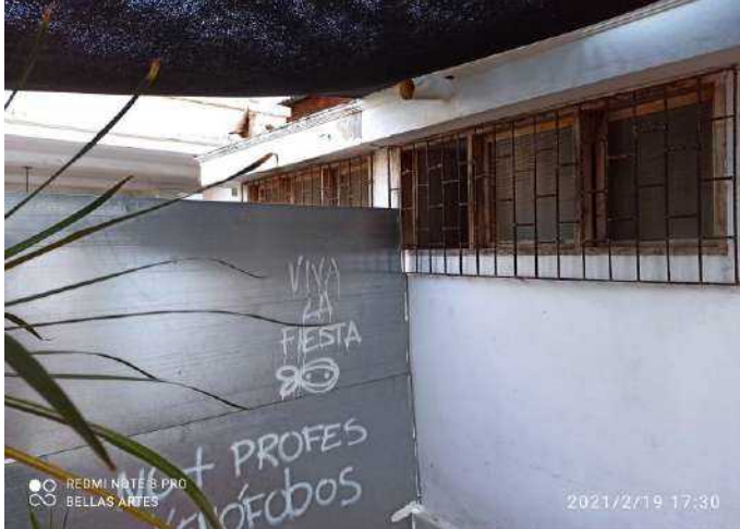
F-27. Se evidencia pérdida de material superficial en los elementos metálicos y desgaste de la carpintería de madera. Desprendimiento de materiales de acabado y pérdida de material en las cornisas.
