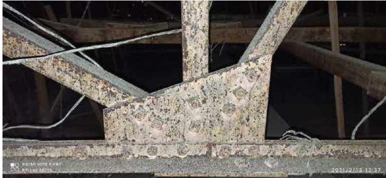
F-44. Perdida de material en la superficie de los elementos metálicos que conforman la estructura de la cubierta.
