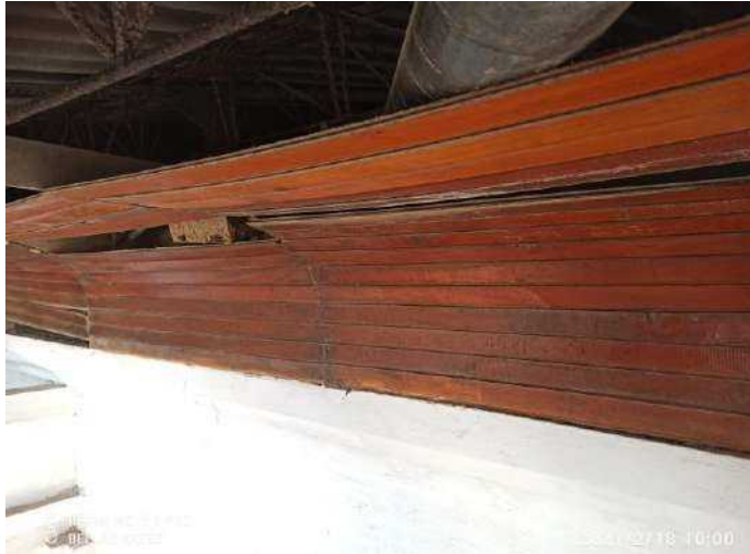
F-33. Se evidencian faltantes en el machimbre del cielo raso, así mismo se presenta deterioro de la madera por desgaste propio del material y falta de mantenimiento. Perdida de material en la superficie de los elementos metálicos.
