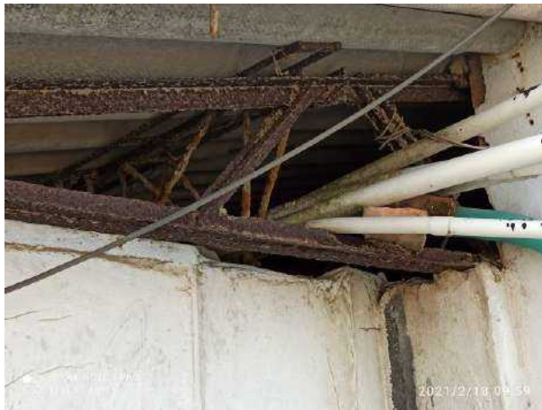
F-32. La exposición de los elementos metálicos a la intemperie ha provocado su oxidación. Se evidencia manejo improvisado en la instalación de tuberías. Desprendimiento de material de acabado de muros.
