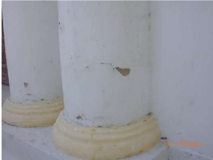
F-8. Se presentan fisuras y pérdida de material de recubrimiento de columnas. Acumulación de partículas ensuciantes en la superficie.
