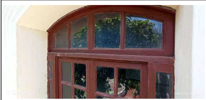
F-14. La carpintería se encuentra deteriorada, por desgaste propio del material y falta de mantenimiento periódico. Se evidencia suciedad en elemento de madera y en vidrios.
