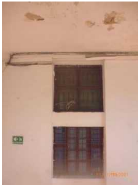
F-56. Perdida de material en la superficie de elementos metálicos. Desprendimiento de material de cielo raso por humedad en placa superior. Cableado y tuberías sobrepuesta sobre muro.
