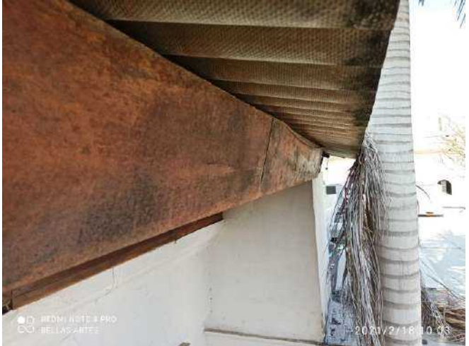
F-36. Se presenta deterioro en los elementos de madera por exposición a la intemperie. La cercanía de una de las especies vegetales amenaza la integridad del inmueble. Se observan grietas en el material de cavado de muros.
