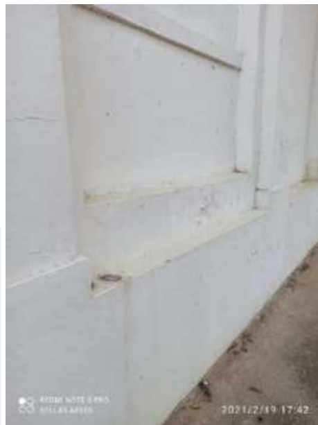
F-25. Se evidencian filtraciones por empozamiento de agua lluvia en la placa superior, presencia de moho y plantas superficiales por concentración de humedad.
