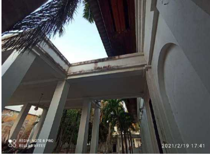
F-23. Se evidencian filtraciones por empozamiento de agua lluvia en la placa superior, esto sumado a la acumulación de partículas sobre la superficie ha generado escurrideros sucios.
