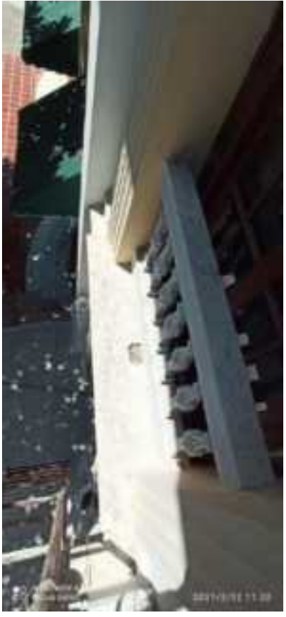
F-14. La carpintería se encuentra deteriorada, por desgaste propio del material y falta de mantenimiento periódico. Se evidencia suciedad en elemento de madera y en vidrios.
