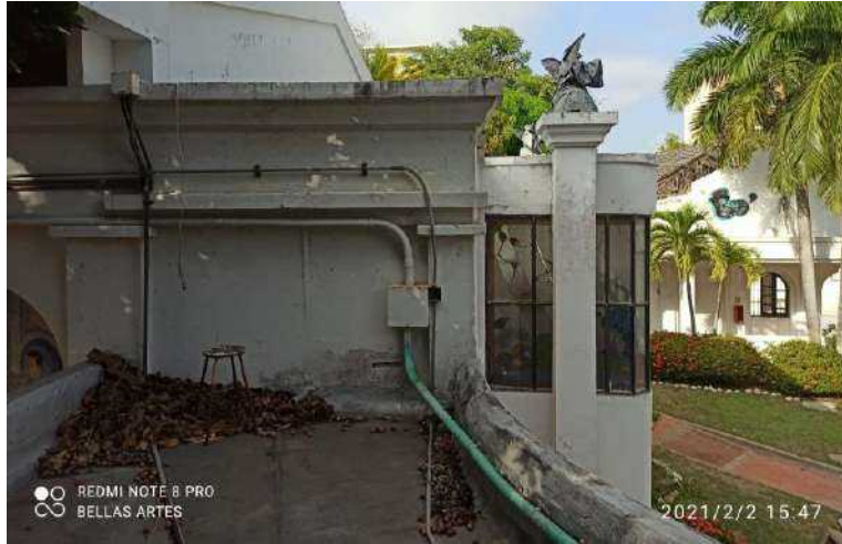
F-45. Acumulación de basura en la placa superior que protege las escaleras. Perdida de material superficial por desgaste. Deposito de partículas sobre la superficie exterior generando escurrideros sucios. Deterioro de acabados de muros debido a la exposición a la intemperie.
