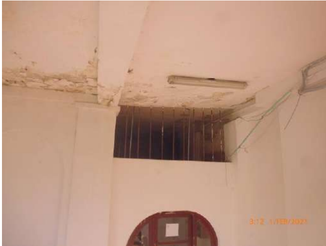
F-56. Perdida de material en la superficie de elementos metálicos. Desprendimiento de material de cielo raso por humedad en placa superior. Cableado y tuberías sobrepuesta sobre muro.
