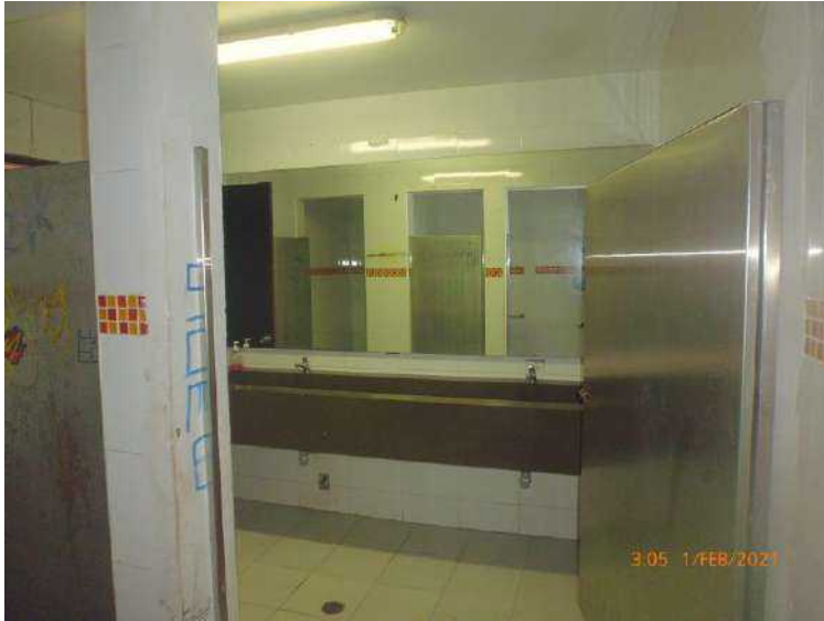
F-114. Se observa grafitado en muros y puertas. Manchas de suciedad por ausencia de mantenimiento periódico.
