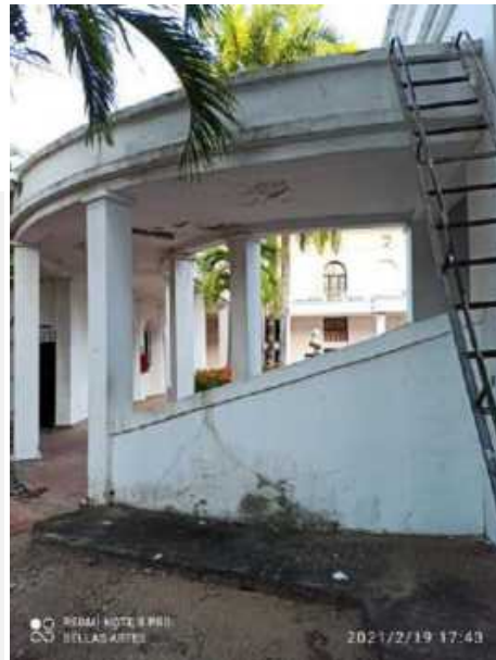
F-23. Se evidencian filtraciones por empozamiento de agua lluvia en la placa superior, esto sumado a la acumulación de partículas sobre la superficie ha generado escurrideros sucios.
