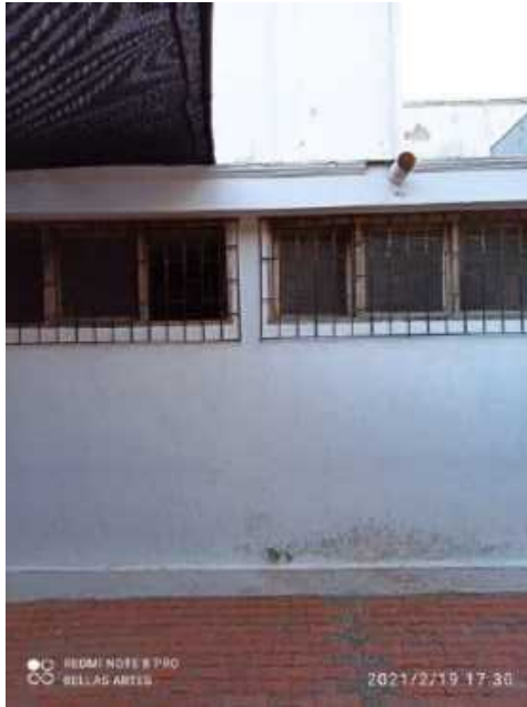
F-27. Se evidencia pérdida de material superficial en los elementos metálicos y desgaste de la carpintería de madera. Desprendimiento de materiales de acabado y pérdida de material en las cornisas.
