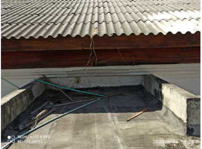
F-35. Se evidencian manchas de moho por humedades, por posible empozamiento de agua lluvia sobre la placa. Acumulación de residuos y falta de mantenimiento.
