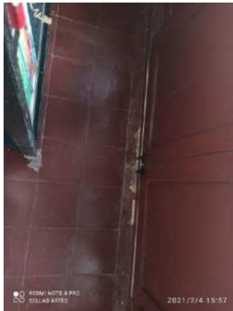
F-98. Se evidencia desgaste en bordes de piezas de enchape de pisos, alguna de estas se encuentran fracturadas.
