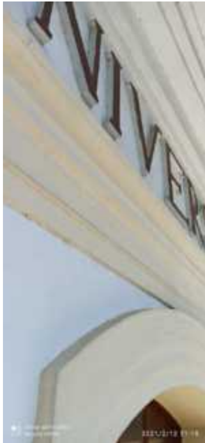
F-10. Se evidencia perdida de material superficial de cornisas por efectos del viento y partículas.
