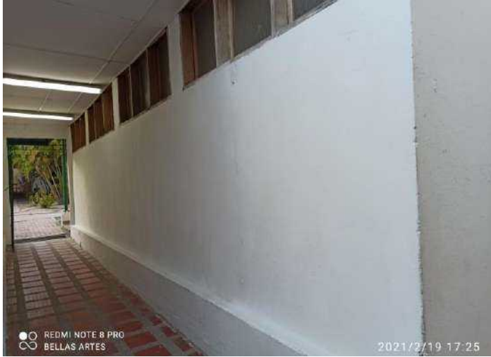
F-59. Se presenta humedad por capilaridad ascendente y desprendimiento de material de acabado de muros. La carpintería evidencia manchas de humedad y los paneles del cielo raso están sueltos. Se ha generado suciedad por depósito de partículas en la superficie.
