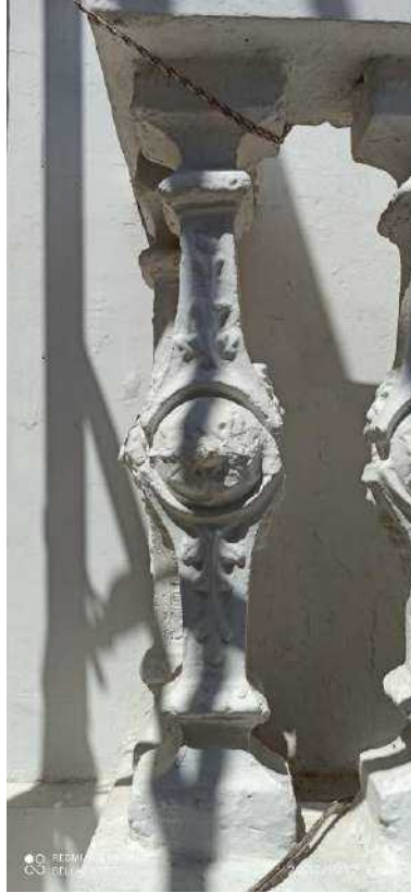
F-17. Se observa pérdida de material superficial en los balaustres, deterioro en los mismos por exposición a la intemperie, acumulación de partículas de suciedad y falta de mantenimiento. Se evidencian fisuras en material de acabados de muros.
