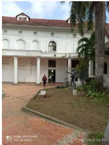
F-32. Se observa desprendimiento de acabado en placa superior y en muros. La carpintería en madera se encuentra afectada. Presencia de manchas y suciedad por falta de mantenimiento.
