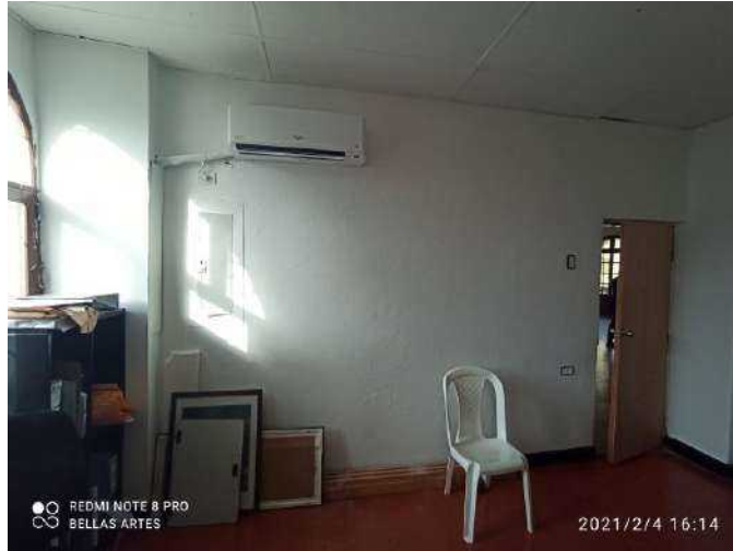
F-128. Se presentan intervenciones improvisadas para la instalación y funcionamiento de aparatos técnicos. Fisuras en material de acabado de muros.
