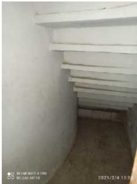
F-76. Se observa deterioro en los elementos de madera por desgaste propio del material y falta de mantenimiento. Se presentan fisuras en material de acabado de cielo rasos y muros.
