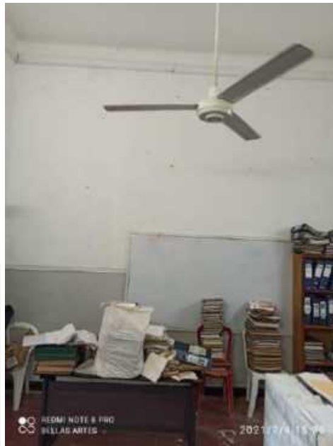
F-120. Se presentan mancha y suciedad en muros por acumulación de elementos y falta de mantenimiento. Se evidencian mancha de material de acabado de muros y cielo rasos.
