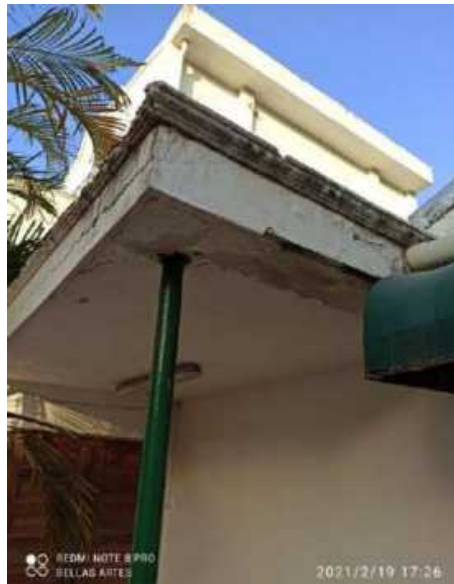
F-59. Se presenta humedad por capilaridad ascendente y desprendimiento de material de acabado de muros. La carpintería evidencia manchas de humedad y los paneles del cielo raso están sueltos. Se ha generado suciedad por depósito de partículas en la superficie.
