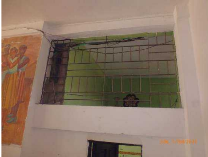
F-50. Perdida de material en la superficie de elementos metálicos. Cableado sobrepuesto sobre los muros sin ningún tipo de manejo técnico.
