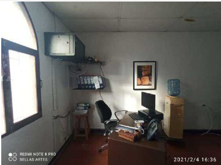
F-135. Se presentación alteraciones en el muro por cuenta de instalaciones técnicas sobrepuestas. Evidencia de humedad en paneles del cielo raso.
