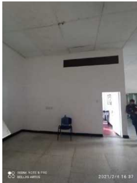
F-140. Se presenta deterioro en paneles de cielo raso y es notable de desgaste del material de acabado de pisos.
