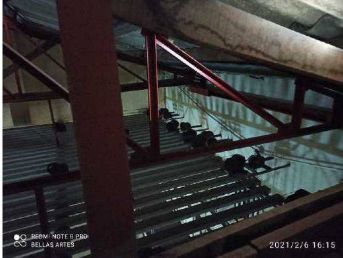
F-84. Se evidencias manchas de humedad en los elementos estructurales de madera, por posibles filtraciones de agua a través de la cubierta
