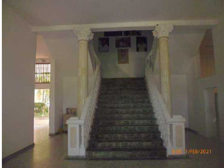
F-58. Sobre el hall de acceso se encuentra una amplia escalera con pisos de laja Tayrona. Se evidencia un bajo grado de deterioro en el acabado. Fisuras en muros y cielo raso.
