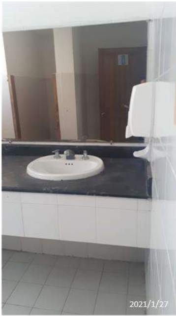
F-112. El baño para mujeres localizado en la zona de camerinos, cuenta con un sanitario y dos lavamanos. Teniendo en cuenta que sirve a ocho camerinos individuales y uno de grupo se considera insuficiente.
