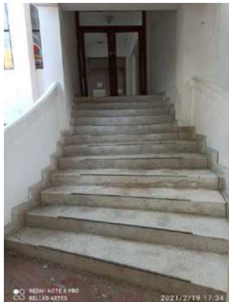
F-13. Presencia de fisuras en antepechos y grietas en la escalera. Desprendimiento de material de acabado y manchas por suciedad.
