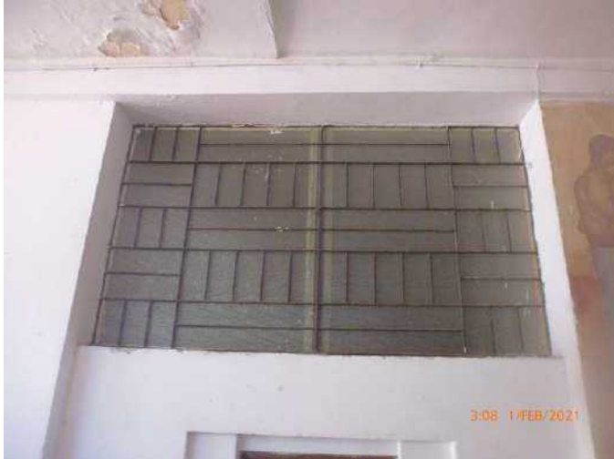
F-52. Perdida de material en la superficie de elementos metálicos. Desprendimiento de material de recubrimiento de cielo raso por humedad en placa superior. Corrosión en elementos metálicos.
