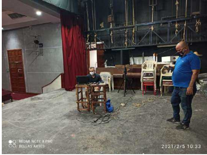
F-81. Se observa un alto grado de deterioro en el piso del escenario por pérdida de material superficial debido al roce constante y a la ausencia de mantenimiento periódico.
