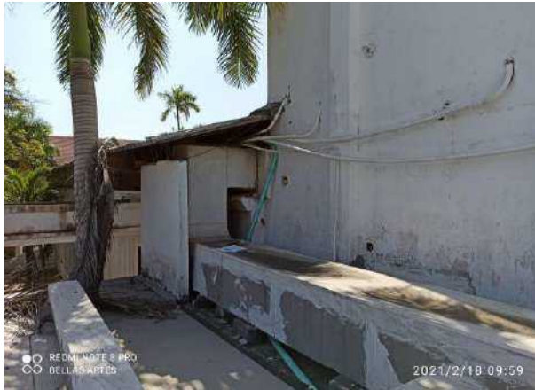
F-31. Se observan manchas de humedad y desprendimiento de material de acabado por exposición de muros a la intemperie. Se han realizado intervenciones en el muro por cuenta de instalaciones superficiales, lo que ha generado deterioro del mismo. Acumulación de depósitos de suciedad y residuos de arboles, lo que generan empozamientos de agua lluvia. Carencia de mantenimiento.
