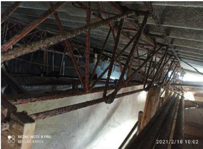
F-34. Se presenta oxidación en los elementos que conforman la estructura metálica, así mismo desprendimiento de material de acabado de muros.
