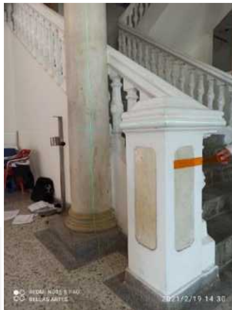
F-62. Algunas piezas del acabado de piso presentan fisuras. Se presentan manchas de humedad y suciedad en muros.
