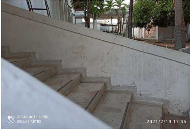
F-13. Presencia de fisuras en antepechos y grietas en la escalera. Desprendimiento de material de acabado y manchas por suciedad.
