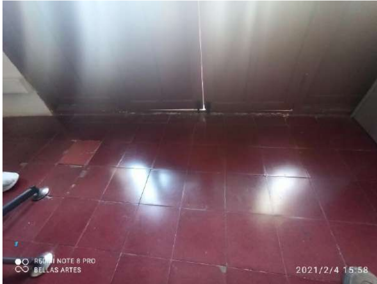
F-98. Se evidencia desgaste en bordes de piezas de enchape de pisos, alguna de estas se encuentran fracturadas.
