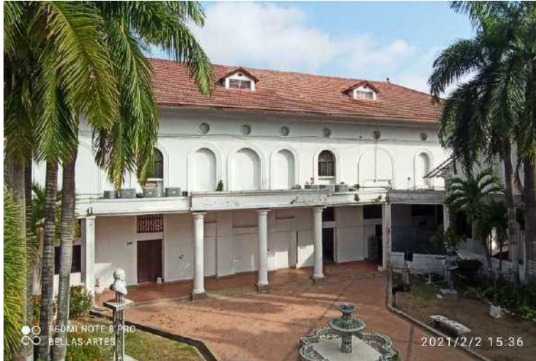
F-32. Se observa desprendimiento de acabado en placa superior y en muros. La carpintería en madera se encuentra afectada. Presencia de manchas y suciedad por falta de mantenimiento.
