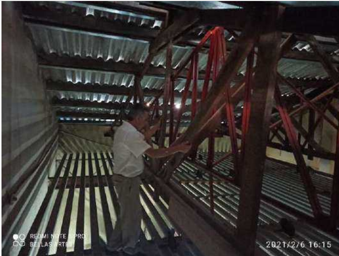
F-85. La parrilla esta conformada por una serie de perfiles metálicos apoyados en vigas de acero, estos perfiles presentan deficiencia en su comportamiento estructural, debido a que se flectan con el peso de la carga viva.
