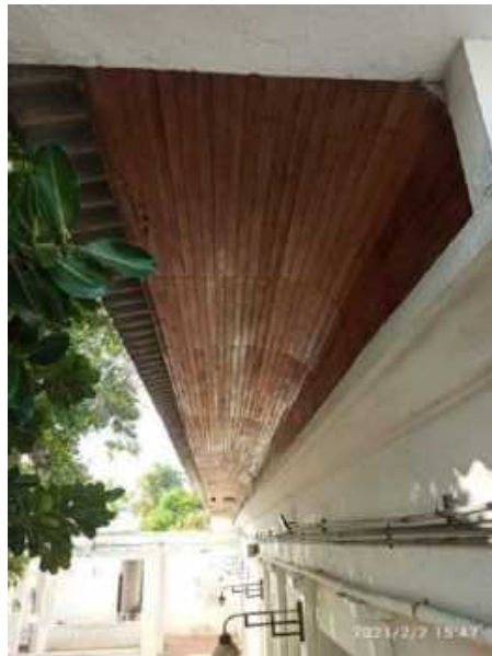
F-45. Acumulación de basura en la placa superior que protege las escaleras. Perdida de material superficial por desgaste. Deposito de partículas sobre la superficie exterior generando escurrideros sucios. Deterioro de acabados de muros debido a la exposición a la intemperie.
