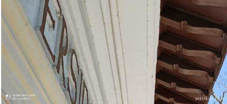
F-10. Se evidencia perdida de material superficial de cornisas por efectos del viento y partículas.
