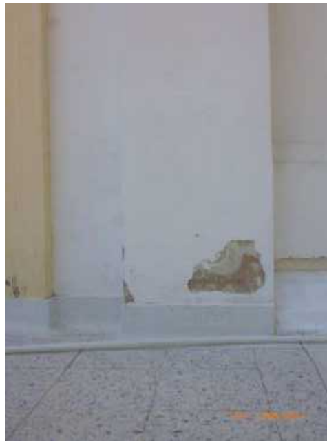
F-8. Se presentan fisuras y pérdida de material de recubrimiento de columnas. Acumulación de partículas ensuciantes en la superficie.
