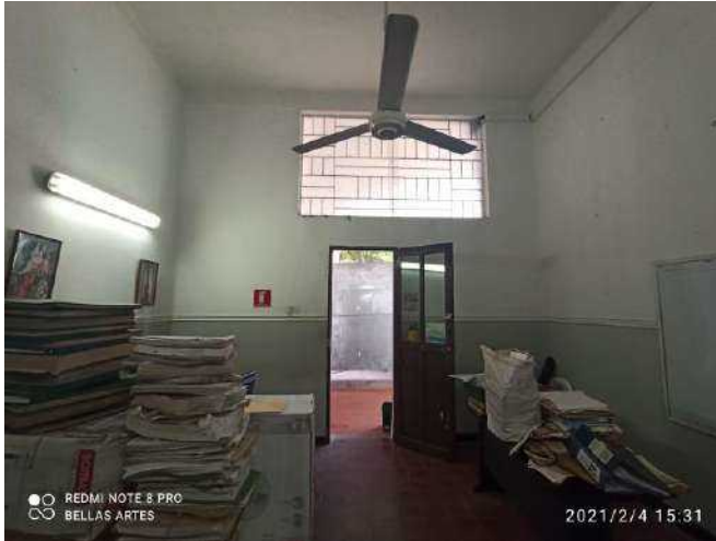
F-120. Se presentan mancha y suciedad en muros por acumulación de elementos y falta de mantenimiento. Se evidencian mancha de material de acabado de muros y cielo rasos.
