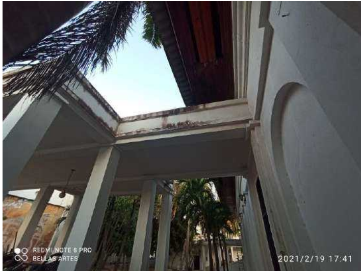
F-25. Se evidencian filtraciones por empozamiento de agua lluvia en la placa superior, presencia de moho y plantas superficiales por concentración de humedad.
