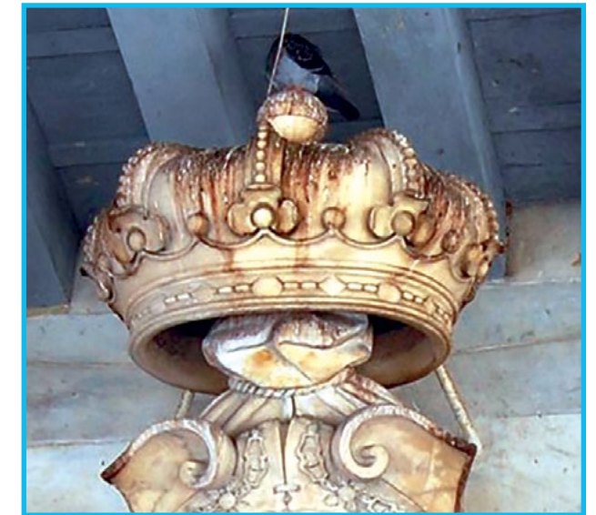
Fig. 78: Presence of soluble salts in the stone. Palacio del Segundo Cabo
