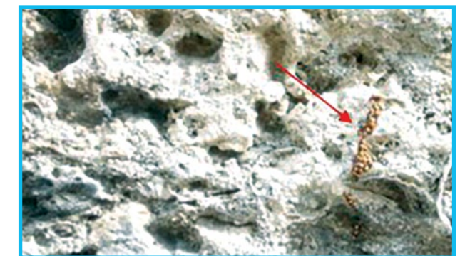
Fig. 68: Costra depositada en la superficie. Palacio del Segundo Cabo
