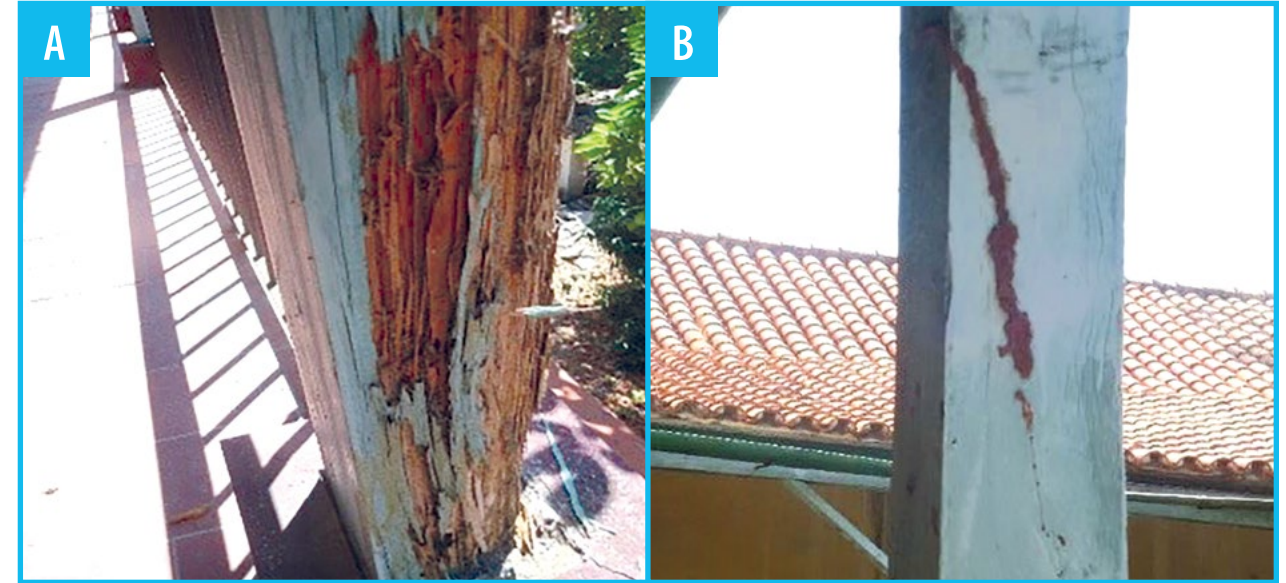
Fig. 36 (A y B): Desfibramiento producto del ataque de termitas subterráneas, pie derecho. Convento de Santa Clara de Asís
