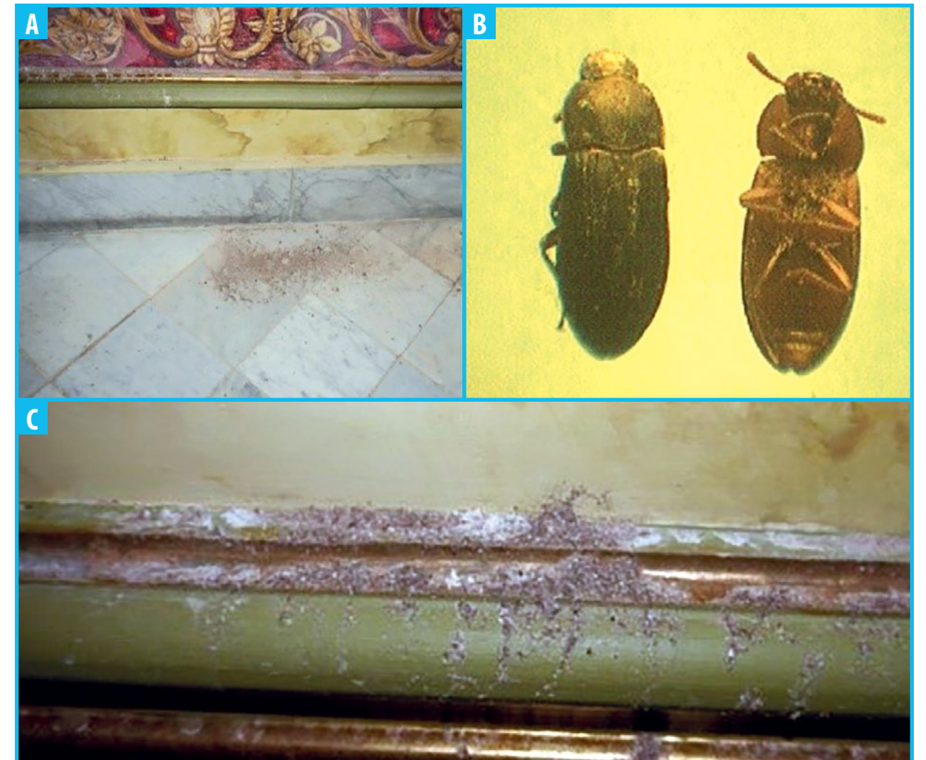
Fig. 158: Ataque de anóbidos en Salón del Trono del Palacio de los Capitanes Generales. A: Cúmulo de fragmentos originados por los anóbidos en el piso del local. B: Adulto de anóbido. C: Galerías de anóbidos en la moldura protectora.
