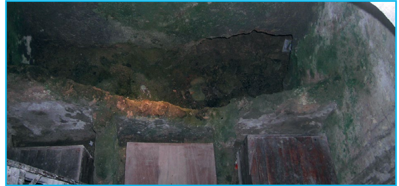
Fig. 163: Crecimiento de algas y cianobacterias en el nicho de la Basílica de San Francisco de Asís
