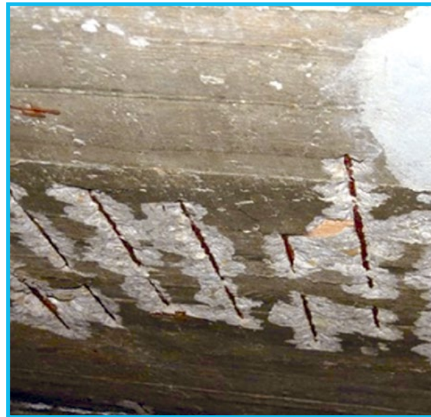
Fig. 106: Ladrillo expuesto y erosionado en fachada
