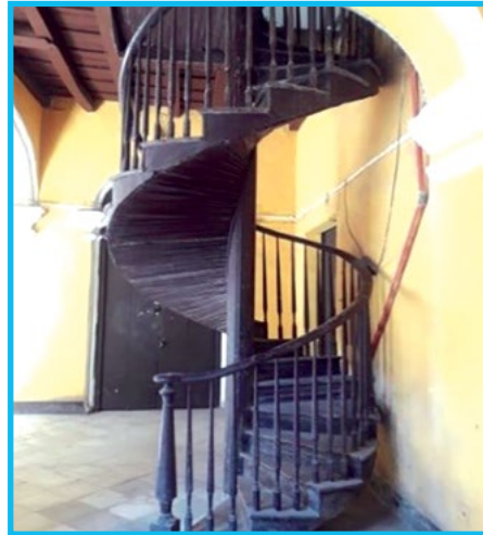
Fig. 5: Escalera de madera helicoidal. Restaurante La Mina
