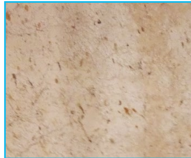
Fig. 169: Excretas de murciélagos afectando los muros del coro alto del Convento de Santa Clara de Asís
