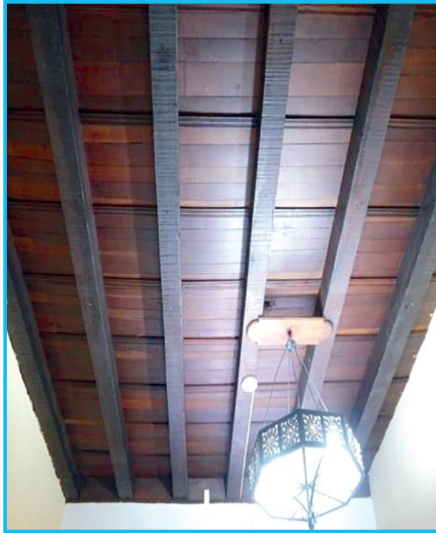
Fig. 11: Ejemplo de techo de viga y tabla. Muralla No. 60
