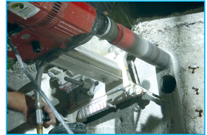
Fig. 136: Proceso de extracción de probetas en viga de hormigón armado. Convento de Santa Clara de Asís
