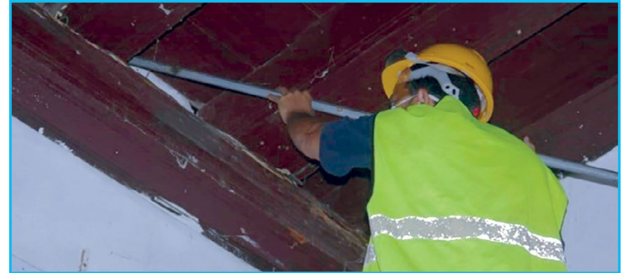
Fig. 14: Realización del sondeo de los elementos de madera con el punzón graduado
