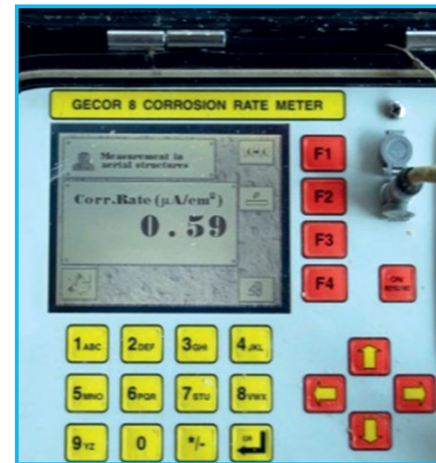
Fig. 137: Medición de corrosión activa con GECOR 8. Edificio Santo Domingo
