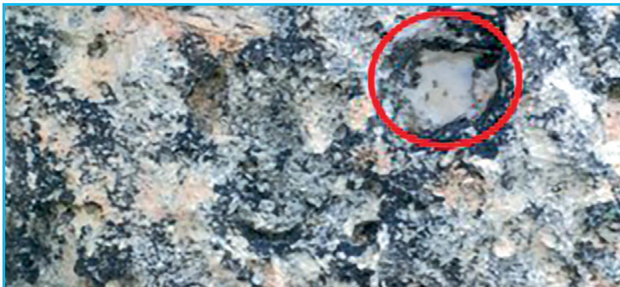
Fig. 77: Presence of soluble salts in the stone. Palacio del Segundo Cabo
