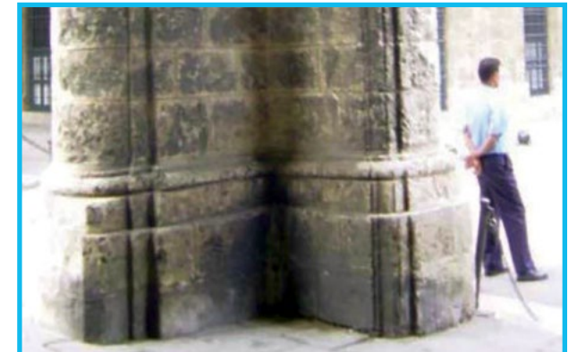
Fig. 90: Columna de fachada, cara interna, con acumulación de costras negras
