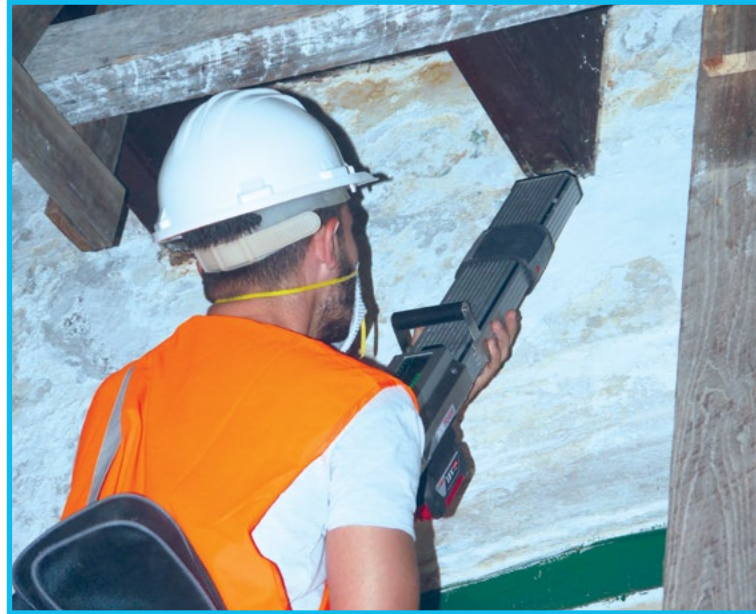
Fig. 20: Resistografía en vigas de madera. Restaurante La Mina
