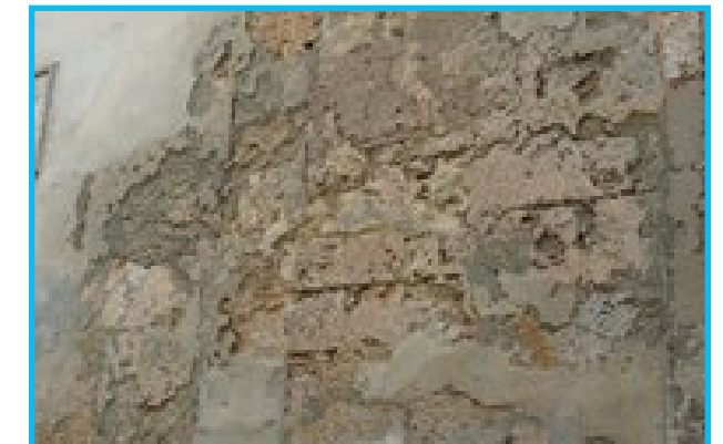
Fig. 72: Desprendimiento de la piedra por acción del agua. Catedral de La Habana
