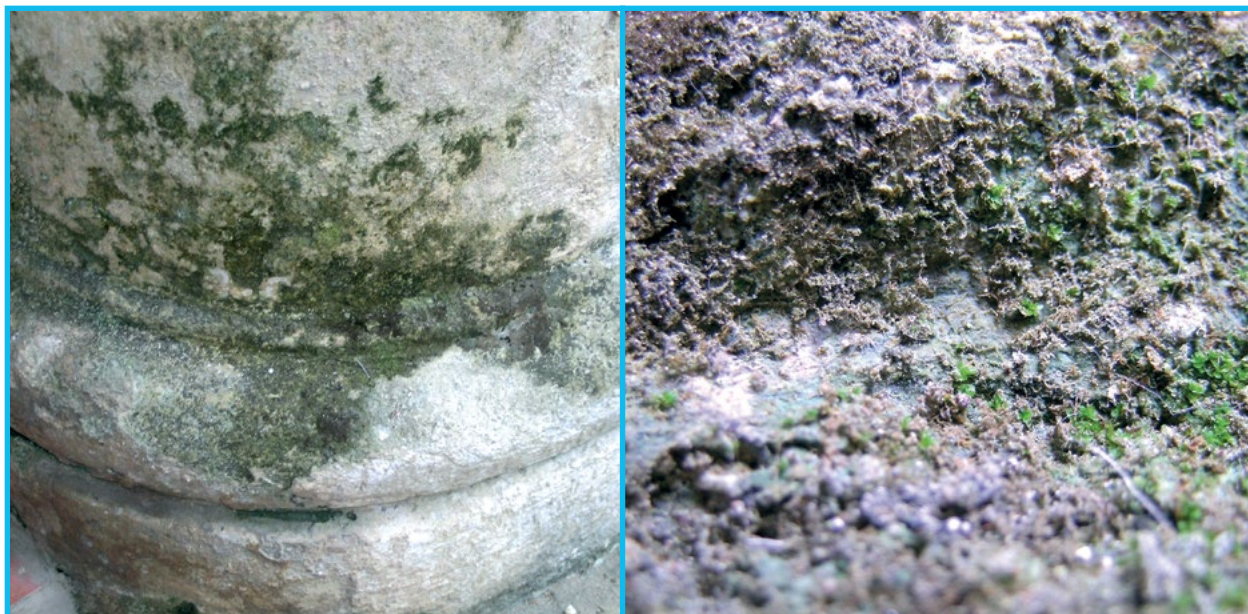
Fig. 162: Biopelícula en la base de una columna. Casa Simón Bolívar
