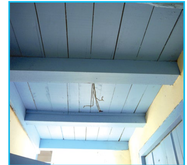
Fig. 2: Dintel de madera. Obra: Mi Casita Colonial
