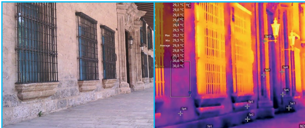
Fig. 96: Segunda línea de fachada, entrada principal
