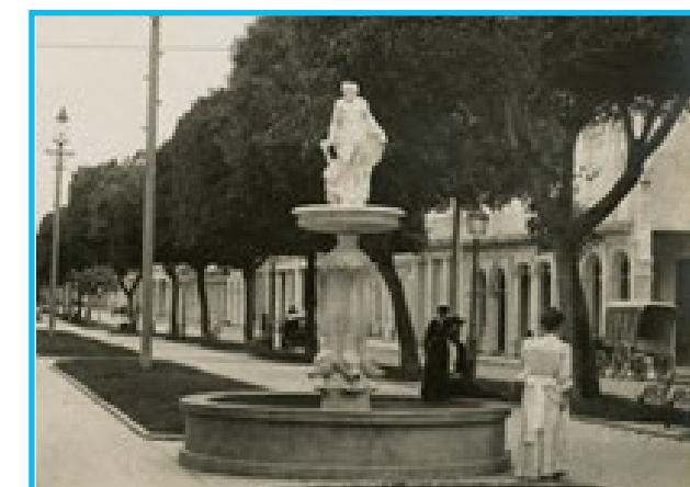
Fig. 61: Fuente de Neptuno. Escultura de piedra y mármol. Paseo del Prado, La Habana. Fuente: Centro de Documentación "Arq. Fernando Salinas", Restaura, OHCH.
