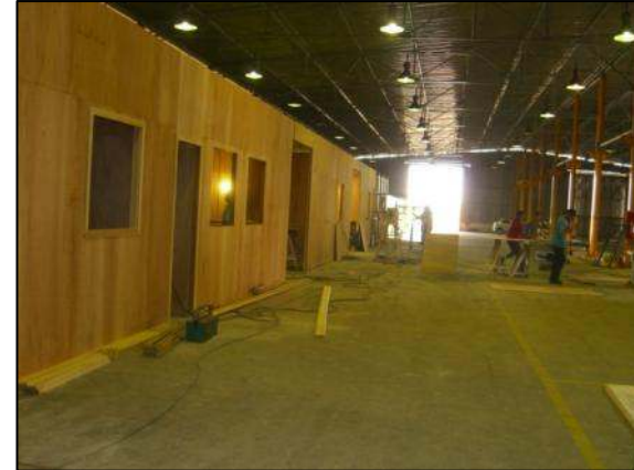
2006: Obras de Adequação
