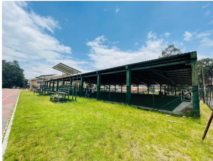
Foto 2. Vista general cancha sintética. Fuente: Elaboración propia
